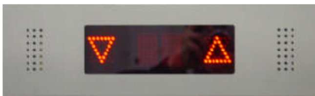
Figura 2.22: Exemplo de indicador de posição de patamar, com sentido de marcha
