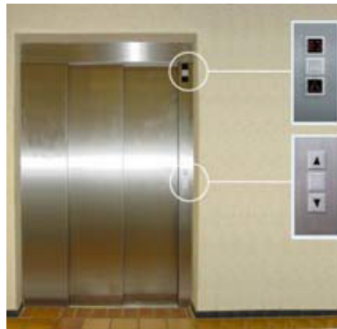
Figura 2.17: Porta de patamar, telescópica e de abertura central de 2 folhas
