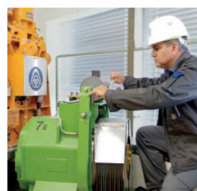
Figura 4.2: Intervenção de manutenção
