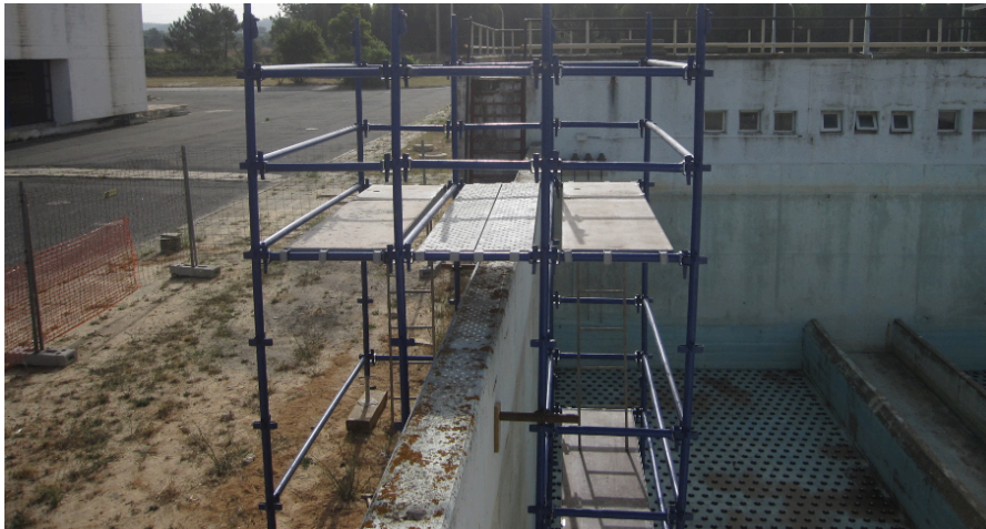
Figura 3.1 - Torre de acesso ao interior do tanque.
