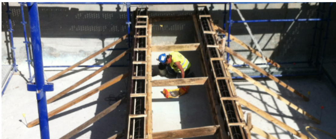
Figura 3.11 - Cofragem dos muretes.
