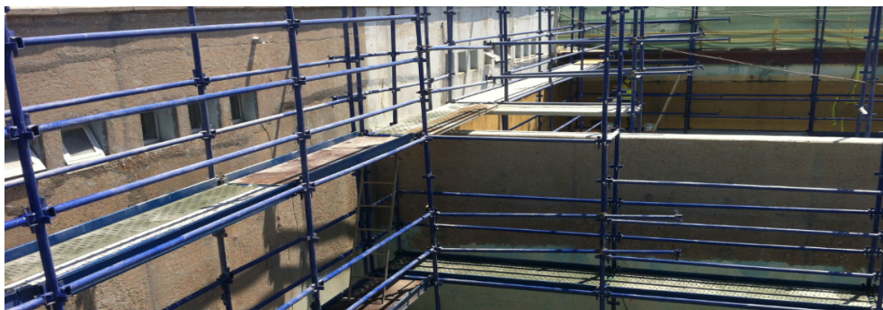
Figura 3.2 - Acesso entre tanques.
