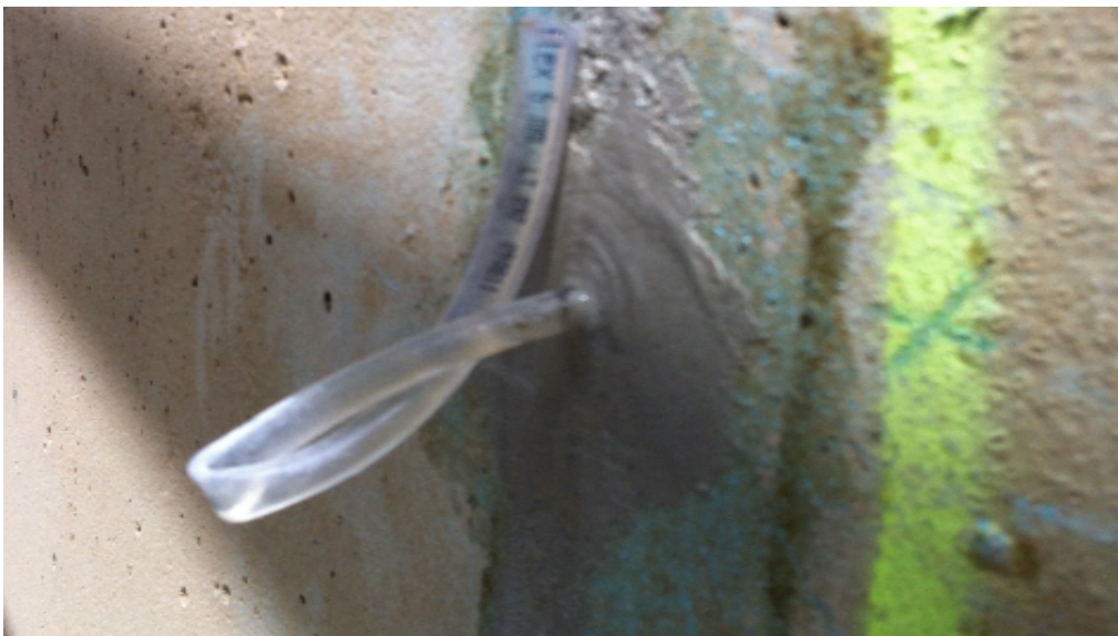
Figura 3.16 - Selagem de fissuras a injetar.
