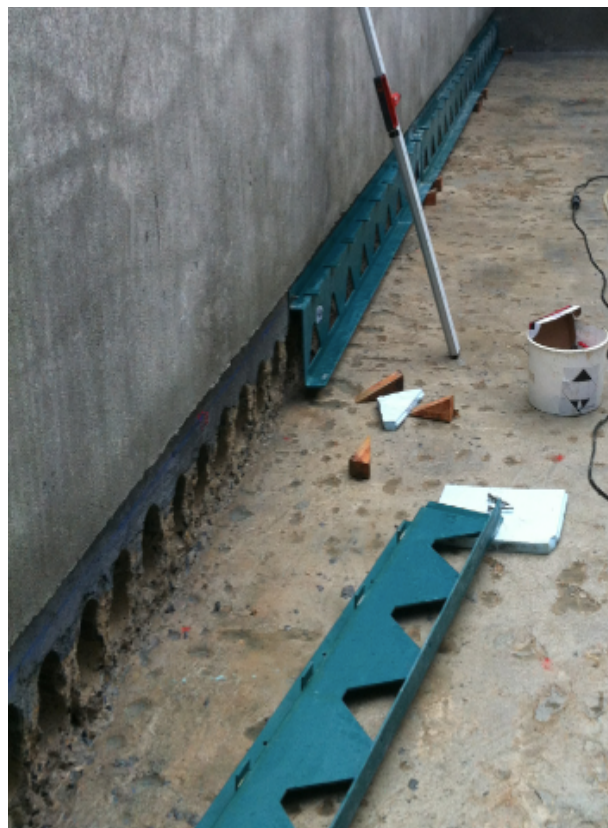
Figura 3.29 - Instalação das placas de distribuição.
