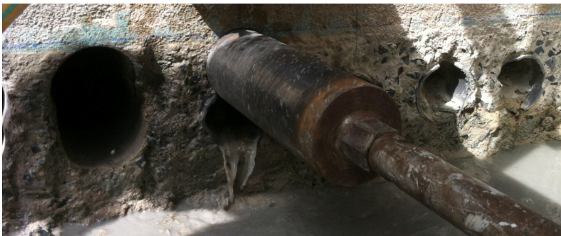
Figura 3.9 - Execução de carotes.
