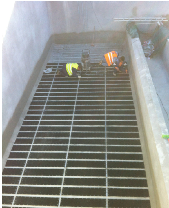
Figura 3.33 - Remoção da proteção e limpeza dos fundos falsos.
