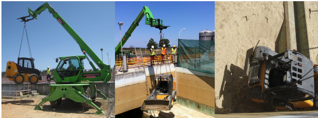
Figura 3.4 - Colocação da minicarregadora no interior do tanque.
