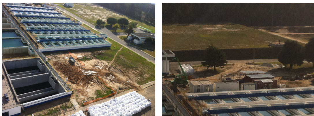
Figura 2.5 – (a) Vista do estaleiro norte e tanques de filtragem 1 e 2. (b) Vista do estaleiro sul.
