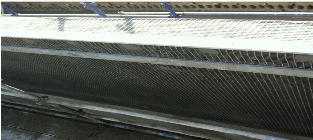
Figura 3.22 - Colocação de malha de carbono.
