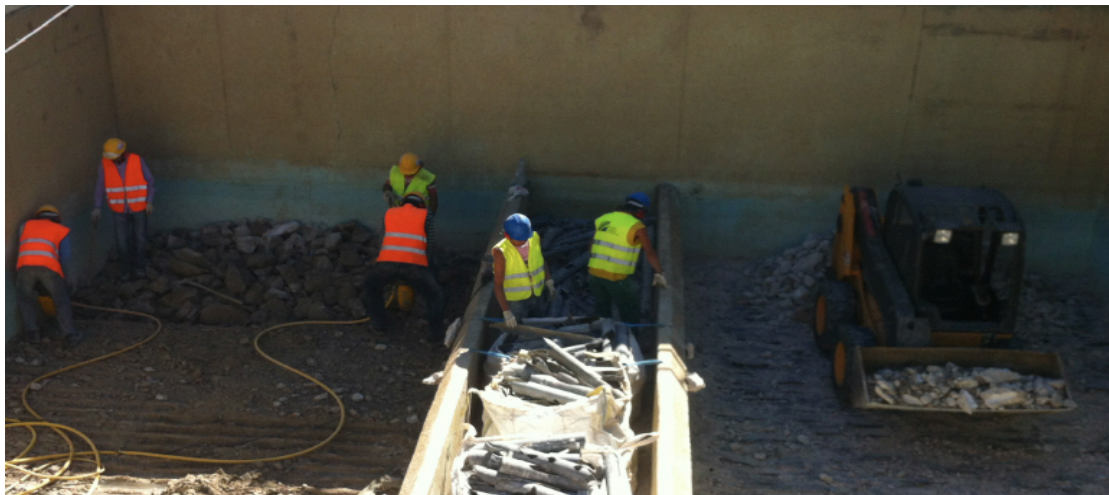
Figura 3.8 - Demolição e separação de resíduos.
