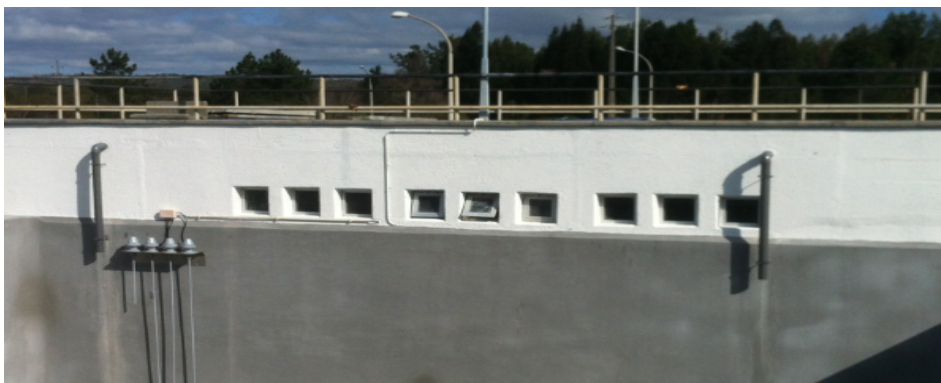
Figura 4.4 – Novos tubos de queda.
