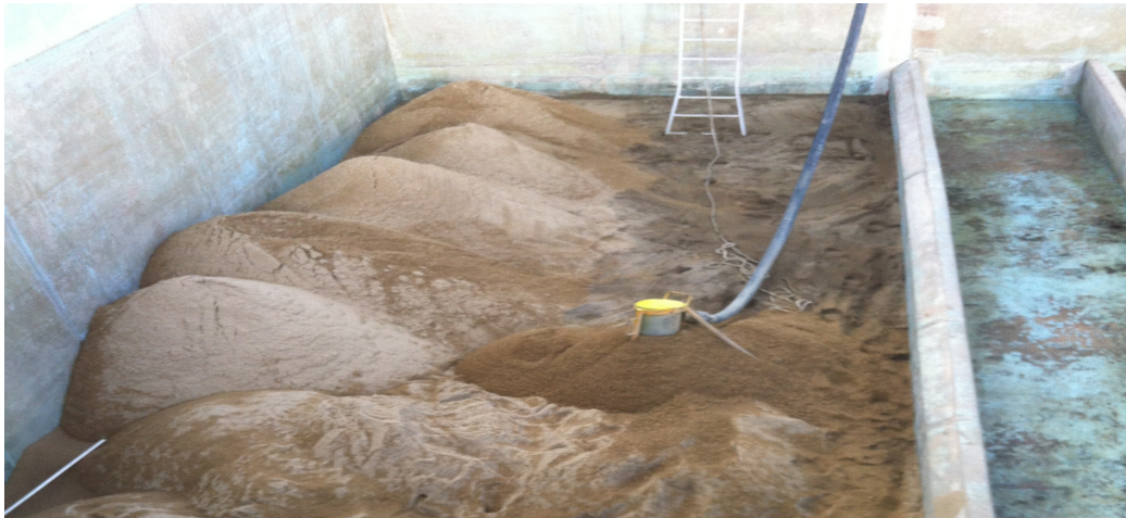
Figura 4.7 – Reposição do manto filtrante.
