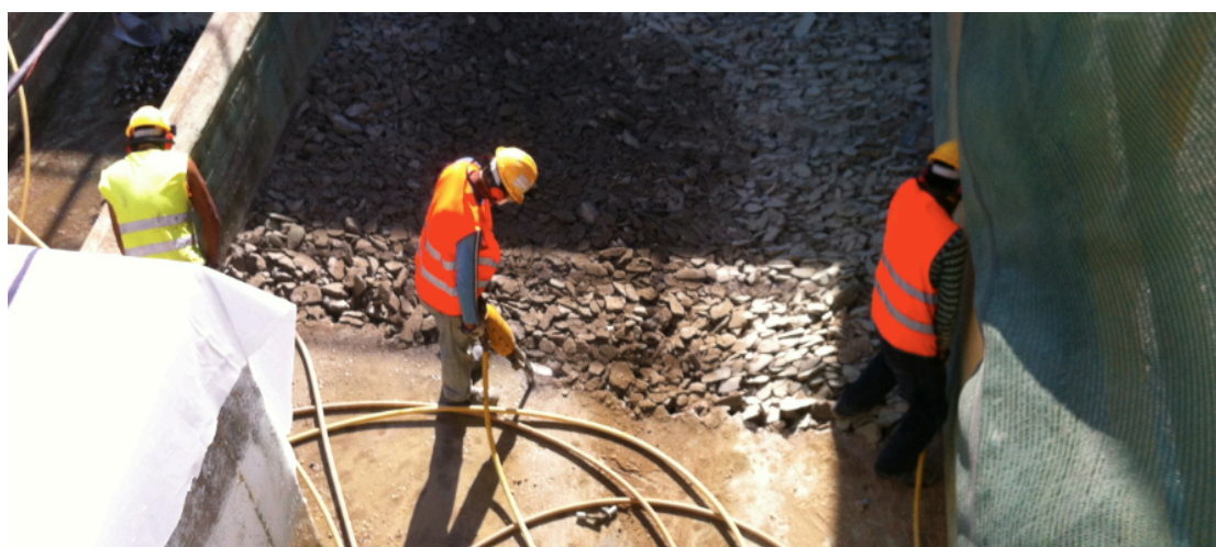
Figura 3.7 - Demolição da primeira camada.
