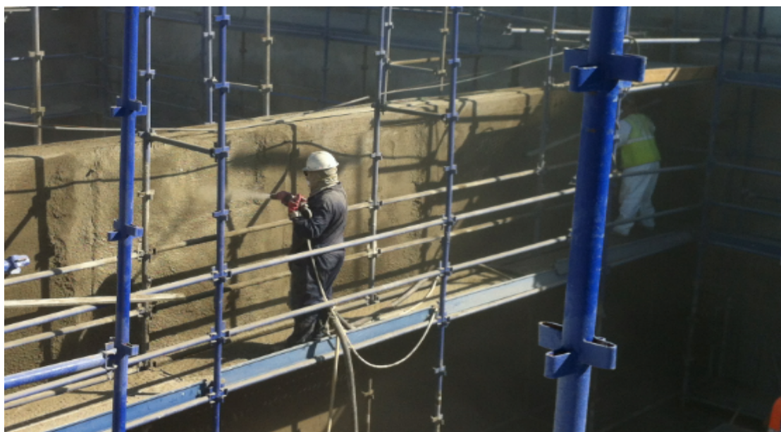
Figura 3.21 - Projeção de betão.
