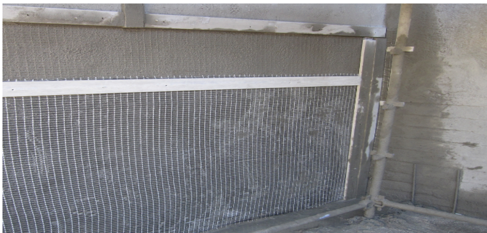
Figura 3.23 - Colocação de malha dupla.
