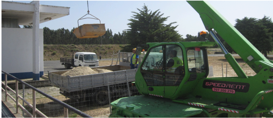
Figura 3.3 - Remoção da areia.
