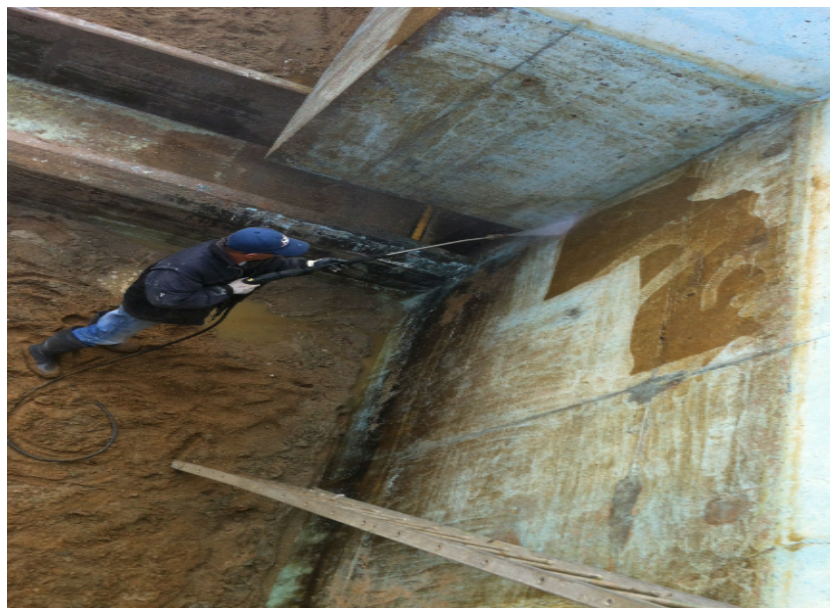
Figura 4.6 - Remoção de detritos das paredes dos tanques.
