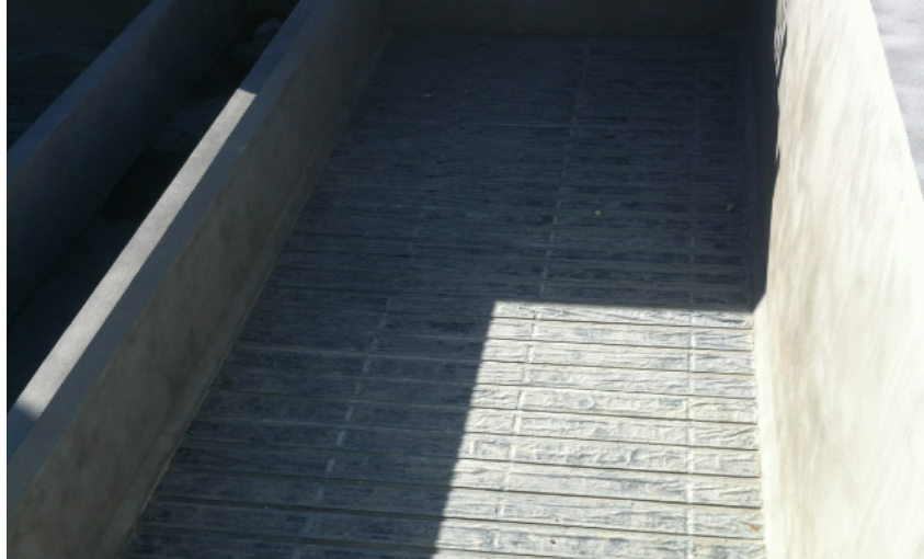
Figura 3.32 - Preenchimento do intervalo entre as fileiras.
