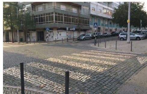
Figura 4.20 - Sobrelevação de uma passagem de peões em Almada [31]
