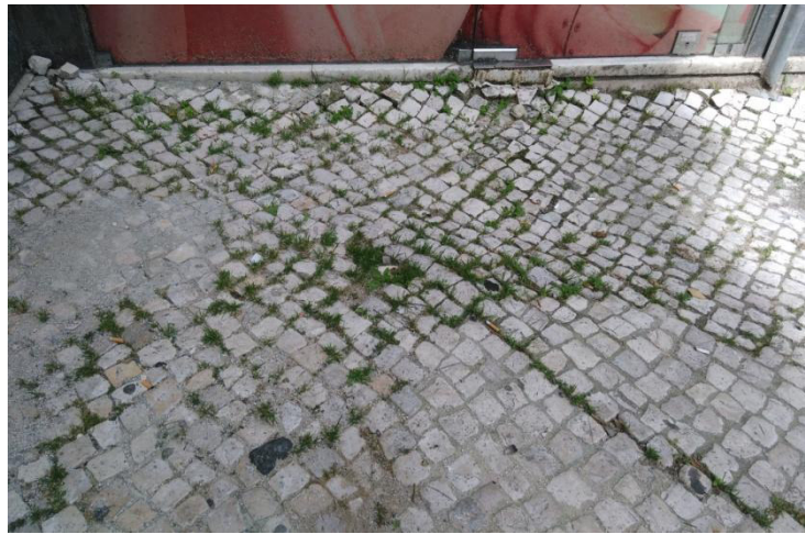
Figura 5.37 - Zona de retenção de água junto a edifícios
