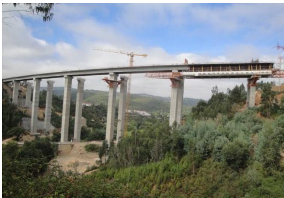
Figura 2.2 - Ponte sobre o rio Ceira (A13) [1]
