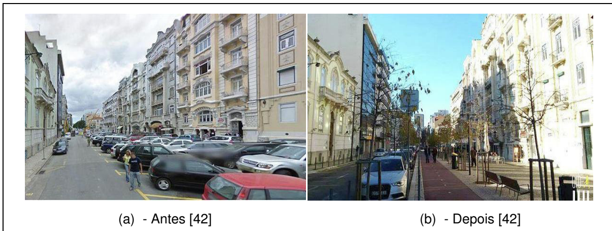
Figura 3.20 – Intervenção realizada na Avenida Duque D’Ávila, em Lisboa
