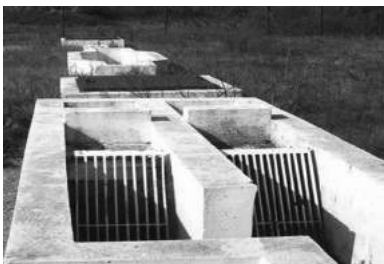
Figura 6.1 Grades de limpeza manual
