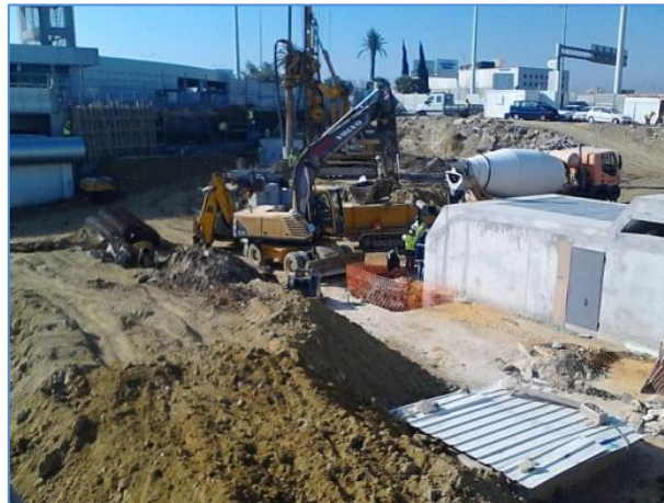
Imagem 19 - Estado inicial da zona do Miradouro.
