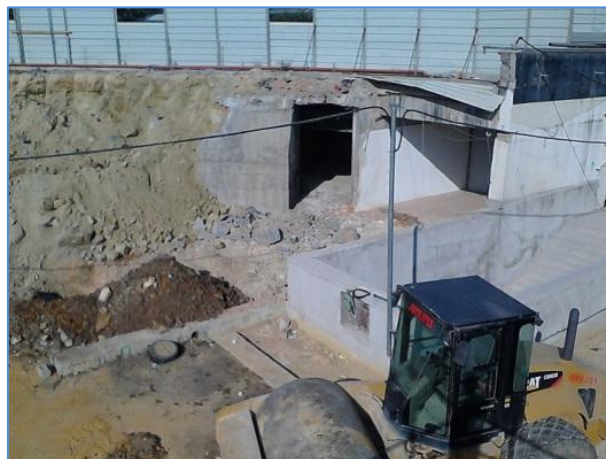
Imagem 20 - Estado inicial da zona do Núcleo de Acessos.
