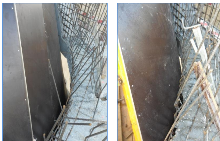
Imagem 15 - Cofragem da casca (Antes / Após).
