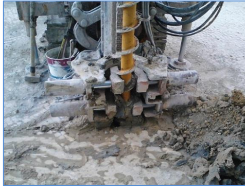
Imagem 8 - Furação da micro-estaca.
