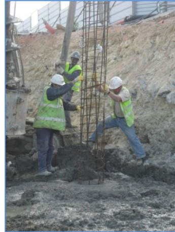
Imagem 6 - Inserção de armadura.
