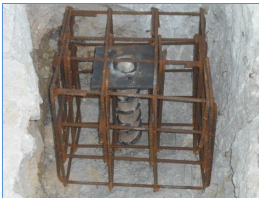
Imagem 12 - Soldadura da helicoidal e chapa de topo.
