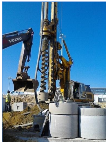
Imagem 4 - Betonagem da estaca.
