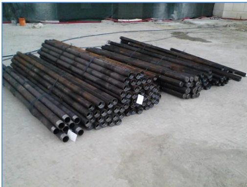
Imagem 9 - Armaduras da micro-estaca
