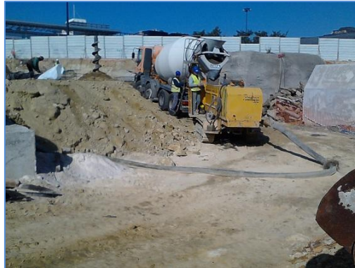
Imagem 3 - Bomba de betão.
