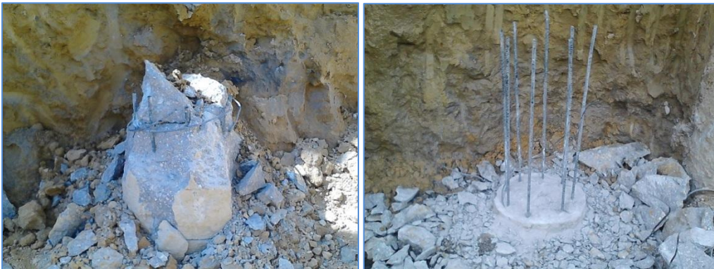
Imagem 7 - Saneamento da estaca (Antes / Após).
