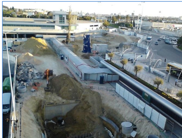
Imagem 13 - Túnel do RAC.
