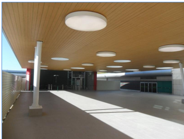
Imagem 27 - Ponto da situação ao final da 20ª semana (Cobertura metálica).
