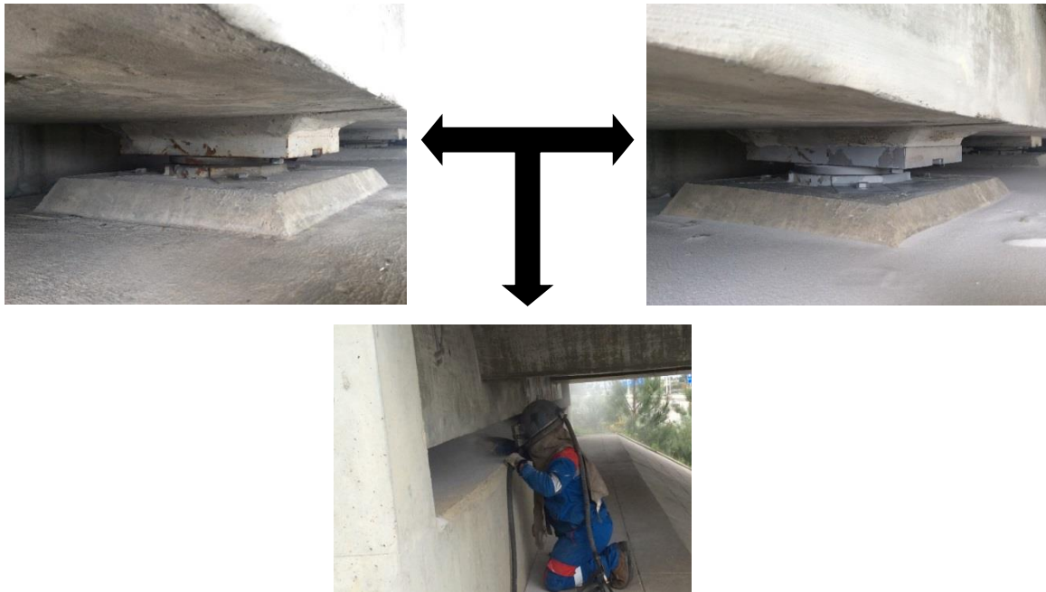
Figura 67 - Sistema de decapagem
