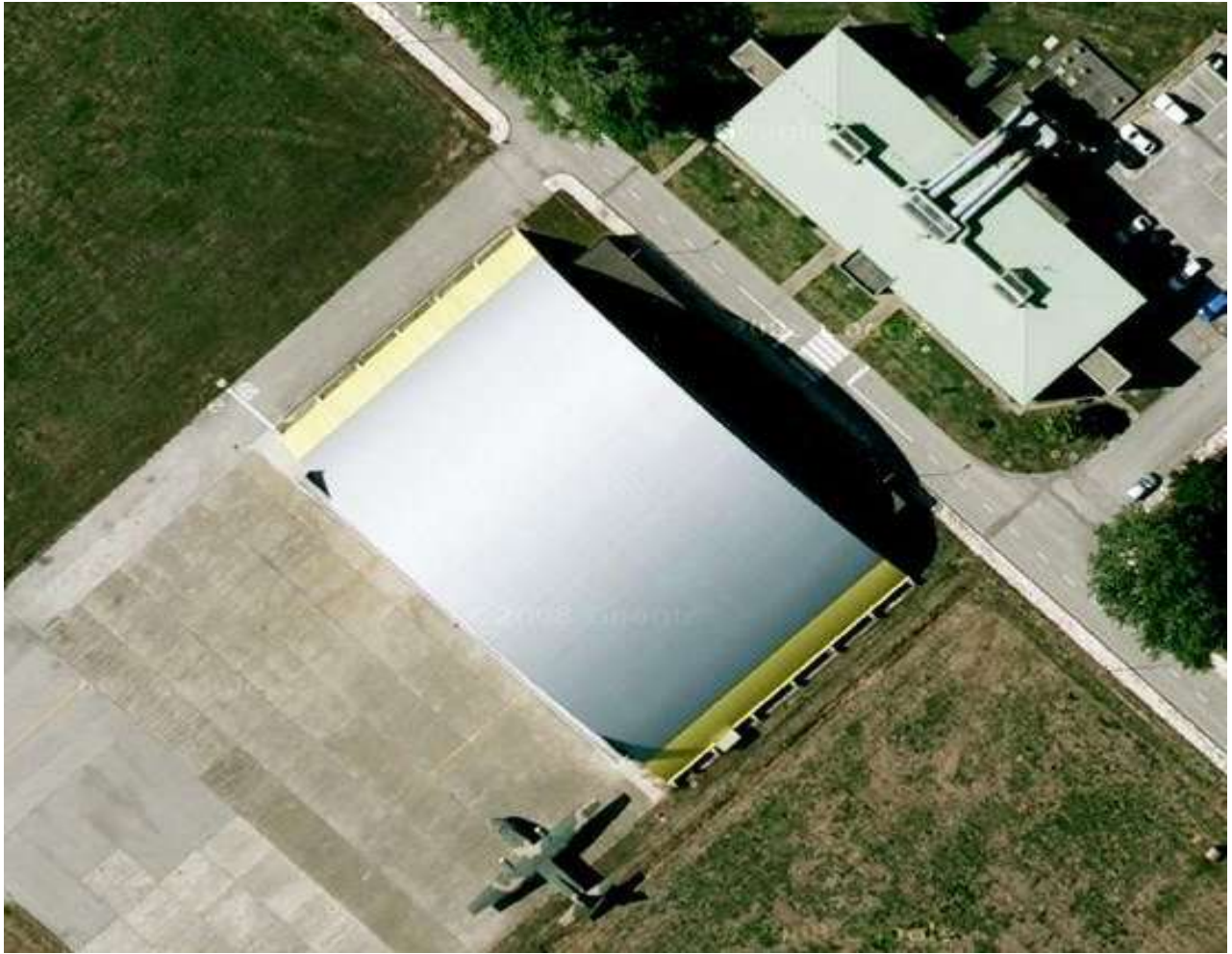
Figura 10: Hangar Principal da Manutenção da Esquadra 101 (site: www.googlemaps.pt , s/data).
