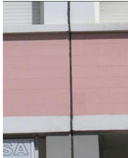
Fig. 9 – Exemplo de um RCA de fachada com uma junta estrutural
