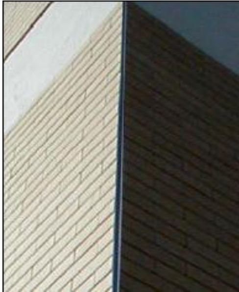
Fig.10 - Junta periférica em RCA de fachadas executadas em perfis de aço inox que protegem os cantos salientes
