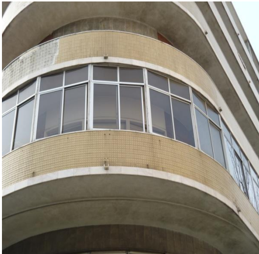
Destacamento na zona da curva
