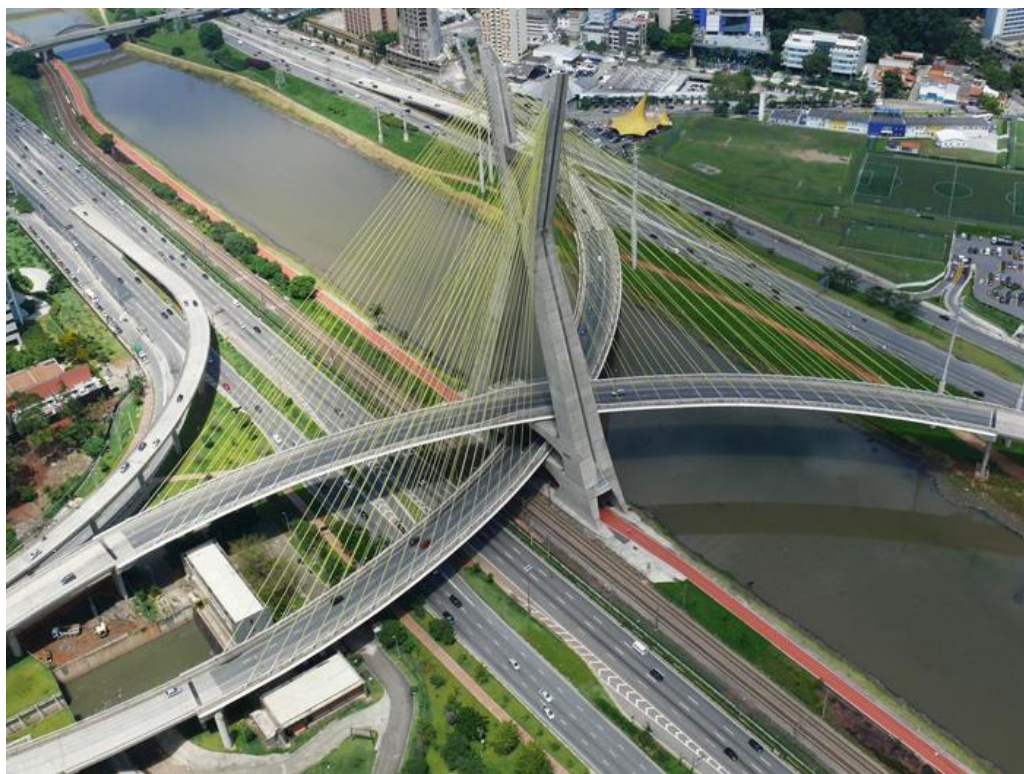
Figura 2.6 – Ponte Octávio Frias de Oliveira - Brasil
