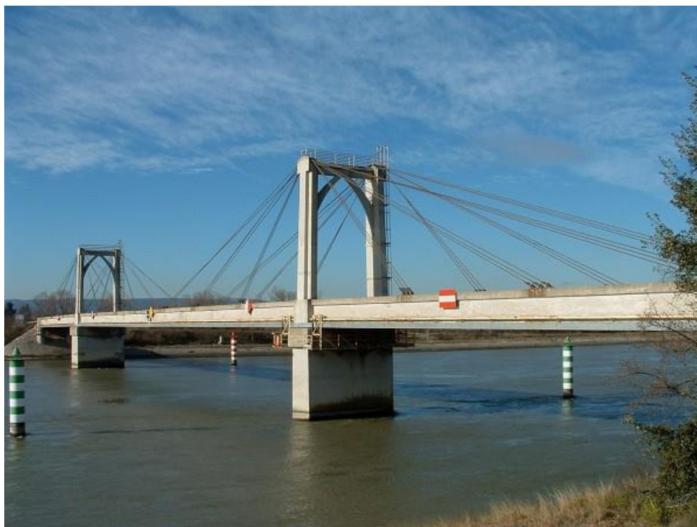
Figura 2.3 – Ponte de Donzère-Mondragon (Structurae, 2014)
