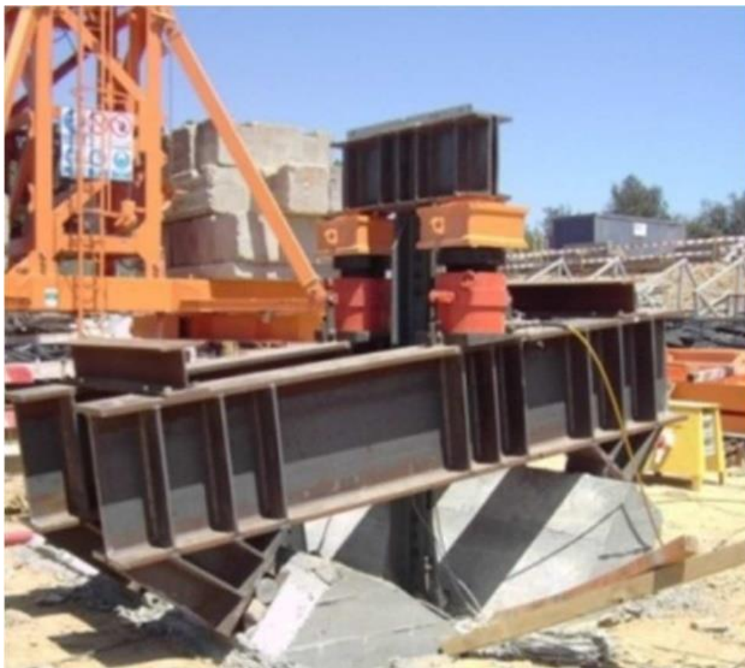
Figura 5.14 – Ensaio de ancoragem dentada em obra
