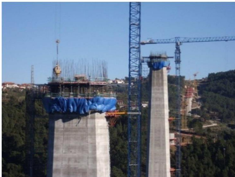
Figura 5.24 – Construção por deslize de cofragem
