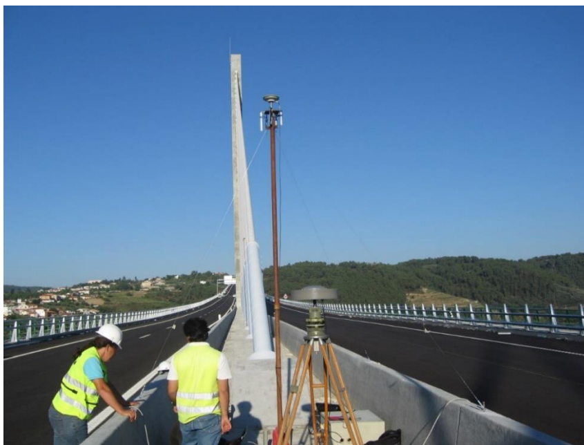
Figura 6.9 – Antenas GNSS: em primeiro plano, em cima dum tripé, a antena choque-ring da Topcon, em segundo plano a antena da Leica, montada no topo dum mastro bem espiado (Lima, Monitorização do Ensaio de Carga do Viaduto do Corgo com o GNSS)
