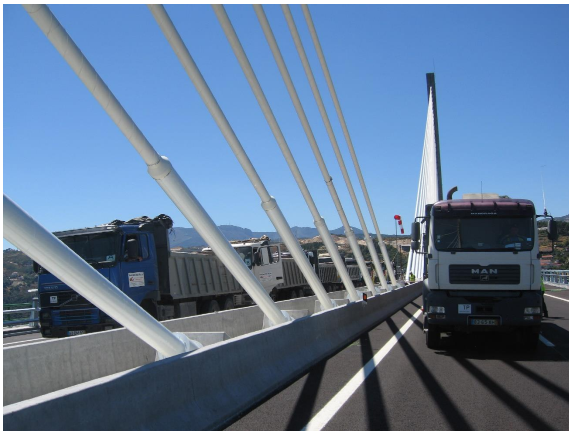
Figura 4.1 – Ensaio de carga do viaduto do Corgo
