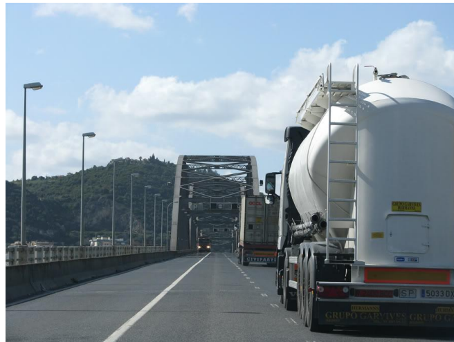
Figura CE.4.2 – Característica da iluminação actual (lanços dos acessos Nascente e Poente)
