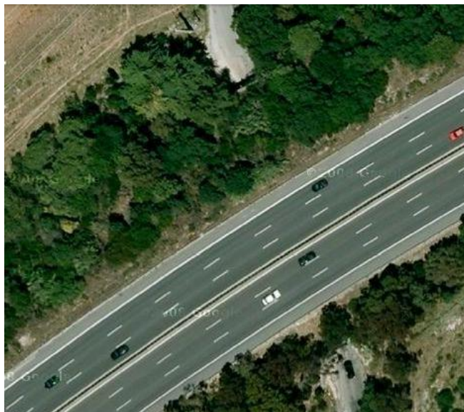
Figura CE.5.1 – Túnel sob a AE1, entre Vialonga e Póvoa de Santa Iria
