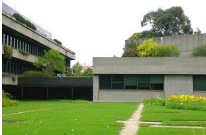
Figura 1-4 - Terraço verde na Fundação Calouste Gulbenkian em Lisboa.
