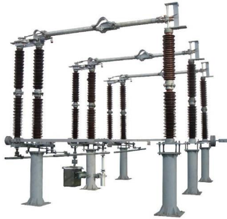
Figura 2.4 - Seccionadores de Linha
