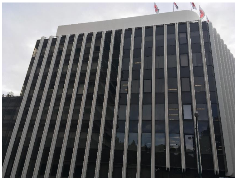
Figura 5.1.3- Vista da fachada principal na rua Actor Tasso (Fonte: Autora, 2017)
