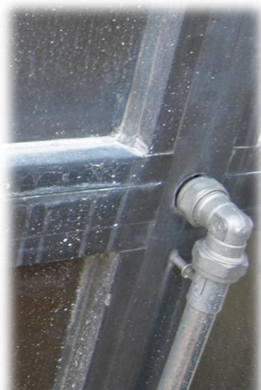
Figura 5.3.23. Abertura de orifícios na caixilharia (Reservado, 2016)
