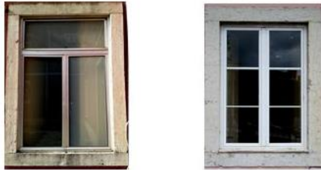
Figura 4.1.7. Exemplo de janelas com caixilharias em alumínio (Santos, 2012)
