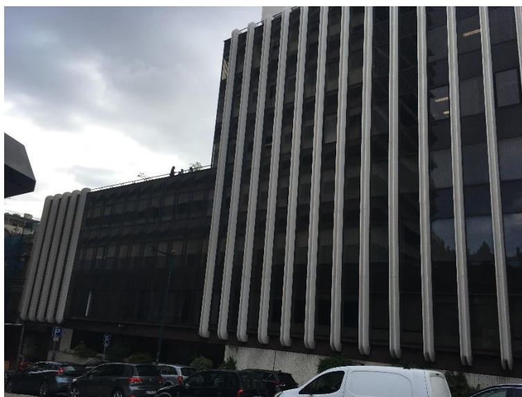
Figura 5.1.4. Vista da fachada principal na rua Actor Tasso (Fonte: Autora, 2017)
