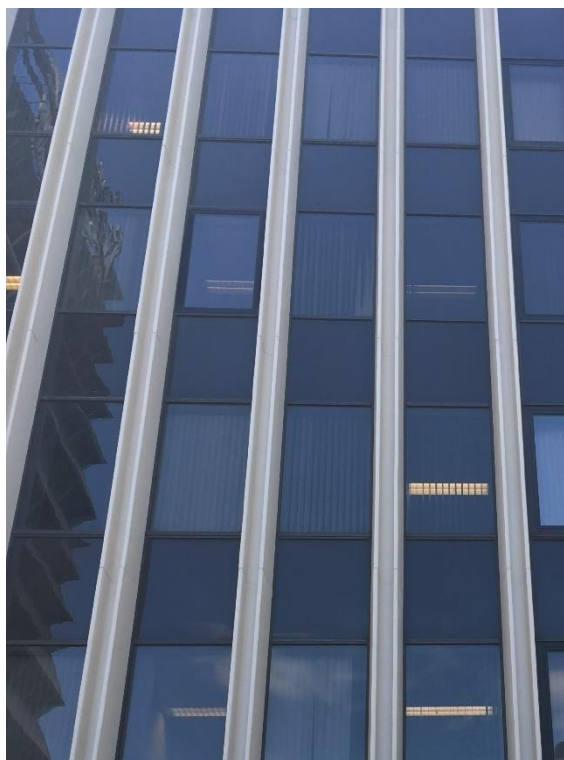
Figura 5.1.11. Vista da fachada cortina (Fonte: Autora, 2017)
