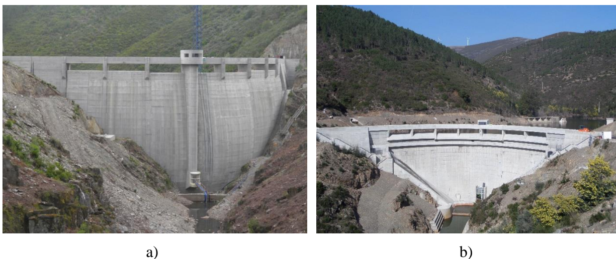
Figura 5.3: Barragem de Alto Ceira II. a) Vista de montante na fase final de construção; b) Vista de jusante na fase inicial de exploração.
