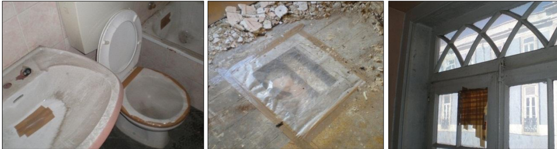
Figura 2 – Exemplo de selagem de algumas aberturas.
