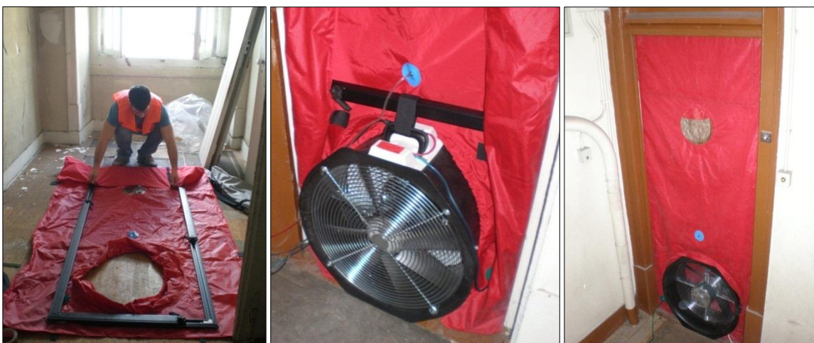
Figura 3 – Exemplo da montagem da porta ventiladora.
