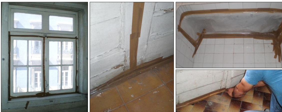
Figura 6 - Exemplo da selagem de juntas móveis das janelas e chaminé.
