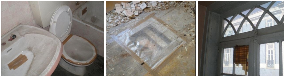
Figura 1 – Exemplo da selagem de algumas aberturas.
