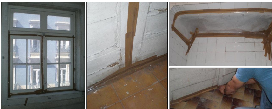
Figura 3 - Exemplo da selagem de juntas móveis das janelas e chaminé.
