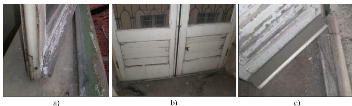
Figura 5.2 – Edifício adjacente, tipo Pombalino com obras de reabilitação e modernização. a) Janelas de peito (idêntico ao edifício estudado). b) Janela de sacada (vista pelo interior da habitação). c) Janela de sacada (vista pelo exterior). Medidas de melhoria da permeabilidade ao ar e à água: soleira em pedra trabalhada, perfil de alumínio e vedante.
