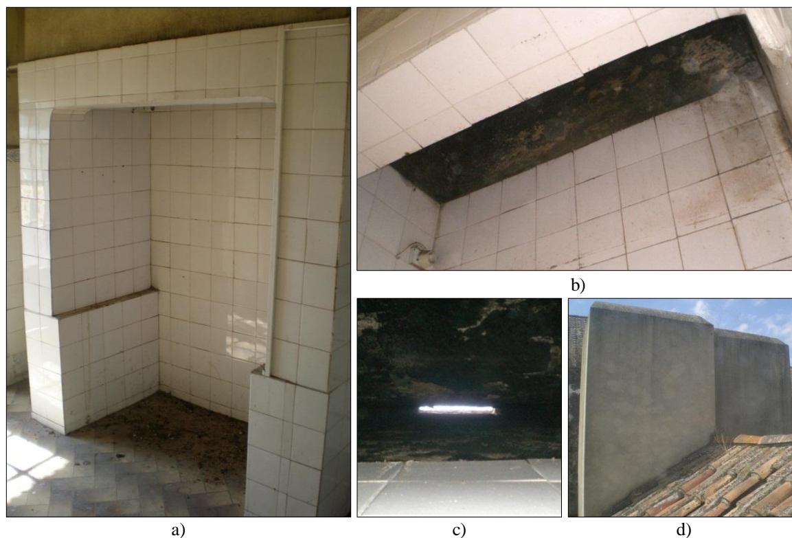
Figura 3.4 – Chaminé do edifício estudado. a) Vista geral. b) Abertura da chaminé (secção: 1,20 \times 0,50 \text{ m}^2 ). c) Conduta vertical da chaminé (secção: 1,00 \times 0,25 \text{ m}^2 ; altura: 7,50 m). d) Ventilador estático (altura acima da cobertura: 1,00 m).
