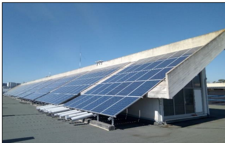
Figura 4-30 - Instalação dos painéis fotovoltaicos no edifício C1 da Faculdade de Ciências
