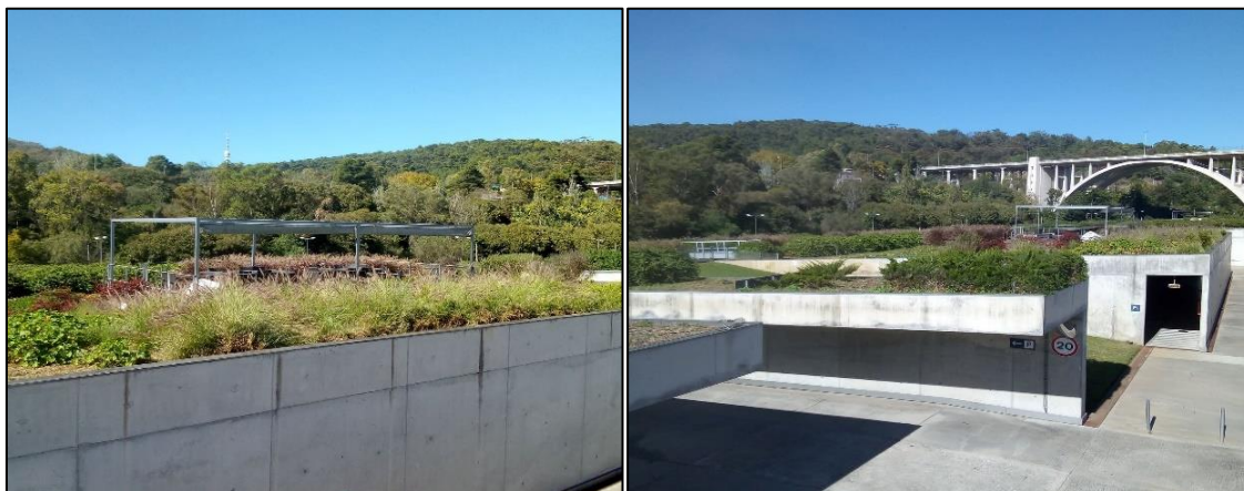
Figura 4-5 - Espaços de lazer na cobertura ajardinada da fábrica
