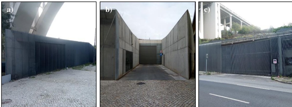
Figura 4-7 - Acessibilidades viárias ao edifício de operação na Fábrica de Água: a) Portaria norte; b) Acesso junto à portaria sul; c) Acesso lateral
