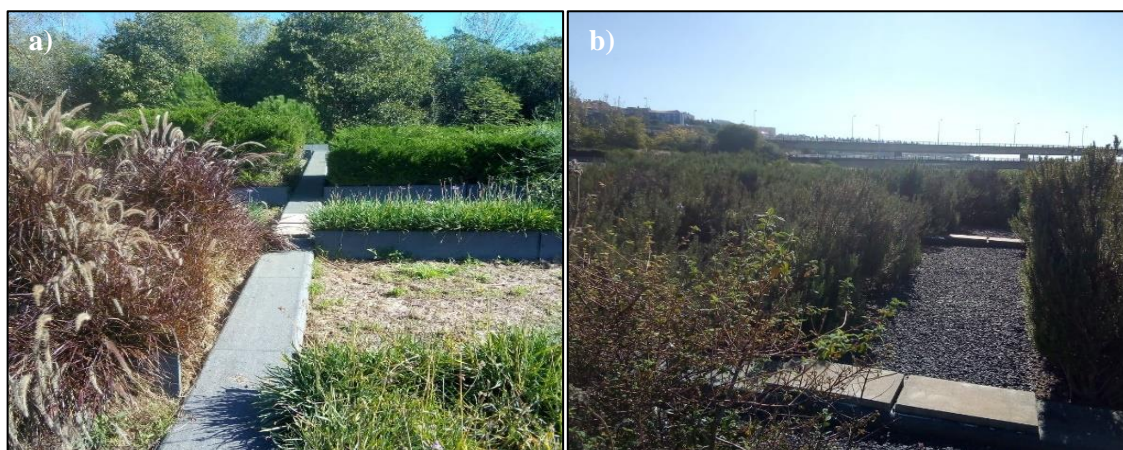
Figura 4-6 - Descontinuidade física e de espécies para prevenção de incêndios: a) Cobertura dos estacionamento; b) Cobertura do Edifício Sede
