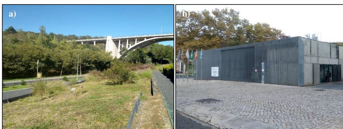
Figura 4-1 - Fábrica de Água de Alcântara, Lisboa: a) Cobertura das instalações; b) Portaria - entrada principal da fábrica
