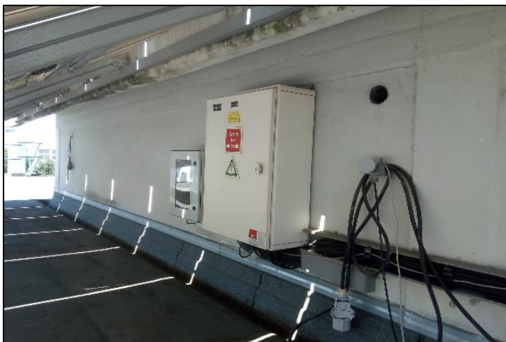
Figura 4-31 - Montagem do quadro de corte geral
