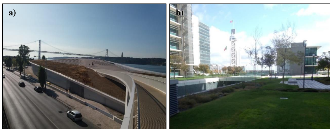
Figura 2-5 - Cobertura ajardinada: a) Edifício do Museu de Arte, Arquitetura e Tecnologia (MAAT), Lisboa; b) Campus da justiça, Lisboa
