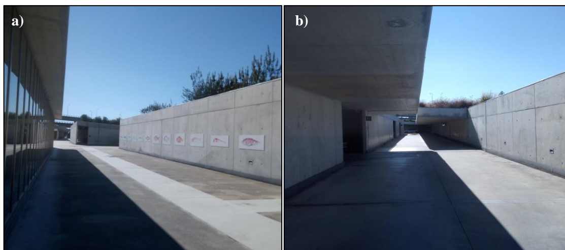
Figura 4-9 - Vias de circulação interna: a) Acesso ao edifício administrativo e de monitorização; b) Acesso aos parques de estacionamento
