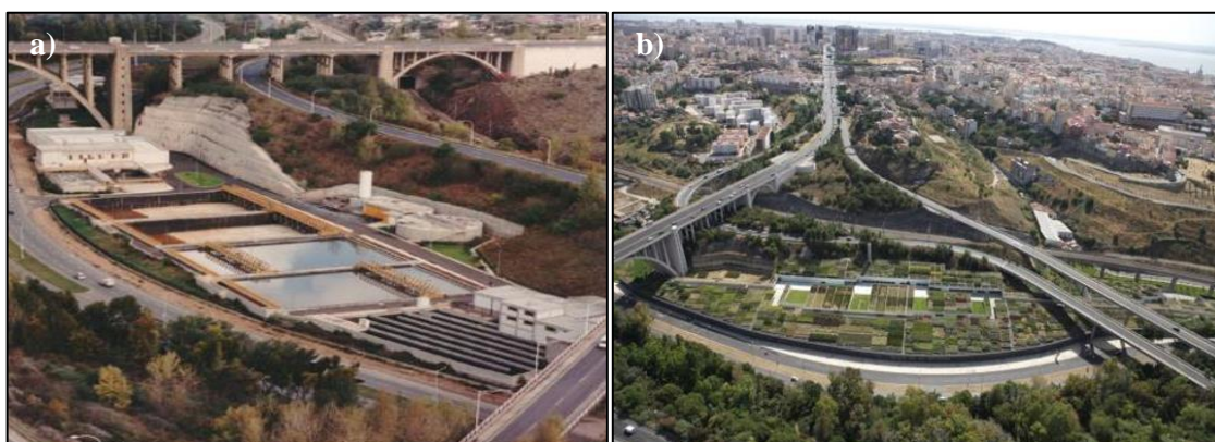
Figura 4-4 - Requalificação da estação de tratamento de água de Alcântara (ETAR): a) ETAR antes de ser requalificada; b) Fábrica de Água, depois das obras de requalificação (crédito: Apresentação da cobertura feita pela Águas de Portugal (AdP) na Faculdade de Ciências e Tecnologia da Universidade Nova de Lisboa)
