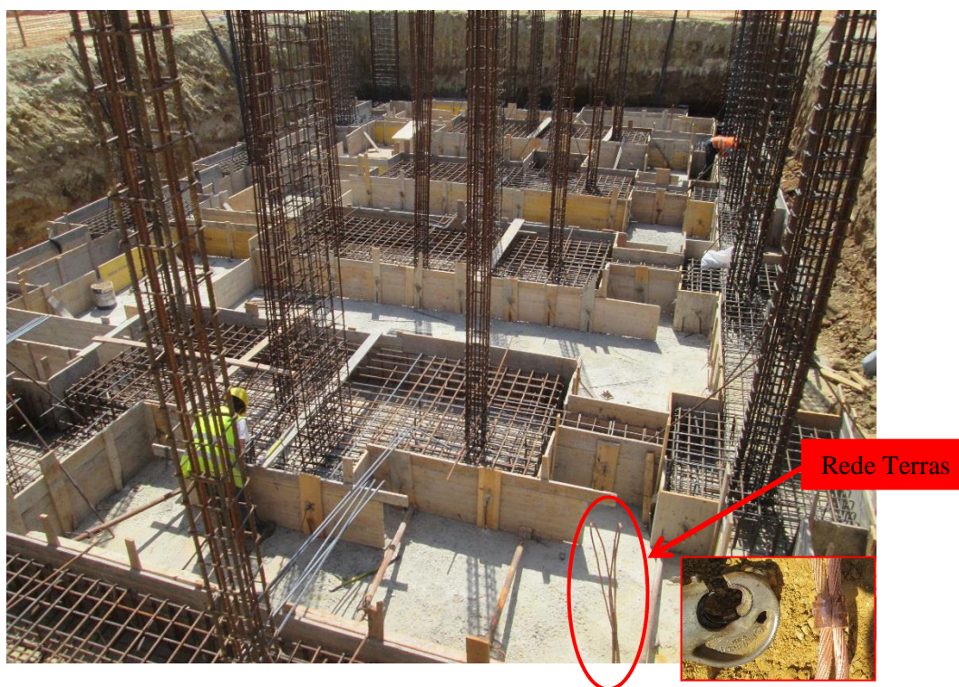
Fotografia 3 - Execução de cofragem e armaduras de sapatas e vigas de fundação PS Alto São João
