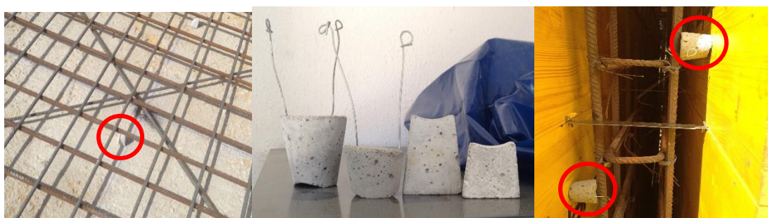
Fotografia 5 – Tipo de espaçadores (fotografia central) e Aplicação espaçadores (Fotografia direita e esquerda)
