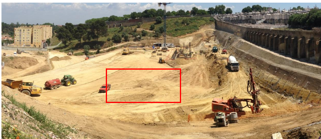
Fotografia 2 - Cota final da plataforma e assinalado o local do futuro Posto de Seccionamento
