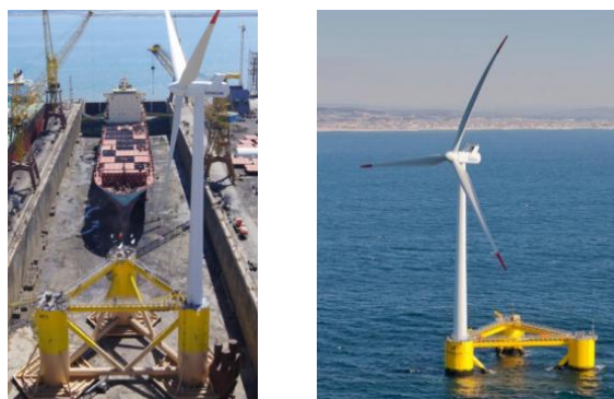
Figuras 2.5 e 2.6 – Projeto WindFloat: fase de construção (à esquerda) e fase final (à direita) (Fonte: XIX Congresso da Ordem dos Engenheiros (2012) - Projeto WindFloat. Lisboa)
