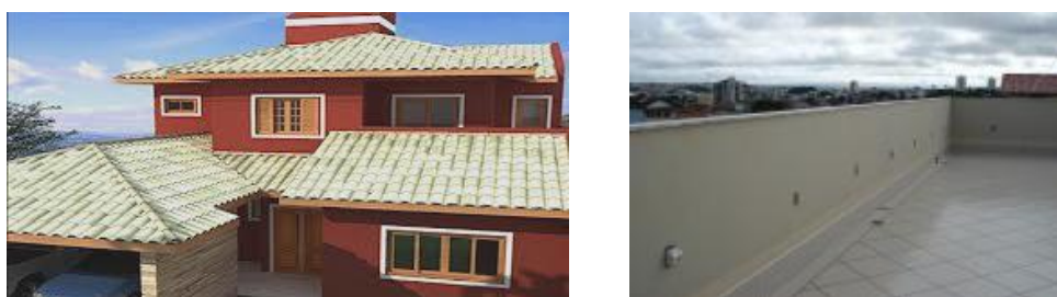
Figuras 4.3 e 4.4 – Cobertura inclinada (à esquerda) e cobertura em terraço (à direita)
