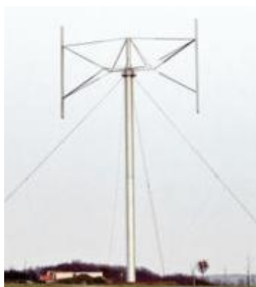
Figura 2.18 – Turbina de Darrieus com asas verticais
