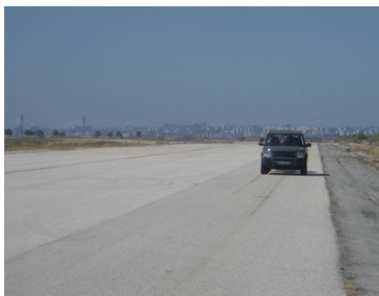
Figura 4.6 – Vista geral do local e do pavimento
