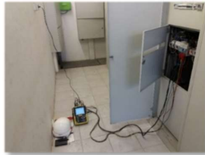
Figura 47 – Ligação do analisador de rede ao circuito em análise
