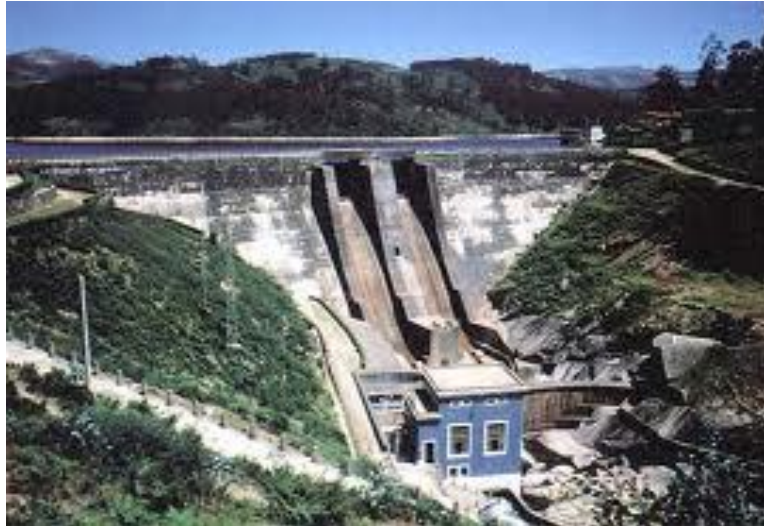
Figura 2.4 – Barragem de Fagilde, em Viseu, exemplo de uma barragem de betão com perfil gravidade. (5)
