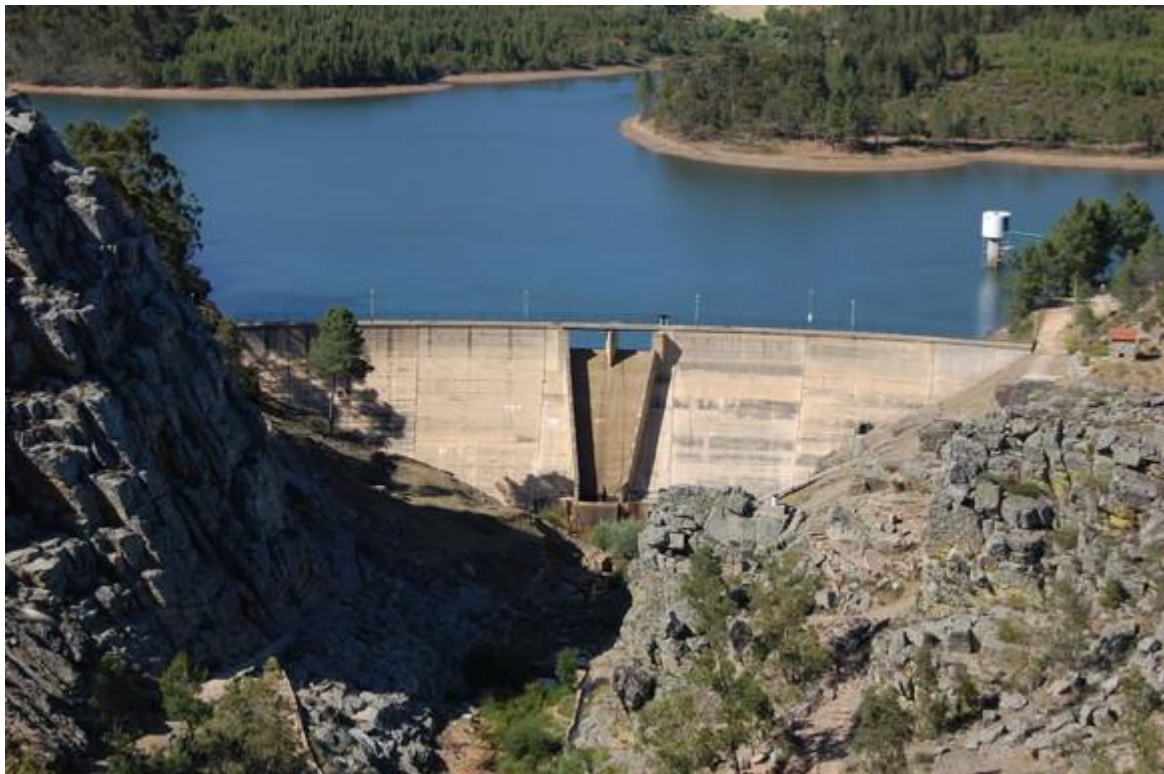
Figura 5.1 – Barragem de Penha Garcia. (1)
