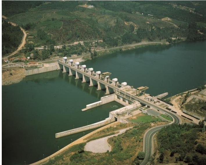
Figura 2.11 – Barragem de Crestuma, no Porto, exemplo de uma barragem móvel. (12)
