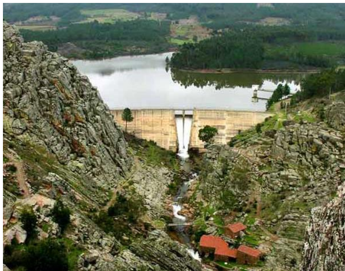
Figura 1.1 – Barragem de Penha Garcia, Castelo Branco. (1)
