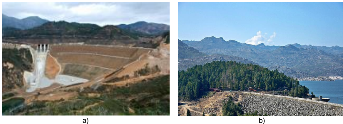
Figura 2.3 – a) Barragem de Odelouca, exemplo de uma barragem de terra (3). b) Barragem de Paradela, exemplo de uma barragem de enrocamento (4).
