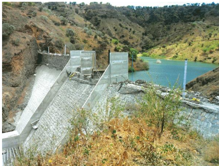
Figura 2.5 – Barragem de Salineiro e Faveta, em Cabo Verde, exemplo de uma barragem de alvenaria com perfil de gravidade. (6)
