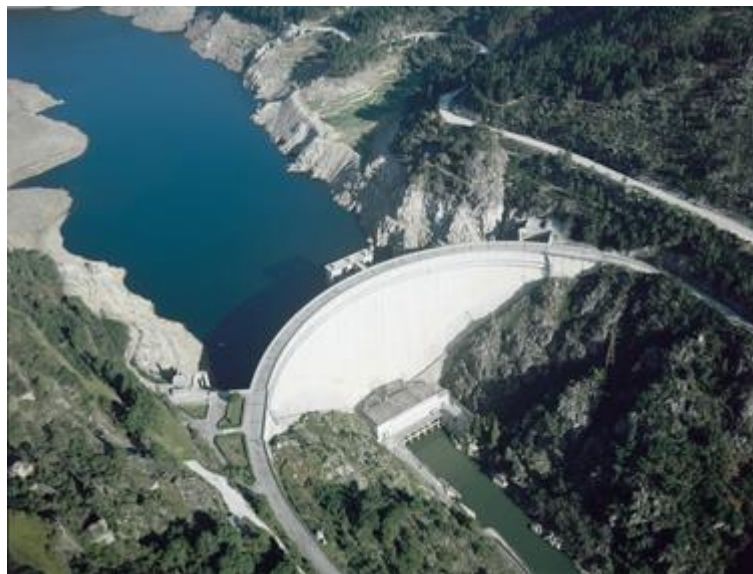
Figura 2.7 – Barragem do Cabril, em Castelo Branco, exemplo de uma barragem abóbada. (8)
