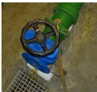
Figura 2.7 – Descarga de fundo.
