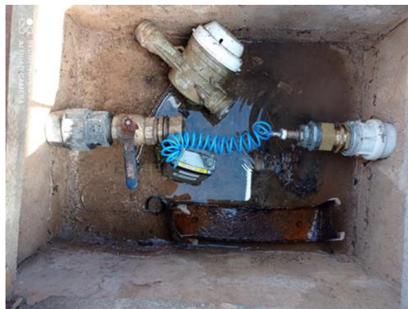
Figura 4.43 – Instalação de data logger de pressão em caixa de contador.
