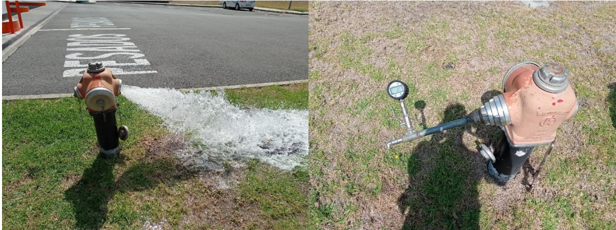
Figura 5.18 – À esquerda temos o marco de incêndio do extremo da rede aberto e à direita temos um manômetro digital montado em marco de incêndio situado a montante (tiradas em 2024).
