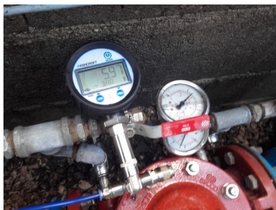
Figura 2.16 – À esquerda um manómetro digital e à direita dois manómetros analógicos montados numa VRP.
