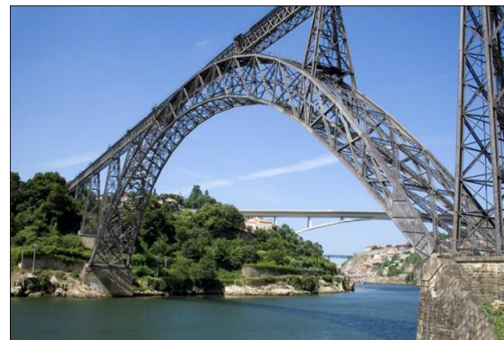
Figura 1.4 – Ponte D. Maria Pia (Porto)
