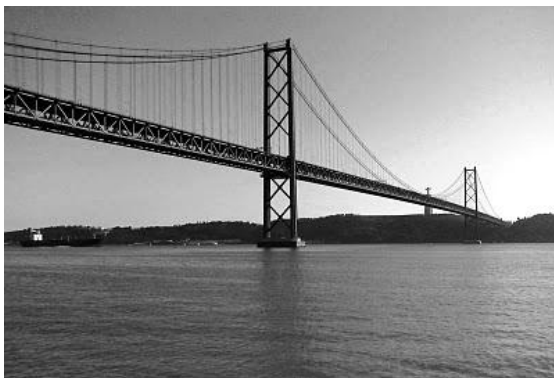
Figura 1.3 – Ponte 25 de Abril (Lisboa)
