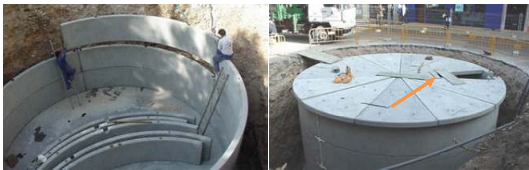
Figura 2.4 - Estrutura subterrânea construída em placas de betão pré-fabricado. A esquerda, aspecto das placas prefabricadas e sua disposição. A direita, aspecto final da estrutura (ma-SISTEMAS, 2003).
