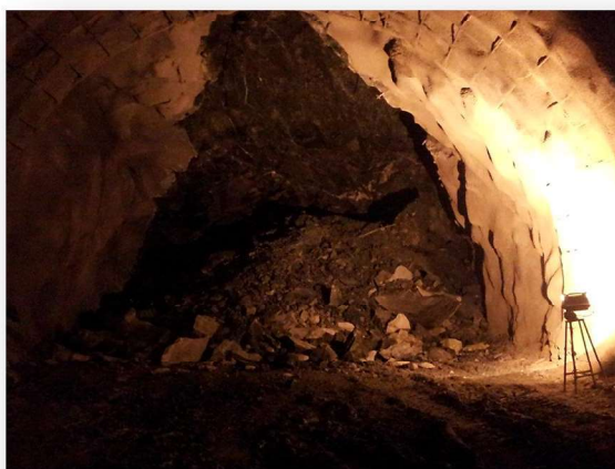
(cap. 5.2) - Fotografia 78 – Durante a instabilidade na frente de escavação. Foto de Cláudio Santa 2015.
