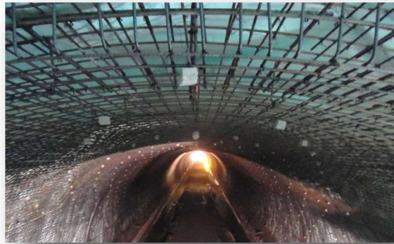
(cap. 4.2) - Fotografia 56 – Armadura e espaçadores. Foto de IP 2016.
