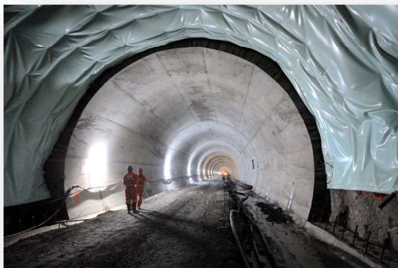
(cap. 4.3) - Fotografia 70 - Sistema de impermeabilização e revestimento definitivo. Foto do autor 2015.
