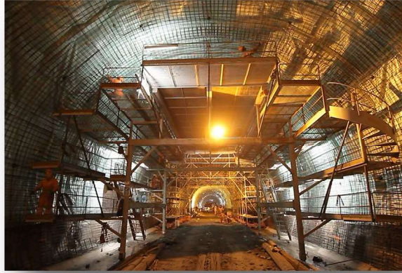
(cap. 4.2) - Fotografia 53 - AndAIMes deslizantes para instalação de impermeabilização e armadura. Foto do autor 2015.
