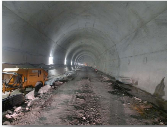
(cap. 4.2) - Fotografia 55 – Bomba de betão estática para colocação de betão e aspeto final do betão após descofragem. Foto de IP 2016.
