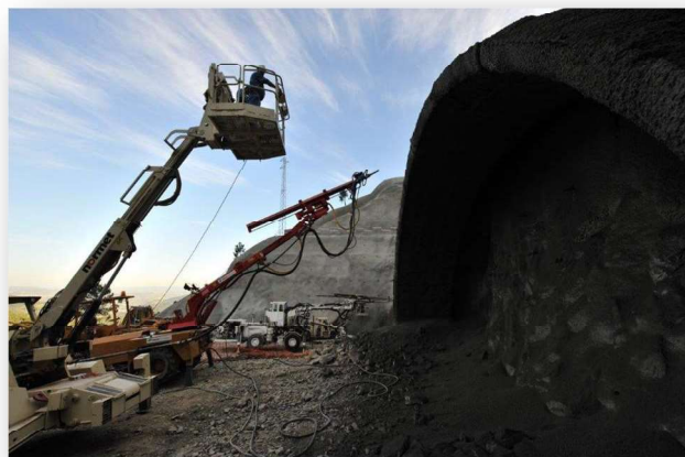
(cap. 2.5) - Fotografia 3 - Emboquilhamento do túnel norte nascente, Vila Real. Foto do autor 2009.
