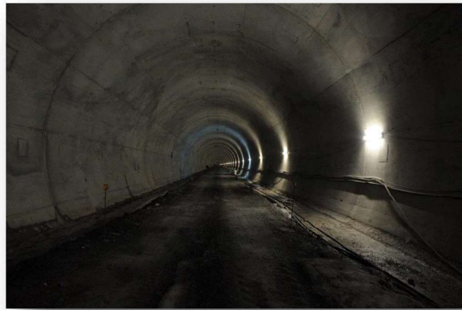
(cap. 2.4) - Fotografia 2- Secção transversal da secção corrente dos túneis, sem pavimentos. Foto do Autor 2015.
