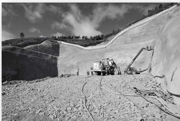
(cap. 2.5) - Fotografia 3 - Emboquilhamento do túnel norte nascente, Vila Real. Foto do autor 2009.
