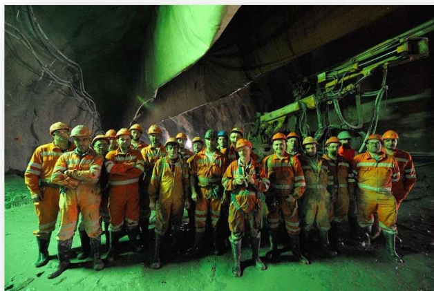
(cap. 4.1) - Fotografia 33 - Equipa do lado poente do túnel no momento do varamento. Foto do autor 2015.
