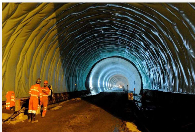
(cap. 4.3) - Fotografia 67 - Sistema de impermeabilização. Foto do autor 2015.
