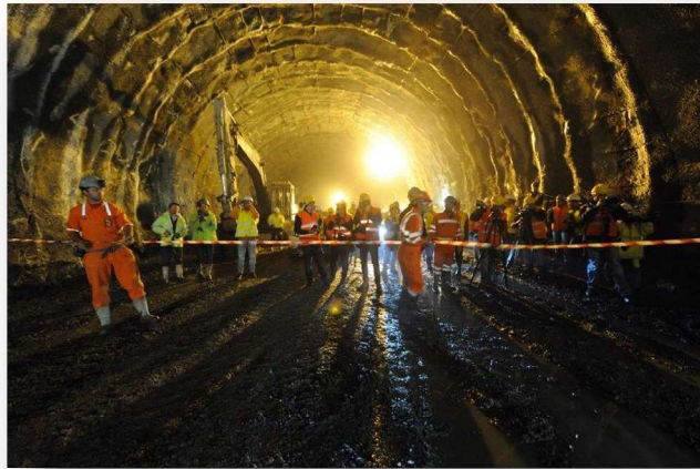
(cap. 4.1) - Fotografia 30 - Momento do disparo da pega de fogo, túnel poente sul, Amarante. Foto do autor 2015.
