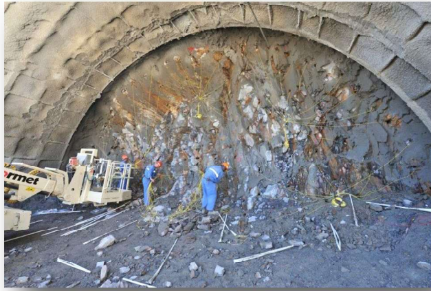
(cap. 2.5) - Fotografia 5 - Trabalhos de carregamento com explosivo da frente de escavação no túnel norte nascente, Vila Real. Foto do Autor 2009.
