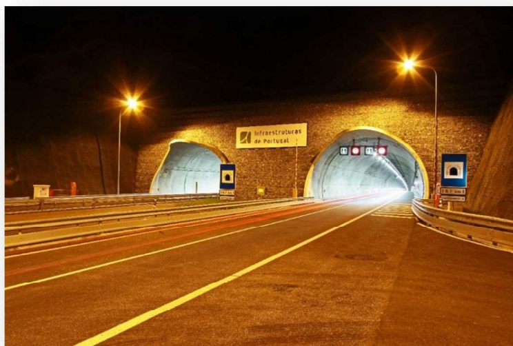
(cap. 4.3) - Fotografia 75 - Vista geral da pavimentação e sinalética na entrada do túnel do lado Nascente, Vila Real. Imagens de TD-EC-2016.
