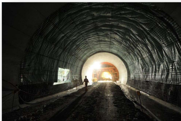
(cap. 4.3) - Fotografia 68 - Armadura colocada sobre impermeabilização. Foto do autor 2015.
