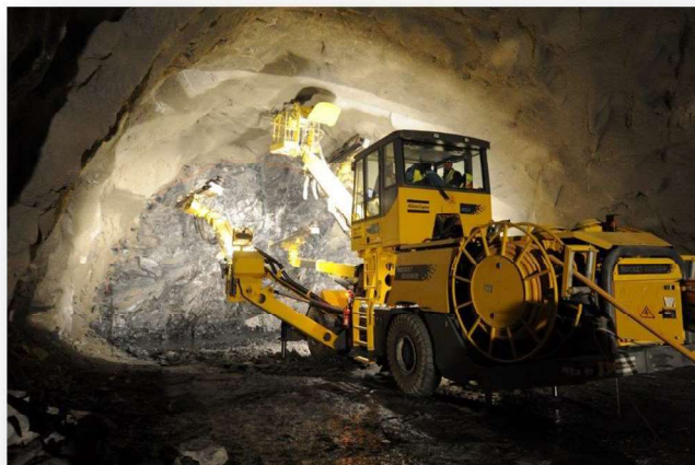
(cap. 2.5) - Fotografia 15 – Trabalhos de furação. Emboquilhamento nascente, Vila Real. Foto do autor 2010.
