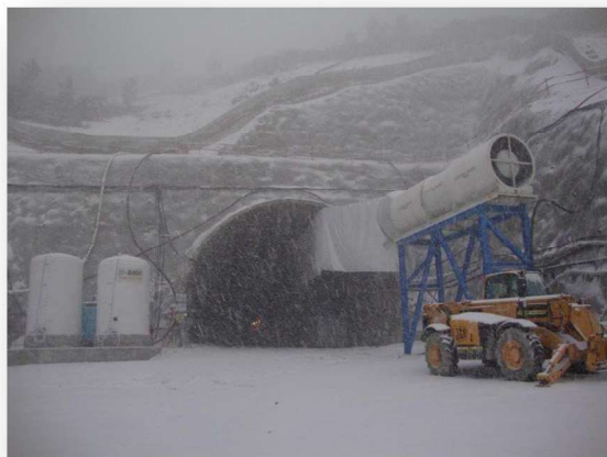
(cap. 2.5) - Fotografia 9 - Obra parada no inverno de 2009/2010. Emboquilhamento nascente, Vila Real. Foto do autor 2010.
