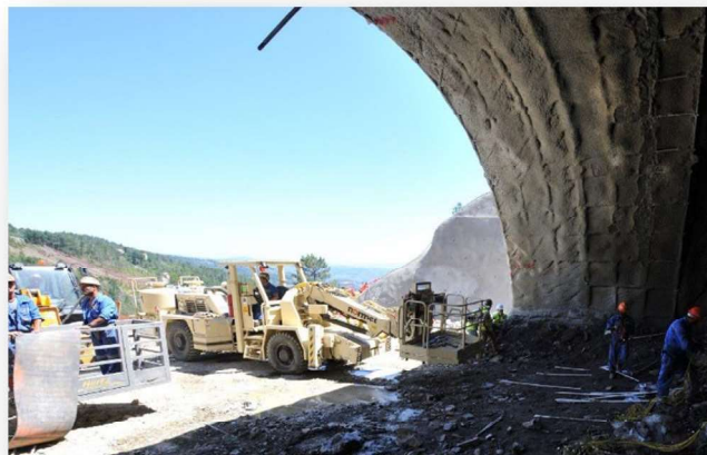
(cap. 4.2) - Fotografia 51 – Carregamento da primeira pega de fogo com auxílio de multicarregador Normet Charmec. Foto do autor 2009.
