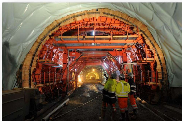
(cap. 4.1) - Fotografia 26 - Primeira betonagem no túnel nascente norte, Vila Real, com recurso a sistema de cofragem deslizante de 15 metros. Fotografia tirada no sentido da entrada do túnel. Consegue observar-se a autobetoneira a descarregar na bomba estática. Foto do autor 2015.
