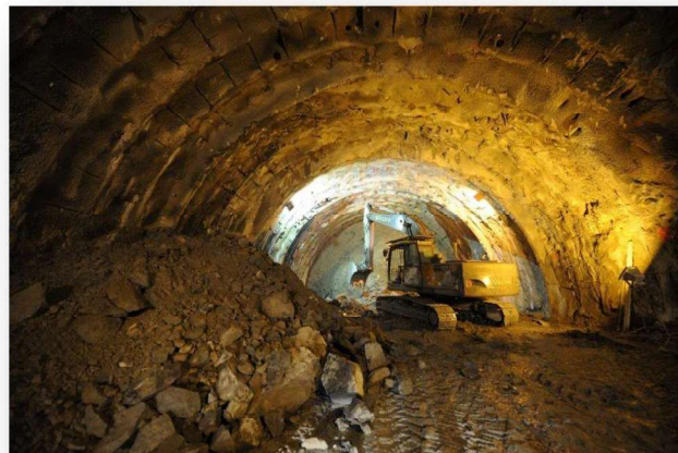
(cap. 4.3) - Fotografia 66 - Escavação com recurso a giratória. Foto do autor 2015.
