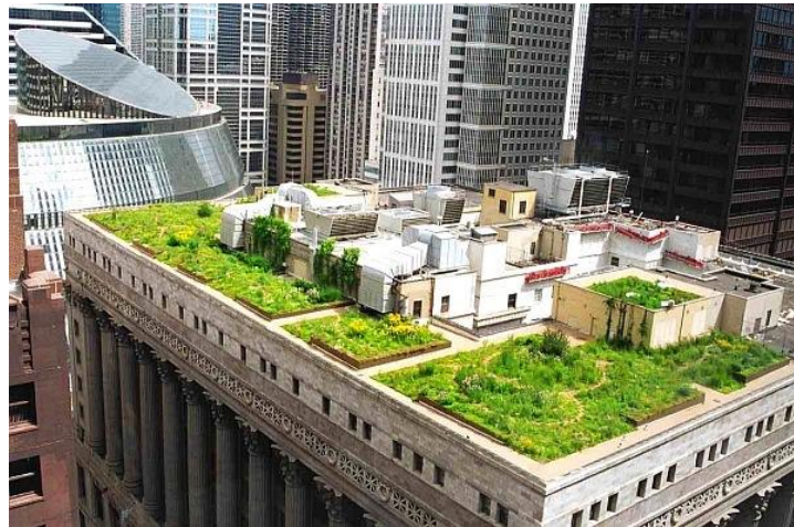
Figura 36 - Cobertura do City Hall em Chicago [42].
