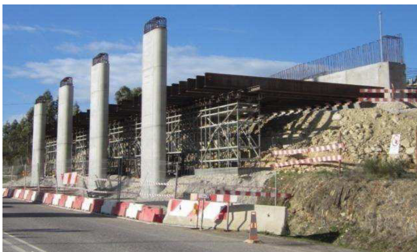
Figura 19 – PI 13 – Cimbra ao solo e recurso a salva-taludes
