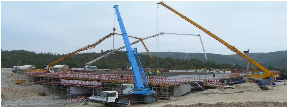
Figura 24 – PI 13 – Betonagem do tabuleiro
