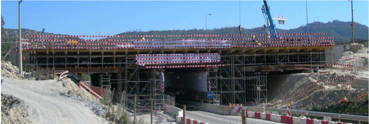
Figura 21 – PI 13 – Vista Geral do cimbreiro ao solo
