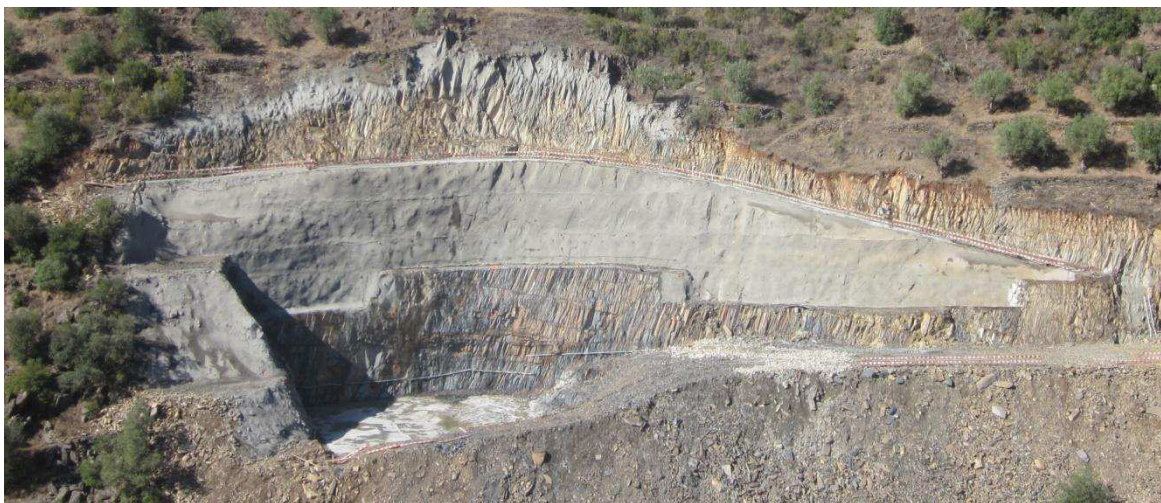
Figura 58 – PROC – Resultado final da contenção de escavação do P1
