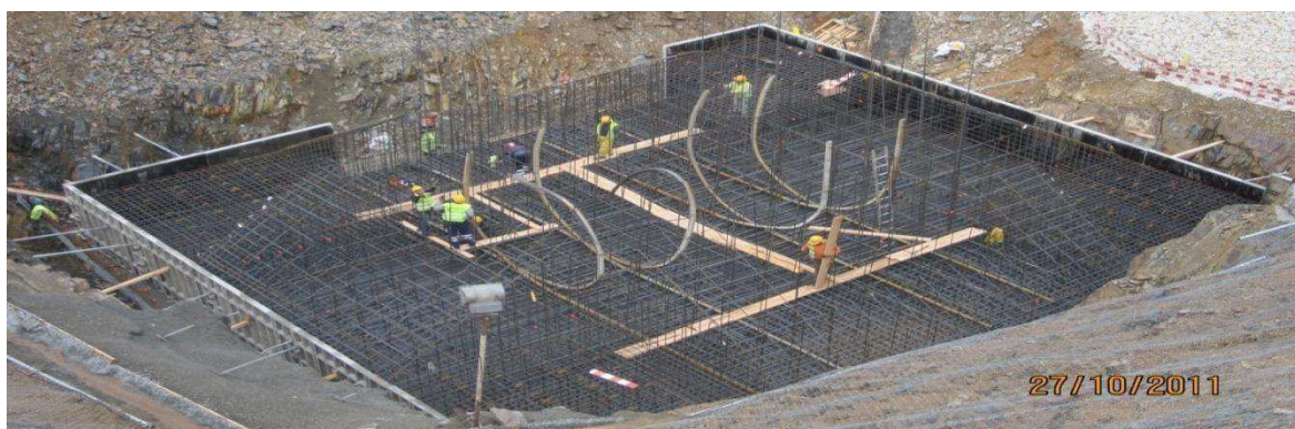
Figura 64 – PROC – Pré-esforço das sapatas dos pilares
