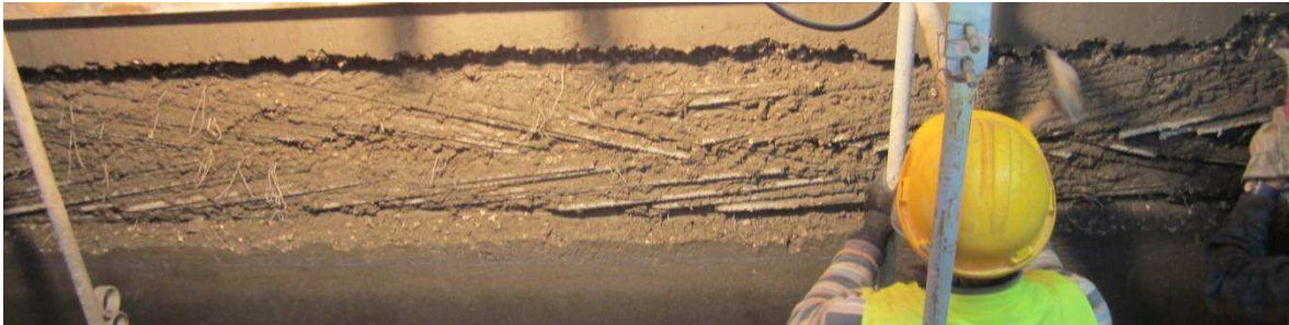
Figura 69 – PROC – Armaduras de espera para os septos do interior dos pilares
