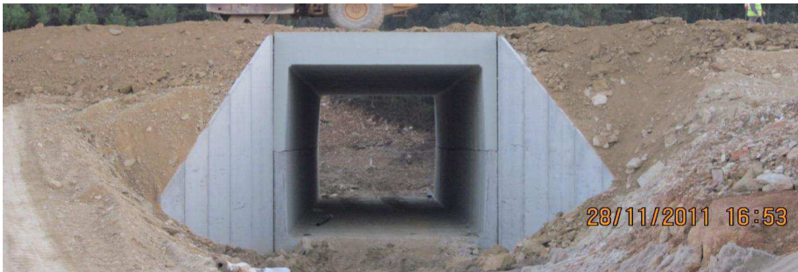
Figura 29 – PA – Box-culvert já montada e aterrada
