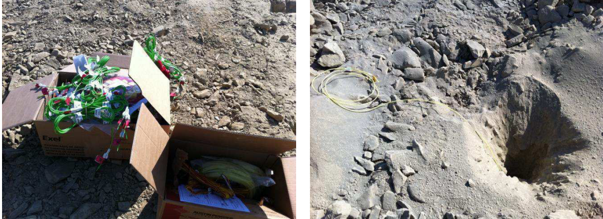
Figura 54 – PROC – Preparação de explosivos para fundações do P2
