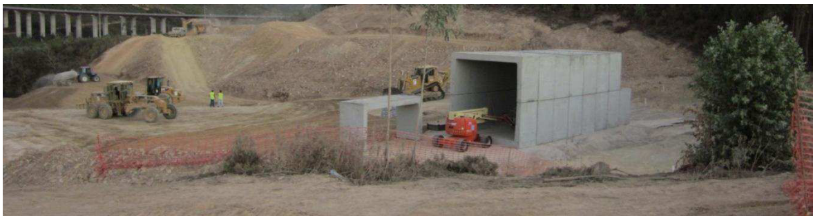
Figura 27 – PA – Montagem / colocação das box-culvert
