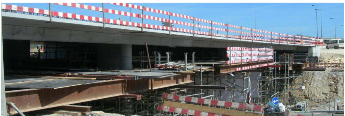
Figura 25 – PI 13 – Baixar cofragem e perfis de apoio à cofragem
