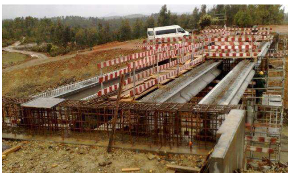
Figura 9 – PS – Tabuleiro: colocação de vigas pré-fabricadas
