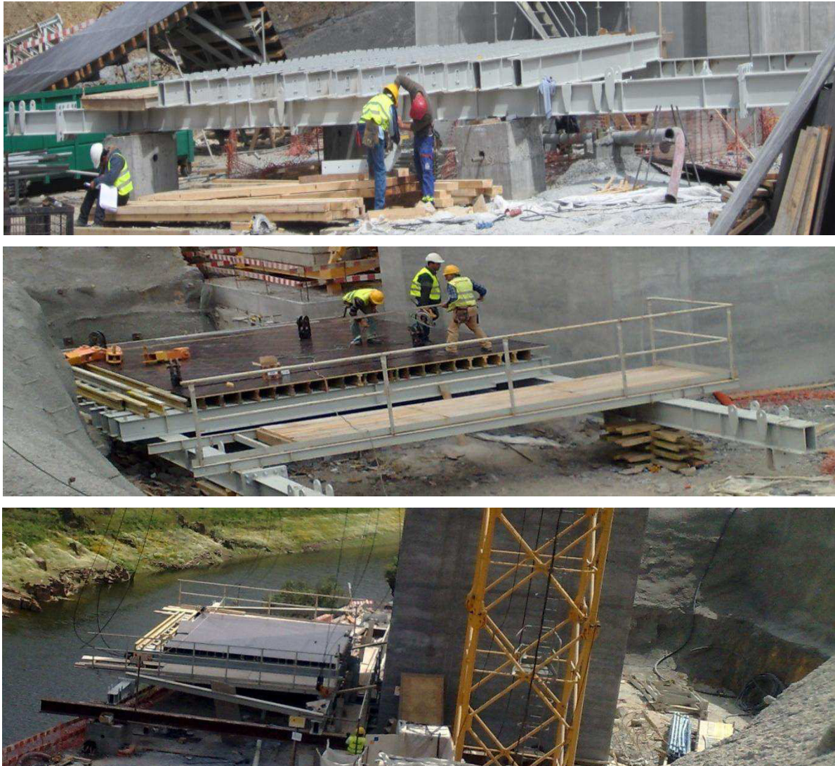
Figura 97 – PROC – Pré-montagem ao nível do solo da cofragem de fundo e sua elevação
