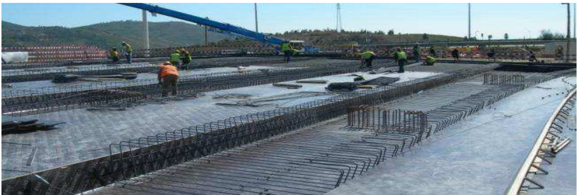
Figura 22 – PI 13 – Colocação da armadura do tabuleiro
