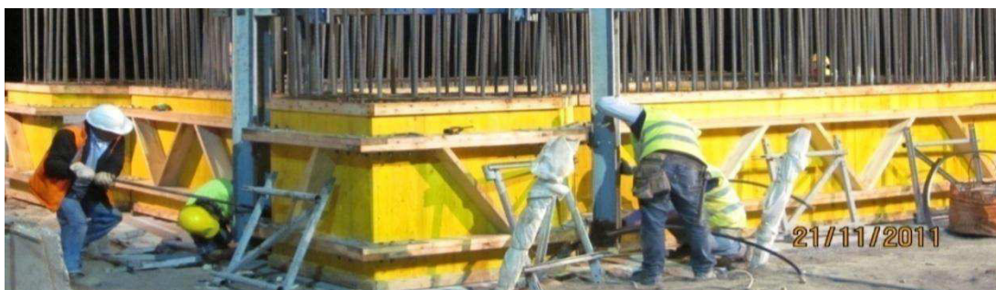
Figura 73 – PROC – Montagem dos cavaletes
