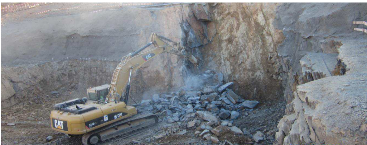
Figura 53 – PROC – Escavação mecânica
