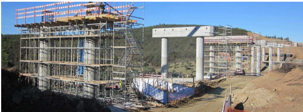
Figura 34 – VRSG – Viga travessa
