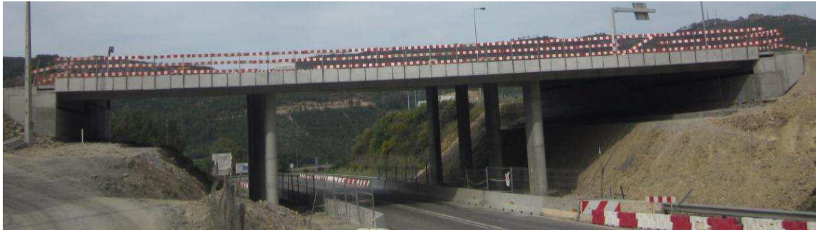
Figura 26 – PI 13 – Vista geral
