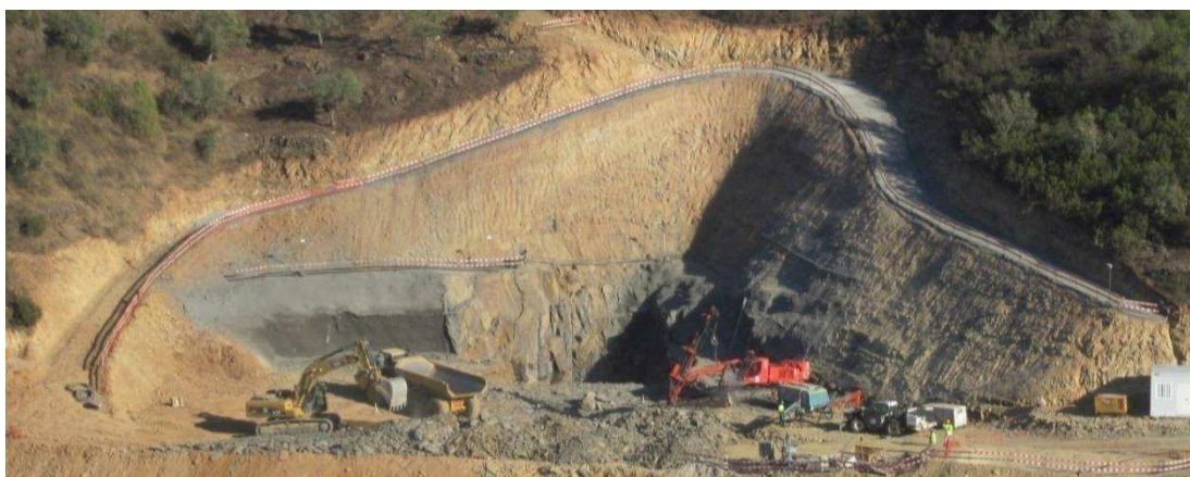
Figura 59 – PROC – Resultado final da contenção de escavação do P2
