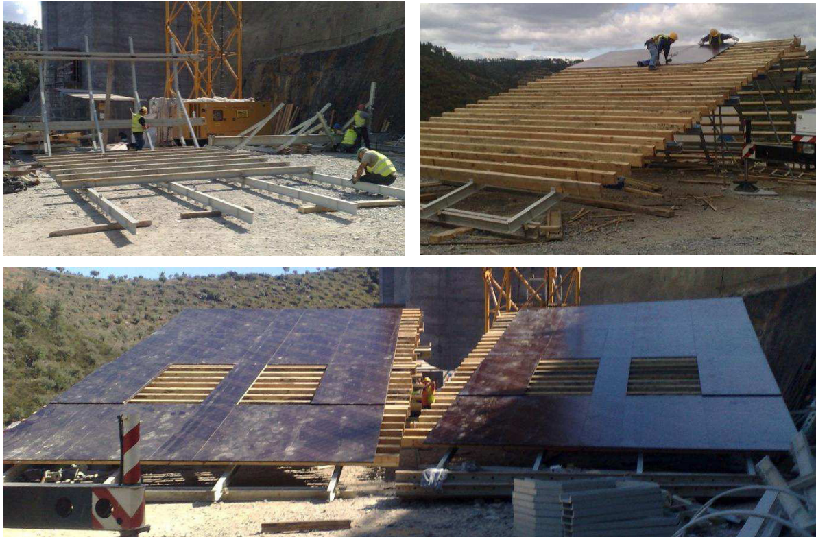
Figura 98 – PROC – Pré-montagem ao nível do solo da cofragem exterior
