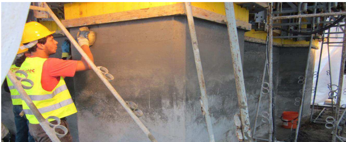
Figura 80 – PROC – Talochamento dos pilares
