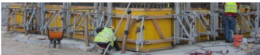
Figura 72 – PROC – Montagem e fixação dos painéis de cofragem com cerca de 1,20 m
