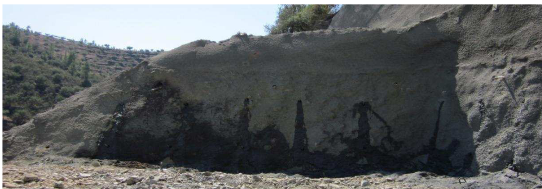
Figura 60 – PROC – Drenagem de taludes com tubos horizontais
