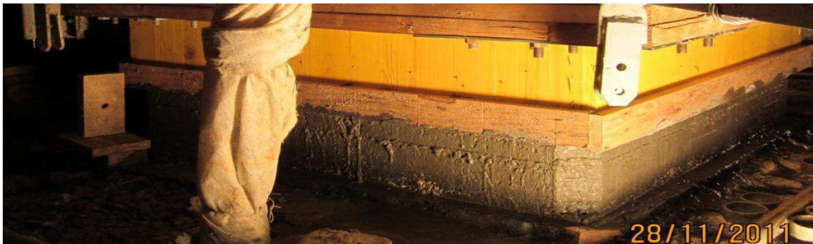
Figura 78 – PROC – Subida de cofragem deslizante
