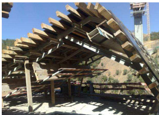
Figura 99 – PROC – Plataformas de trabalho da cofragem exterior
