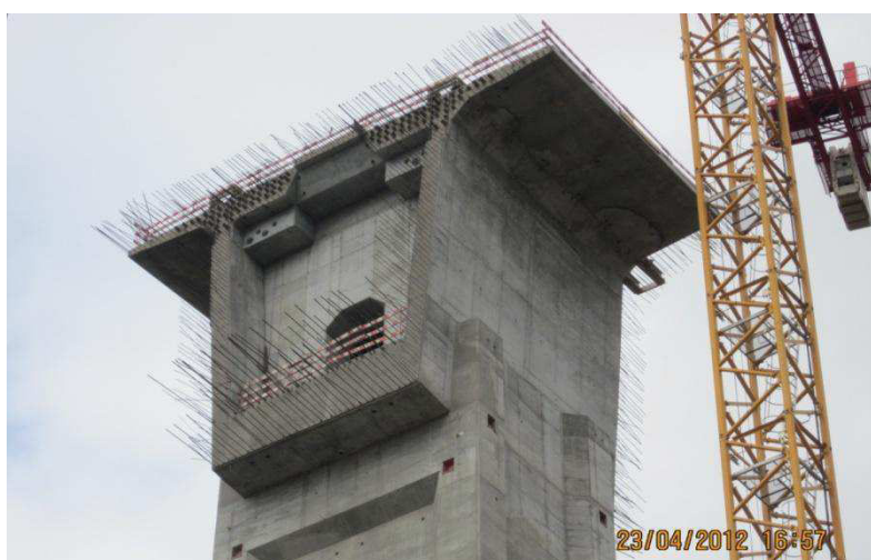
Figura 92 – PROC – AD00 concluída
