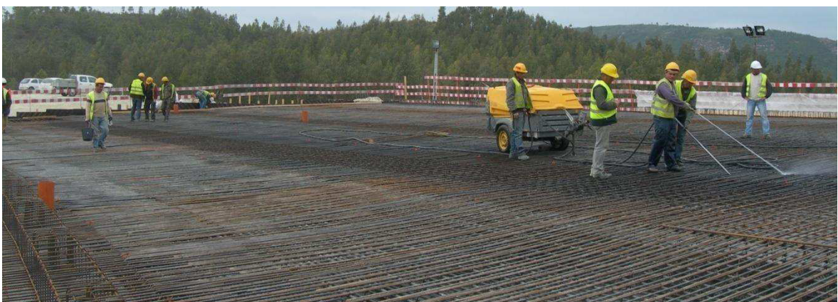
Figura 23 – PI 13 – Limpeza do tabuleiro (armaduras e cofragem), antes da betonagem
