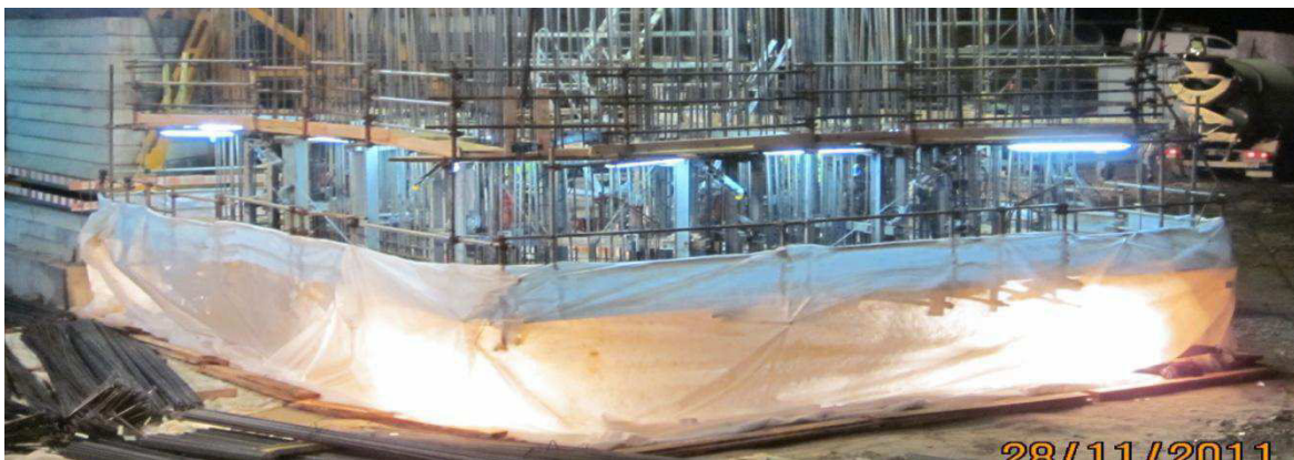
Figura 77 – PROC – Cofragem deslizante e equipamento de apoio montado. Início do deslize
