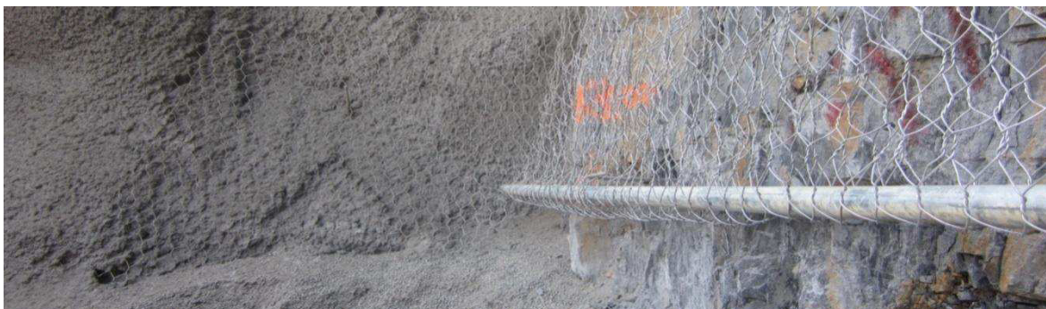
Figura 56 – PROC – Rede de aço, pregada no topo e na base do talude
