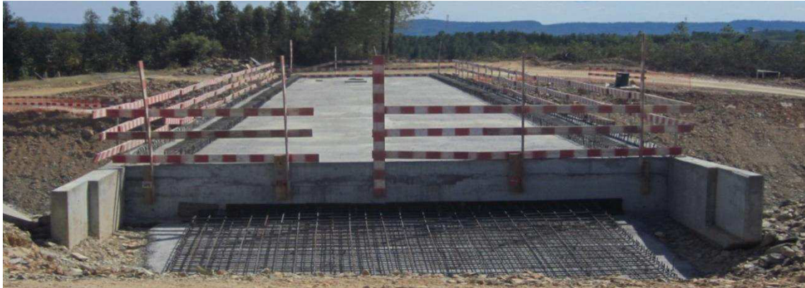
Figura 11 – PS – Tabuleiro betonado
