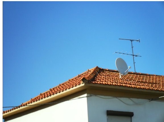
Figura 9 – Estado de conservação da cobertura (exterior)
