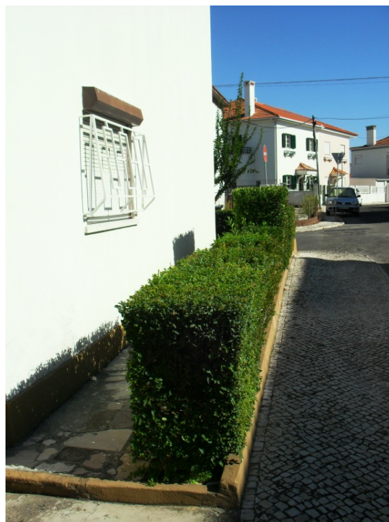
Figura 16 – Estado de conservação dos arranjos exteriores
