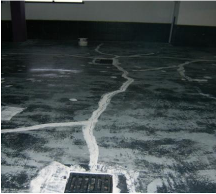
Figura 2.122 – Tratamento de fendas no pavimento
