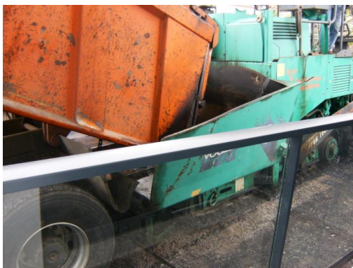
Figura 2.37 – Descarga do betuminoso na pavimentadora
