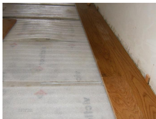
Figura 2.86 – Início da colocação das pranchas
