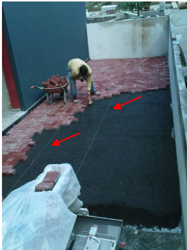
Figura 2.43 – Nivelamento da camada base em areia
