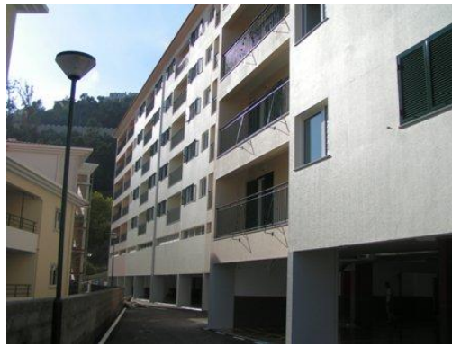
Figura 3.14 – Edifício Quintas III
