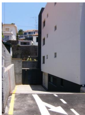
Figura 2.104 – Pintura exterior dos traços indicadores de sentido, acesso e saída da garagem
