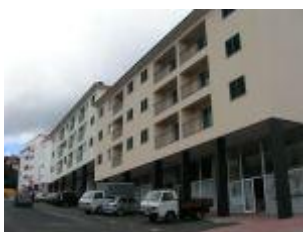
Figura 3.54 – Edifício Quintas VI Fonte: AFFC
