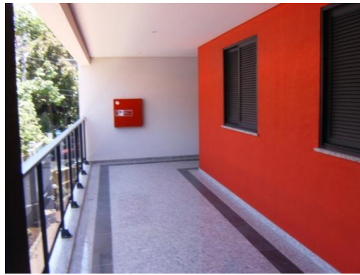
Figura 2.101 – Zonas comuns, pintura exterior
