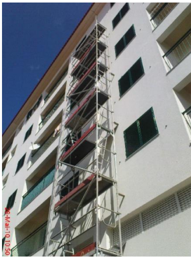
Figura 2.162 – EPC, andaime em uma peça, edifício Quintas V
