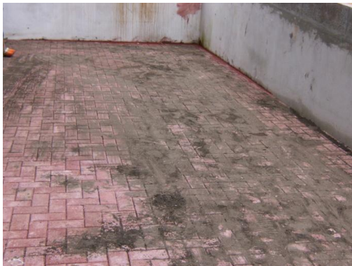
Figura 2.45 – Espalhamento de areia para preenchimento de vazios
