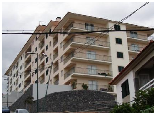
Figura 3.1 – Edifício Quintas II
