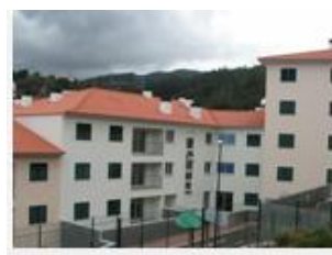
Figura 3.55 – Edifício Quintas VI, Fonte: AFFC
