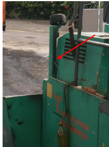
Figura 2.40 – Indicador da espessura da camada a ser aplicada
