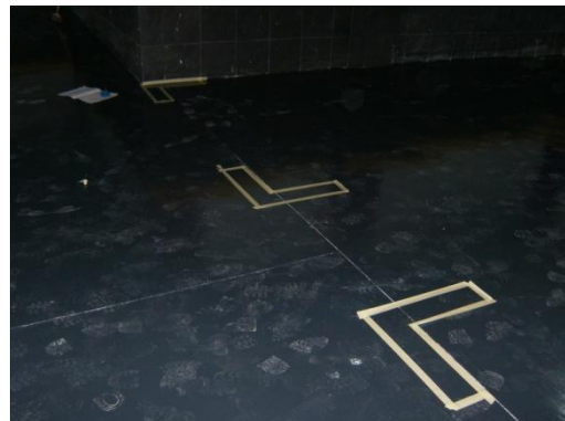
Figura 2.125 – Marcação das zonas de estacionamento no pavimento
