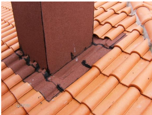
Figura 2.66 – Remate da impermeabilização das chaminés
