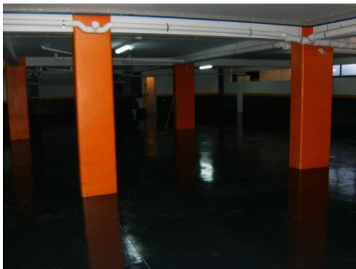
Figura 2.124 – Aplicação da 2ª demão de tinta epoxy no pavimento, pintura interior
