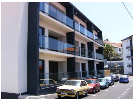
Figura 2.95 – Fachada Sudoeste, pintura exterior
