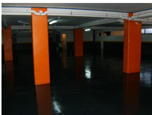
Figura 2.116 – Pintura dos pilares da garagem, pintura interior
