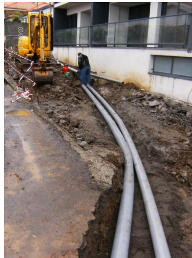
Figura 2.12 – Execução da ligação
