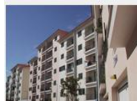
Figura 3.32 – Edifício Quintas V Fonte: AFFC
