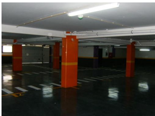
Figura 2.118 – Acabamento final da pintura interior na garagem
