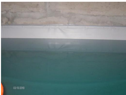
Figura 2.70 – Enchimento do tanque para ensaio
