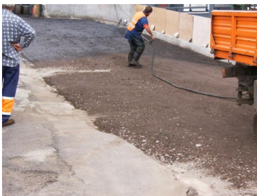
Figura 2.31 – Rega de impregnação sobre a camada de Tout-Venant
