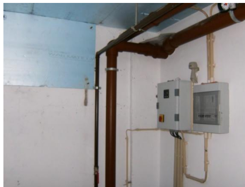
Figura 2.132 – Pintura interior, rede de águas residuais
