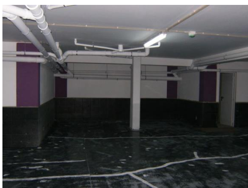
Figura 2.120 – Aplicação de 1ª demão no pavimento, pintura interior
