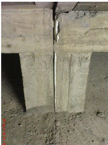
Figura 3.21 – Junta de dilatação no sótão
