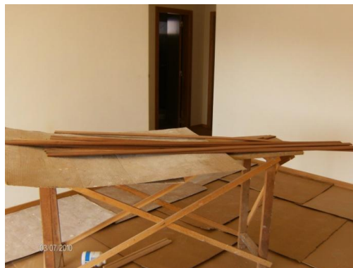
Figura 2.89 – Ripas para execução dos rodapés
