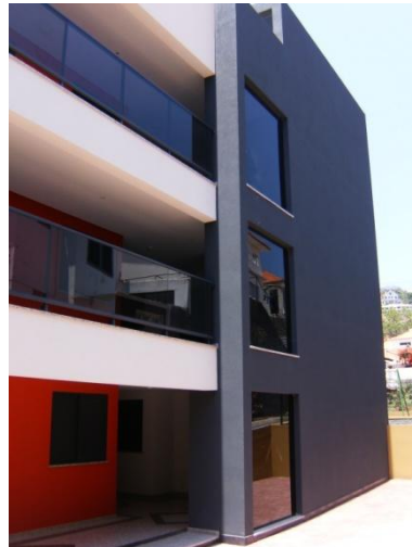
Figura 2.76 – Varandas e fachada envidraçada, alçado Nordeste
