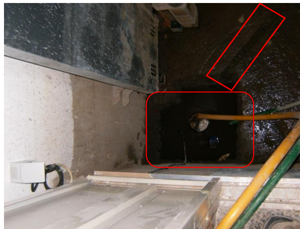
Figura 2.20 – Poço elevador, abertura para colocação da bomba
