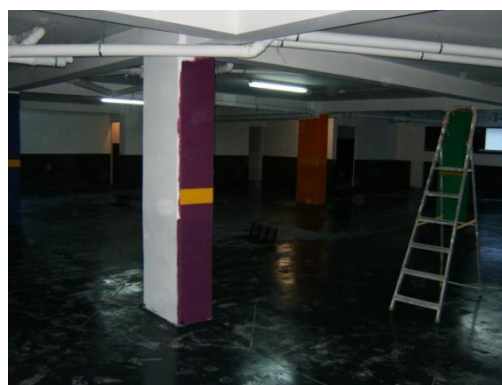
Figura 2.115 – Ensaio de amostra de cores a ser aplicada, pintura interior
