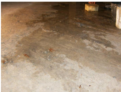
Figura 3.48 – Remoção da água proveniente da infiltração do beiral com auxílio a esponjas
