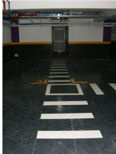
Figura 2.129 – Pintura das passadeiras de circulação no pavimento
