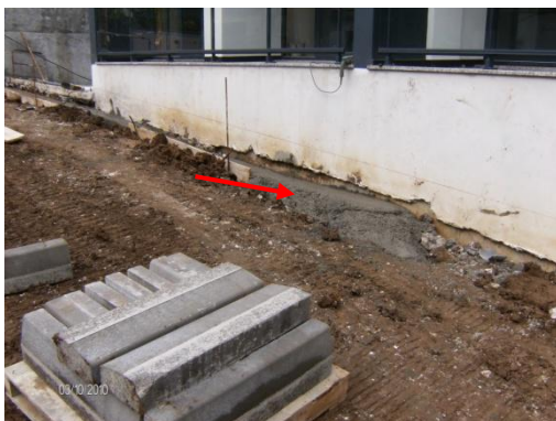
Figura 2.25 – Aplicação de camada de betão para colocação de lancis
