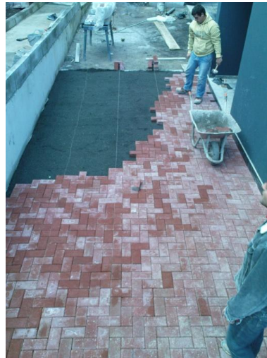
Figura 2.44 – Colocação das peças pré-fabricadas
