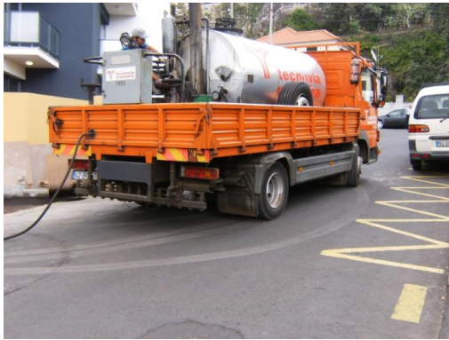
Figura 2.33 – Camião cisterna de ligante
