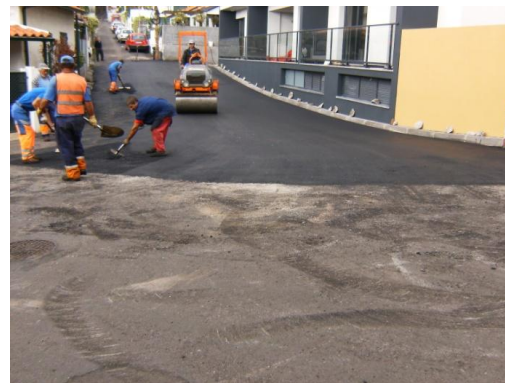
Figura 2.42 – Regularização do pavimento
