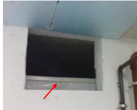
Figura 2.72 – Abertura de acesso ao tanque
