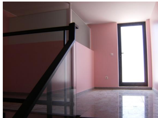
Figura 2.111 – Paredes e tecto escadaria, pintura interior
