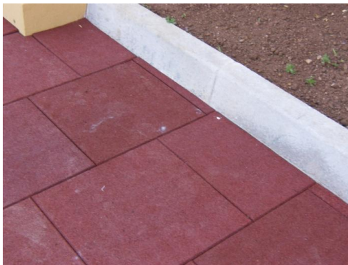
Figura 2.147 – Parque infantil, conclusão do pavimento
