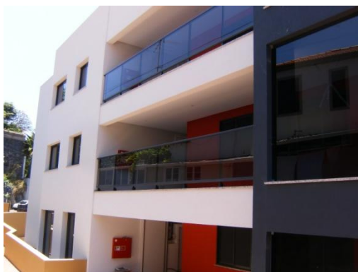
Figura 2.99 – Fachada Noroeste, pintura exterior
