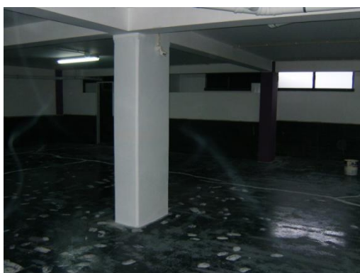
Figura 2.114 – Paredes e tectos garagem, pintura interior
