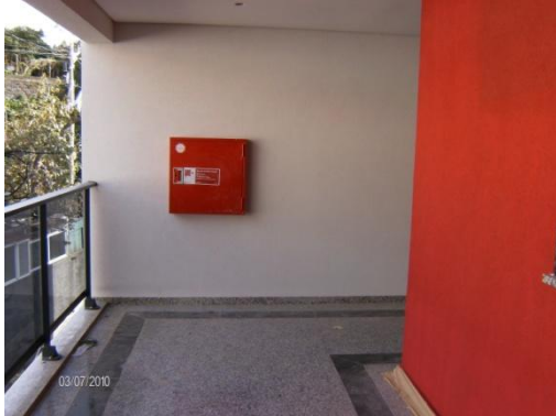
Figura 2.164 – Limpeza da obra
