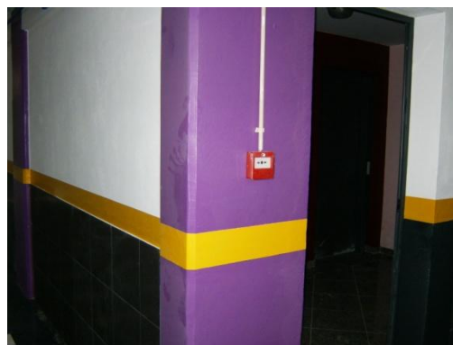
Figura 2.119 – Pilares e faixa de sinalização, pintura interior
