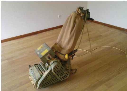
Figura 3.52 – Reparação do soalho da fracção
