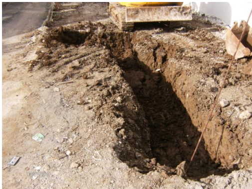
Figura 2.9 – Abertura da vala
