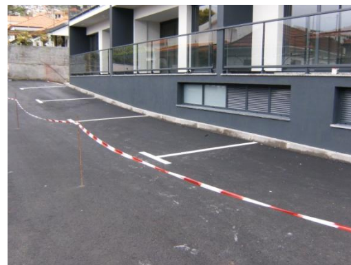
Figura 2.103 – Pintura dos traços no pavimento do estacionamento exterior asfaltado
