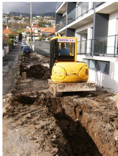
Figura 2.10 – Abertura da vala
