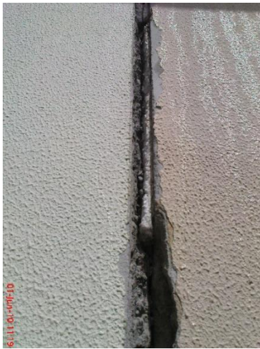
Figura 3.23 – Remoção dos materiais existentes
