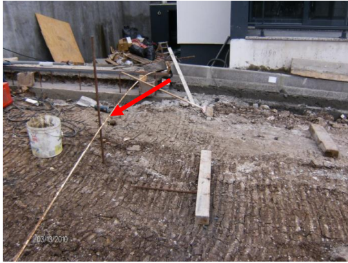
Figura 2.27 – Marcação de cotas e penderes do pavimento
