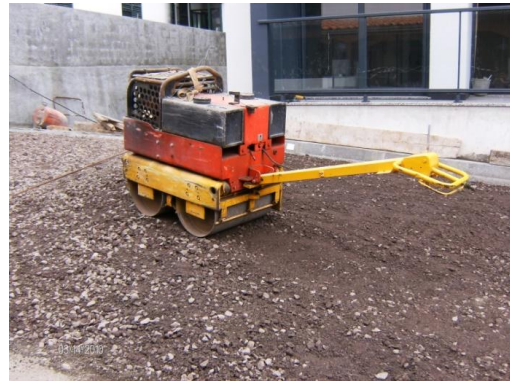
Figura 2.30 – Compactadora de rolos
