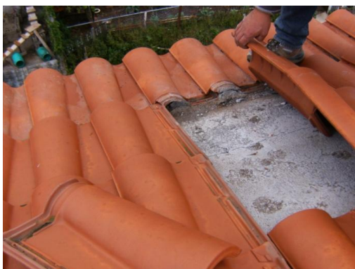
Figura 3.46 – Remoção das Telhas
