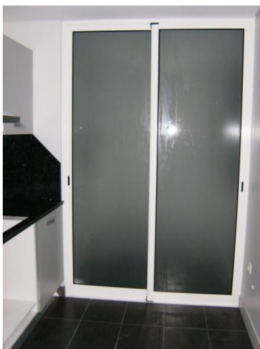
Figura 2.81 – Portada de acesso à lavandaria
