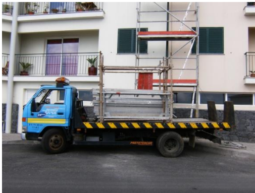
Figura 3.33 – Montagem de andaime
