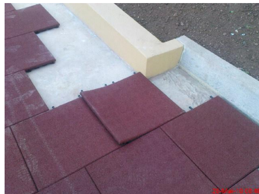
Figura 2.146 – Parque infantil, execução do pavimento sintético
