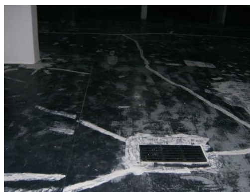
Figura 2.121 – Tratamento de fendas e zona de escoamento de águas
