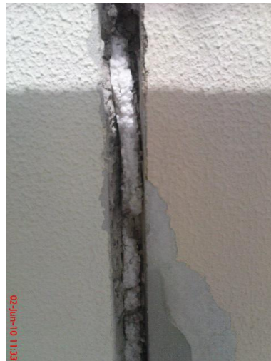
Figura 3.38 – Reparação das irregularidades na junta
