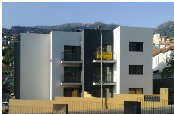
Figura 2.94 – Fachada Sudeste, pintura exterior
