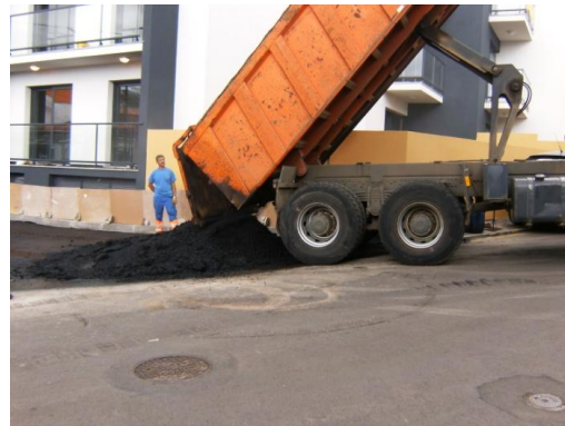
Figura 2.34 – Descarga da mistura de agregados e ligante
