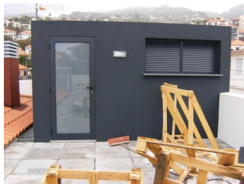
Figura 2.169 – Acumulação de paletes na cobertura
