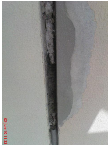
Figura 3.24 – Regularização das juntas de dilatação
