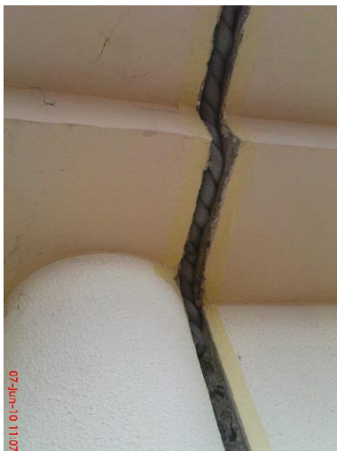
Figura 3.25 – Aplicação de cordel de polietileno entrelaçado no remate junto ao beiral
