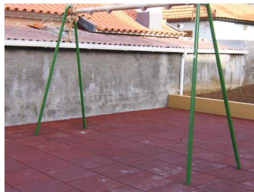
Figura 2.148 – Parque Infantil, montagem do baloiço
