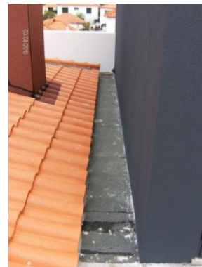
Figura 2.65 – Impermeabilização da caleira na cobertura
