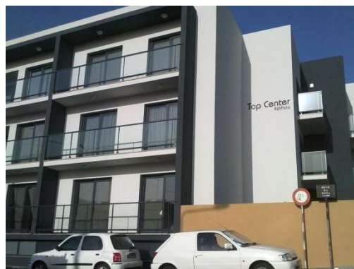
Figura 2.96 – Fachada Sudoeste, pintura exterior
