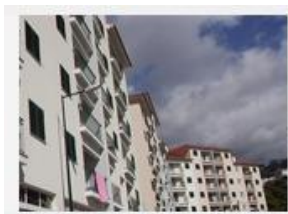
Figura 3.31 – Edifício Quintas V Fonte: AFFC
