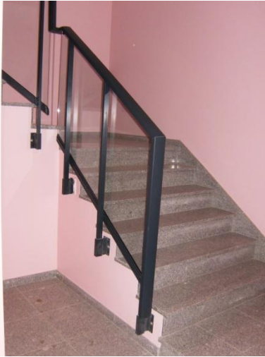
Figura 2.110 – Paredes escadaria, pintura interior
