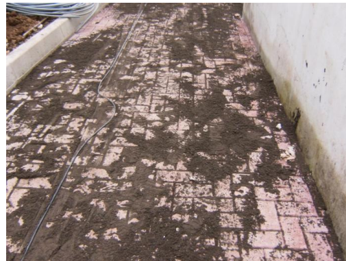
Figura 2.46 – Espalhamento de areia para preenchimento de vazios
