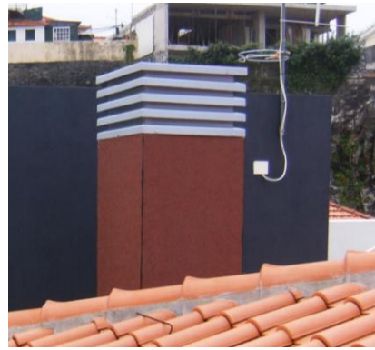
Figura 2.74 – Chaminés em chapa zincada
