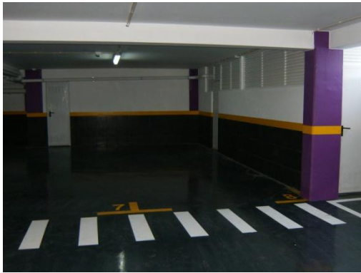
Figura 2.128 – Pintura e marcação dos algarismos de estacionamento no pavimento
