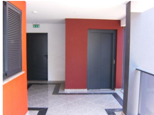
Figura 2.113 – Porta do elevador, pintura interior
