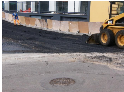
Figura 2.36 – Espalhamento da camada de agregados e ligante
