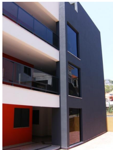
Figura 2.100 – Fachada Noroeste, pintura exterior
