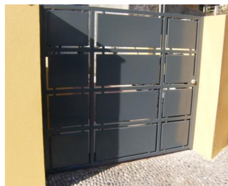
Figura 2.73 – Portão Entrada em ferro metalizado
