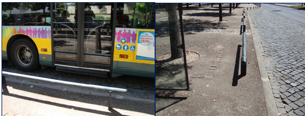
Figura 4.43 – Dissuasores de estacionamento indevido
