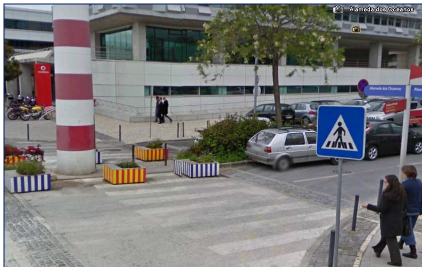
Figura 4.19 – Floreiras e pilaretes destinados a dissuadir o estacionamento indevido na passadeira
