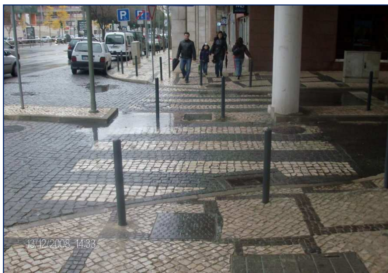
Figura 4.17 – Acumulação de água numa travessia de peões
