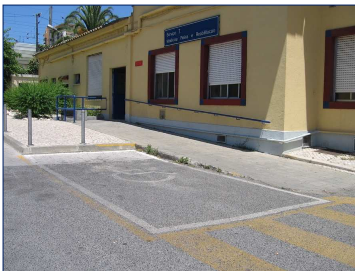
Figura 4.10 – Acesso ao Serviço de Medicina Física e Reabilitação
