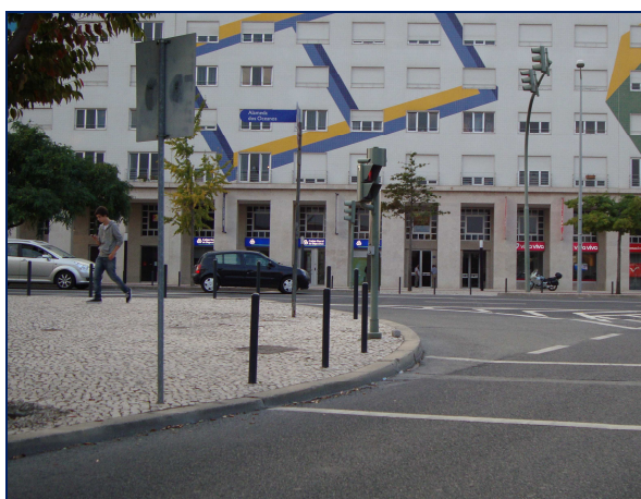
Figura 4.20 – Inexistência de passeio rebaixado junto à travessia de peões localizada no cruzamento do Passeio dos Argonautas com a Alameda dos Oceanos
