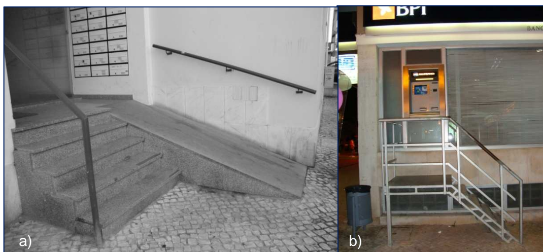
Figura 2.7 – a) Rampa de acesso a edifício com forte inclinação. b) Escadaria de acesso a MB
