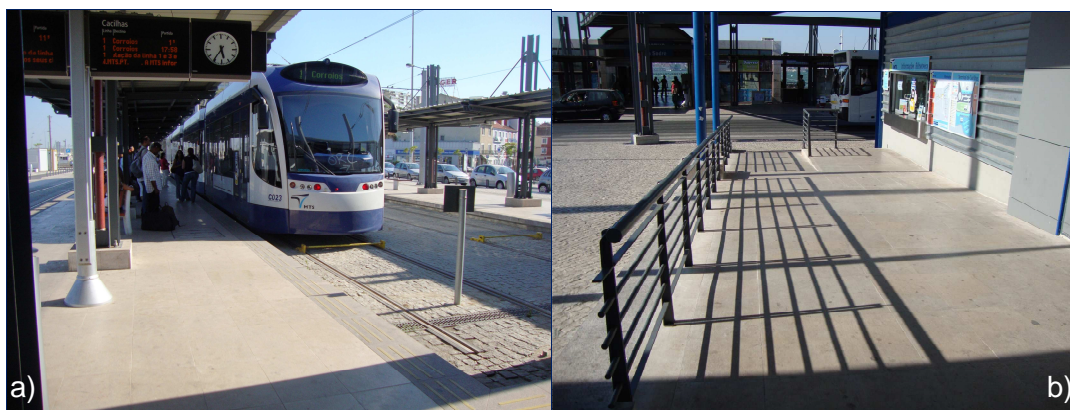
Figura 4.36– Plataforma de acesso metro MST (a) e rampa de acesso ao cais (b)
