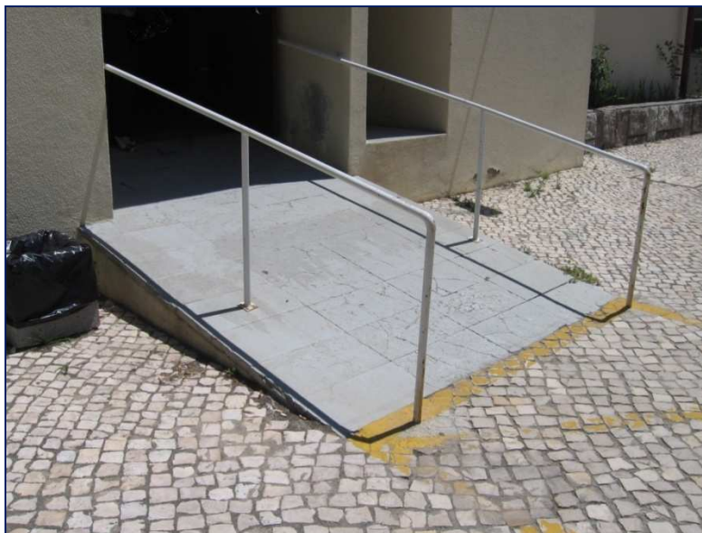
Figura 4.5 – Rampa de acesso ao Serviço de Consultas de Nefrologia
