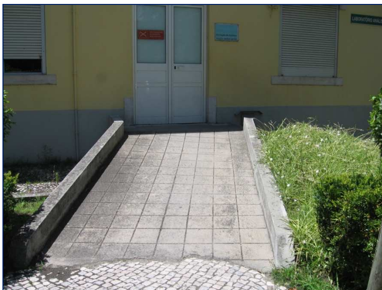
Figura 4.9 – Rampa de acesso ao Serviço de Patologia Clínica
