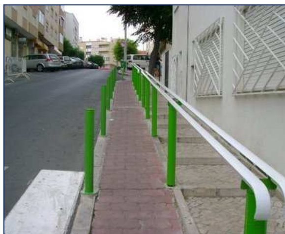
Figura 2.5 – Rampa de forte inclinação e reduzida largura, ladeada por prumos verticais
