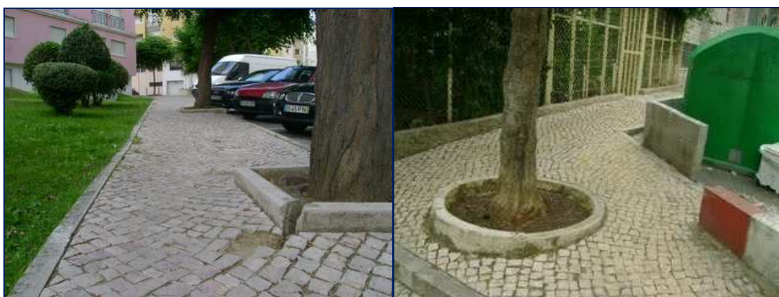
Figura 2.2 – Caldeiras de árvores no passeio, deixando pouco espaço disponível para a circulação dos peões
