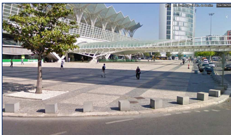
Figura 4.18 – Blocos de pedra destinados a impedir o estacionamento indevido
