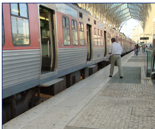
Figura 4.15 – Degrau pronunciado entre a carruagem e o nível da plataforma do cais de embarque
