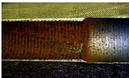
3. A rosca deste calço está bastante corroída.
