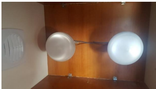
Figura 34 - Montagem das lâmpadas nos respetivos casquilhos.
