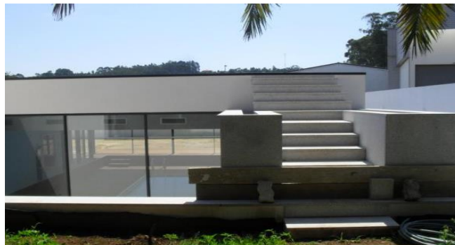
Figura 3.2 Anexo com piscina, sobre o qual se instalou a cobertura ajardinada, (Fonte: http://www.neoturf.pt , 2013)
