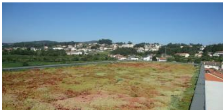
Figura 2.7 Cobertura ajardinada com sistema extensivo numa habitação em Aveleda, Braga, (Fonte: http://www.neoturf.pt , 2013)
