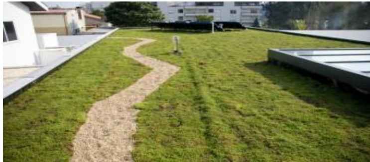
Figura 2.8 Cobertura ajardinada com sistema extensivo e vegetação tapete de “Sedum” numa habitação em Vila Nova de Gaia, (Fonte: http://www.neoturf.pt , 2013)
