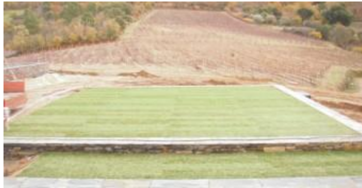
Figura 2.5 Cobertura ajardinada com sistema extensivo numa habitação em Macedo de Cavaleiros, (Fonte: http://www.neoturf.pt , 2013)
