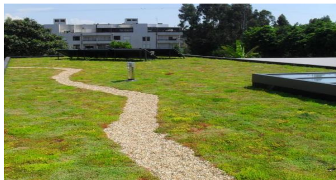
Figura 3.3 Vista da cobertura ajardinada, (Fonte: http://www.neoturf.pt , 2013)
