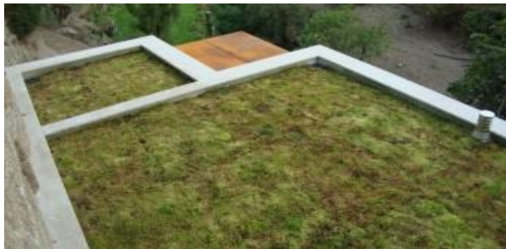
Figura 2.6 Cobertura ajardinada com sistema extensivo de habitação em Entre-Os-Rios, (Fonte: http://www.neoturf.pt , 2013)
