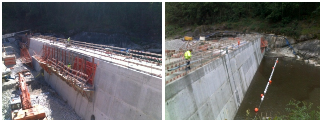
Figura 3.46 – Finalização dos Trabalhos na Ensecadeira de Jusante, (Arquivo Pessoal).
