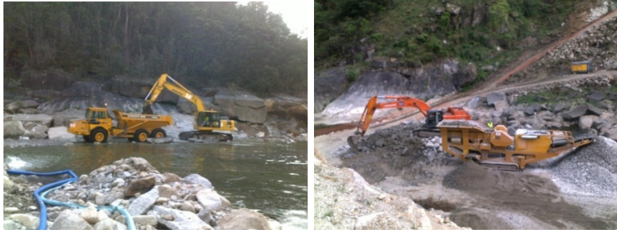
Figura 3.32 – Britagem do Material Rochoso Retirado do Rio, (Arquivo Pessoal).
