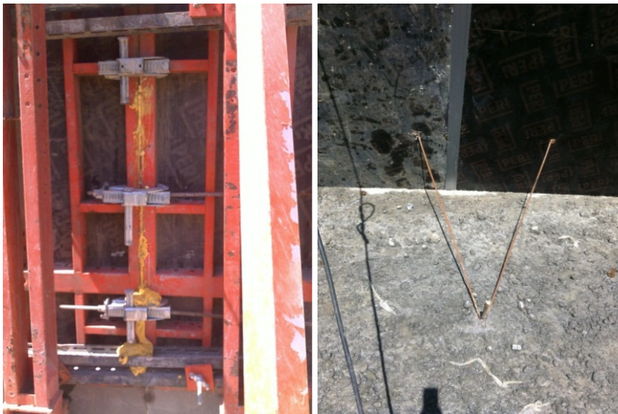
Figura 3.31 – Isolamento das Juntas Verticais das Cofragens, (Arquivo Pessoal).
