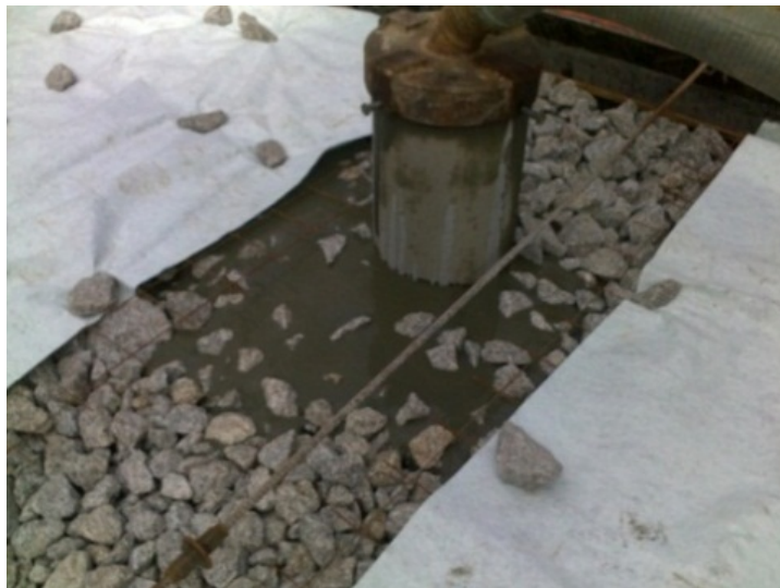
Figura 3.38 – Geotêxtil Sobre a Camada de Agregado, (Arquivo Pessoal).
