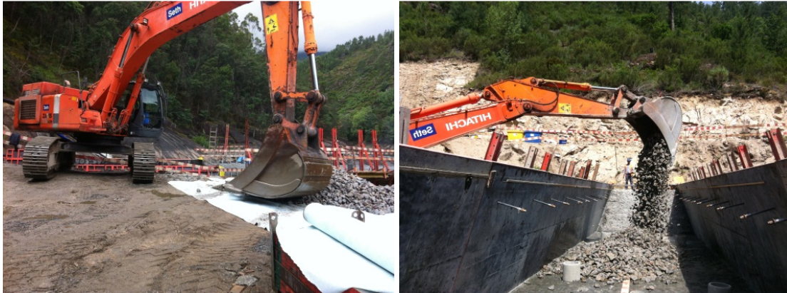
Figura 3.35 – Colocação do Agregado nos Blocos, (Francisco Romãozinho, 2012).
