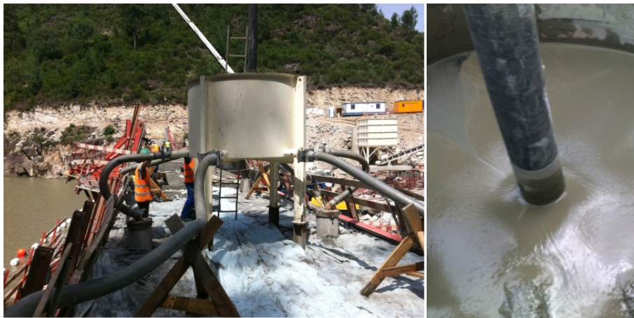
Figura 3.40 – Aplicação da Argamassa, (Arquivo Pessoal).
