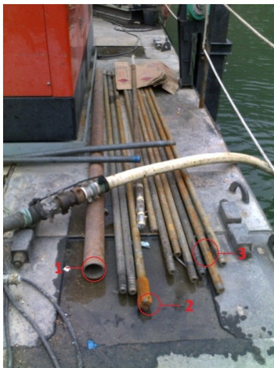
Figura 3.15 – Equipamento para Perfuração Submersa. Legenda: 1) Casing; 2) Bit; 3) Barrenas, (Arquivo Pessoal).
