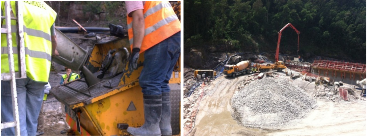
Figura 3.39 – Bombeamento da Argamassa, (Arquivo Pessoal).
