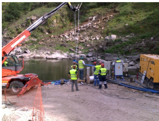
Figura 3.10 – Instalação das Bombas de Derivação, (Arquivo Pessoal).
