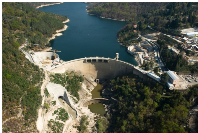
Figura 2.3 – Barragem de Salamonde, (Contrusalamonde, 2012).
