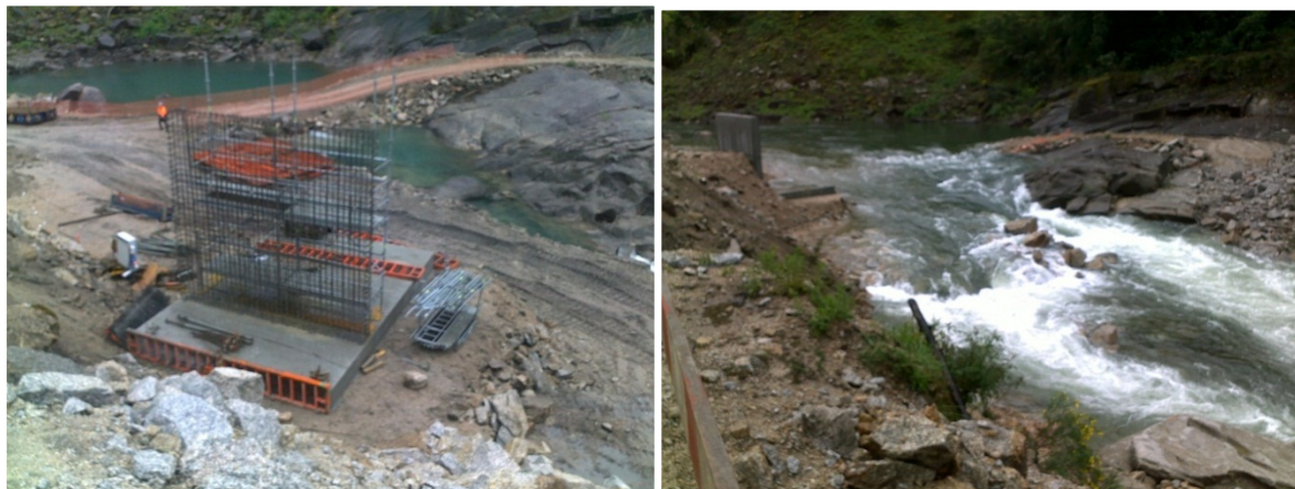
Figura 3.18 – Plataforma de Trabalhos Antes e Durante a Abertura das Comportas, (Arquivo Pessoal).
