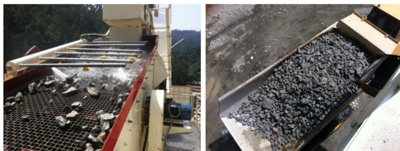
Figura 3.34 – Processo de Lavagem e Crivagem do Agregado, (Francisco Romãozinho, 2012).
