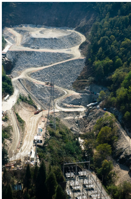
Figura 3.2 – Vista Geral da Escombreira, (Construsalamonde A.C.E., 2012).
