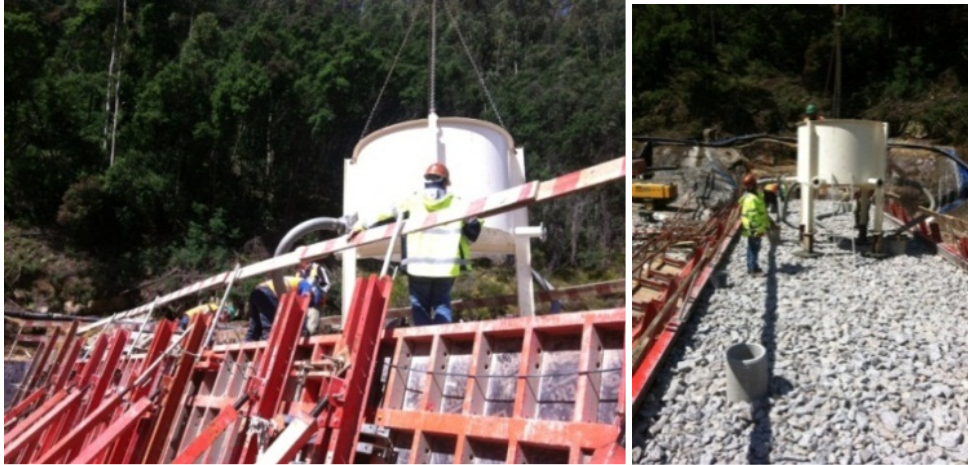
Figura 3.37 – Colocação do Depósito e das Mangueiras de Distribuição, (Francisco Romãozinho, 2012).
