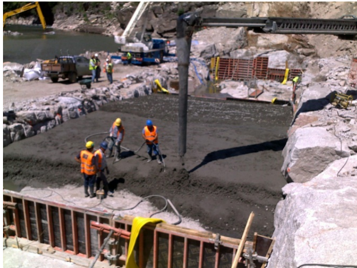
Figura 3.30 – Vibração do Betão, (Arquivo Pessoal).
