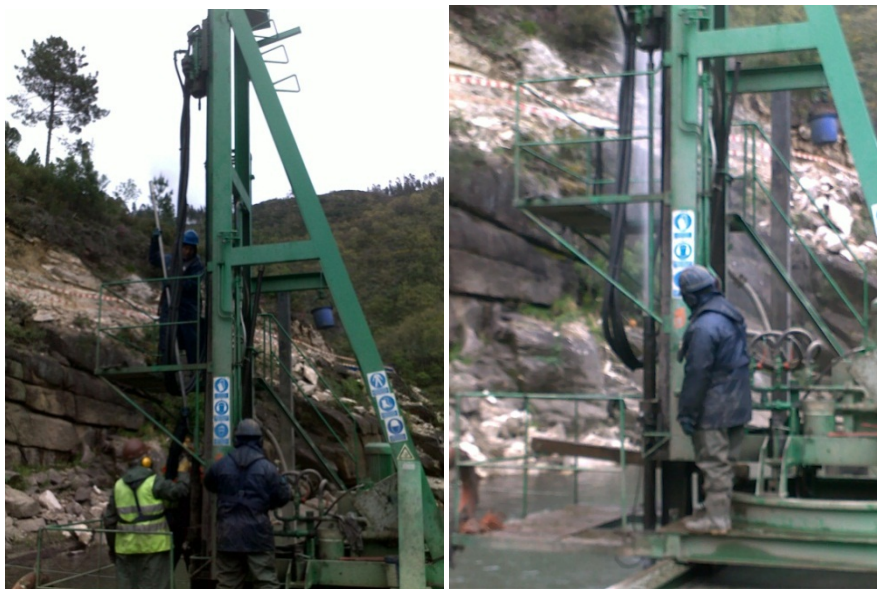
Figura 3.16 – Colocação da Barrena e Perfuração Subaquática, (Arquivo Pessoal).
