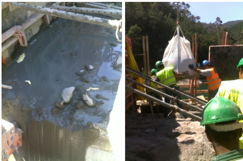
Figura 3.45 – Operação de Estancagem de Fuga de Argamassa, (Arquivo Pessoal).
