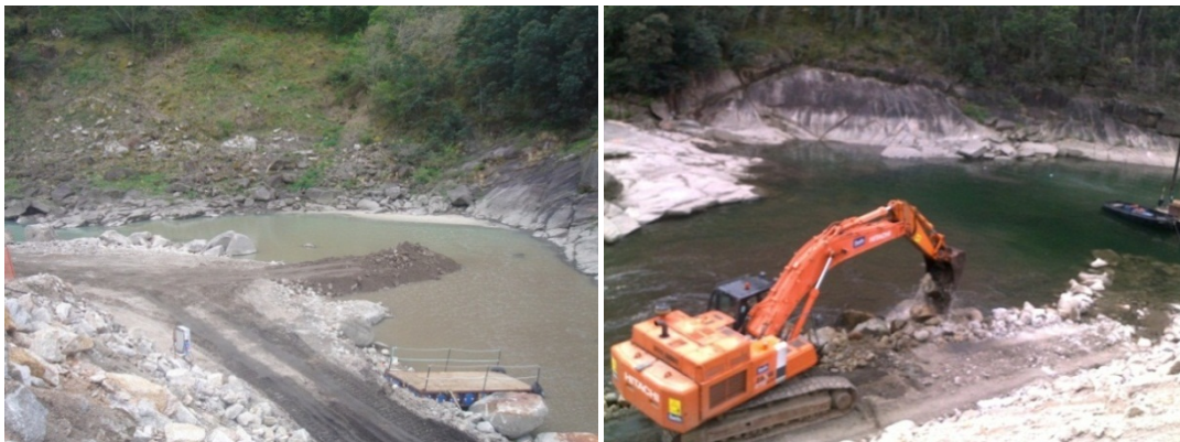
Figura 3.17 – Preparação da Plataforma de Trabalhos, (Arquivo Pessoal).
