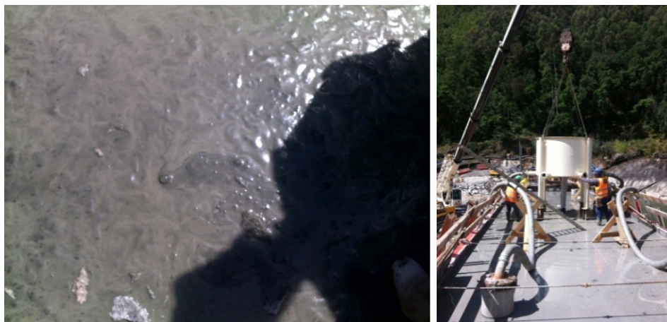
Figura 3.41 – Fim da Aplicação da Argamassa, (Arquivo Pessoal).
