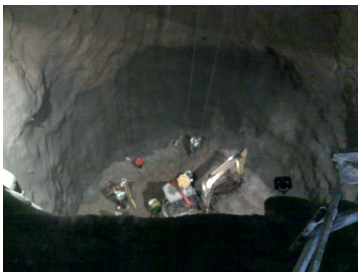
Figura 2.12 – Limpeza de Escombros no Trecho Vertical de Adução (Arquivo Pessoal).
