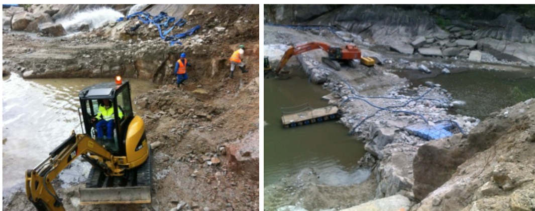
Figura 3.25 – Trabalhos de Limpeza da Rocha de Fundação, (Arquivo Pessoal).
