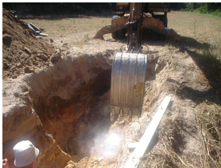
Figura 25: Escavação entre as caixas E26 e E34.
