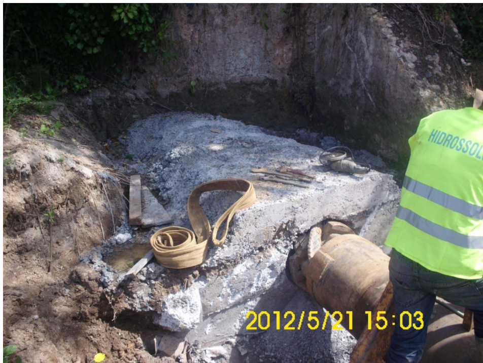
Figura 7: Maciço de betão para direcionamento e nivelamento da perfuração
