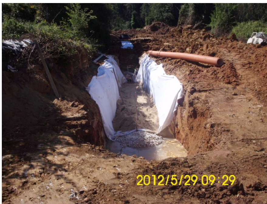
Figura 41: Colocação de tubagem em zona com nível freático.
