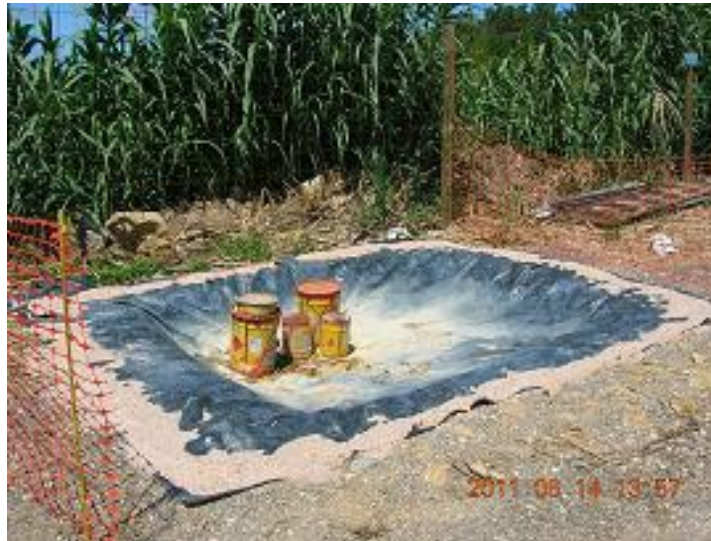
Figura 46: Bacia de retenção para armazenamento de resíduos.
