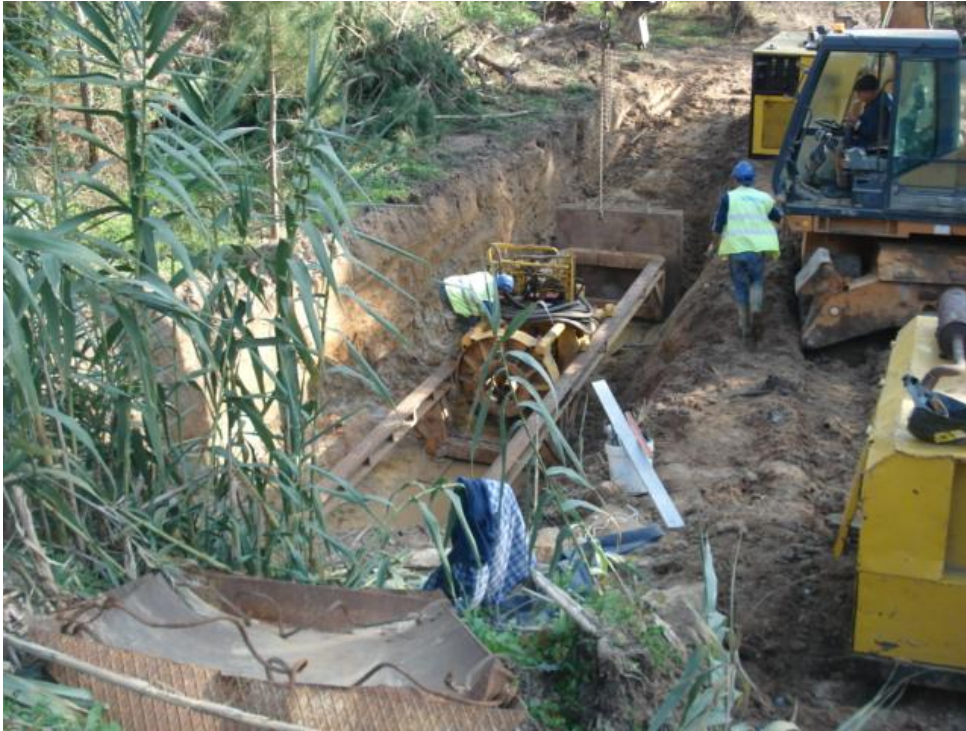
Figura 6: Colocação do equipamento de perfuração
