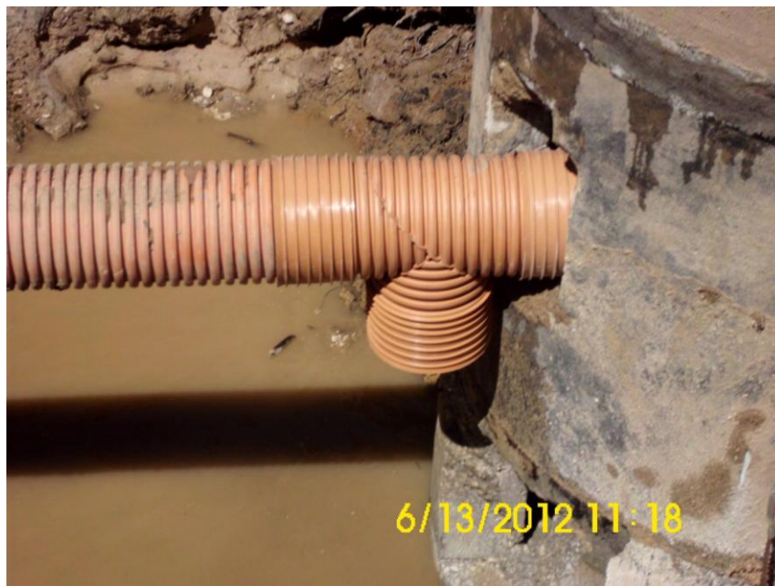
Figura 15: Execução da queda guiada, colocação do tubo em T.
