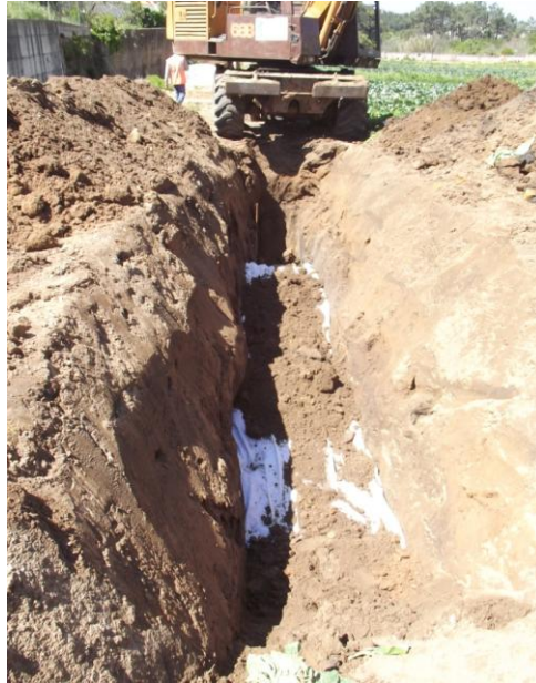
Figura 26: Escavação entre as Caixas E28 e E29.
