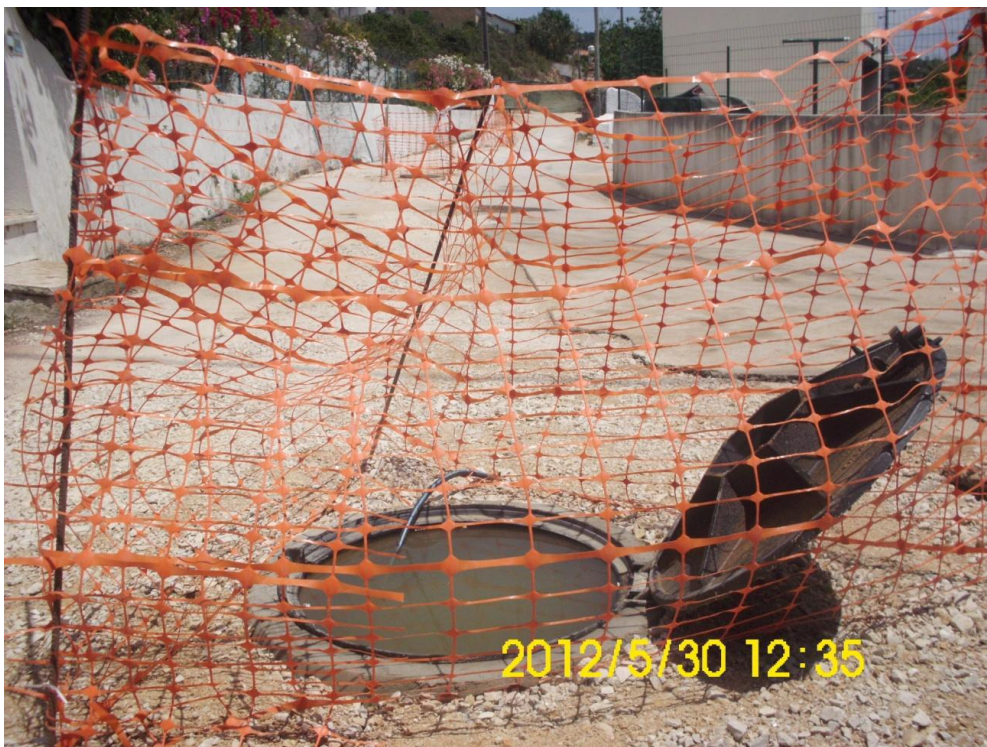
Figura 18: Ensaio a caixa de visita.
