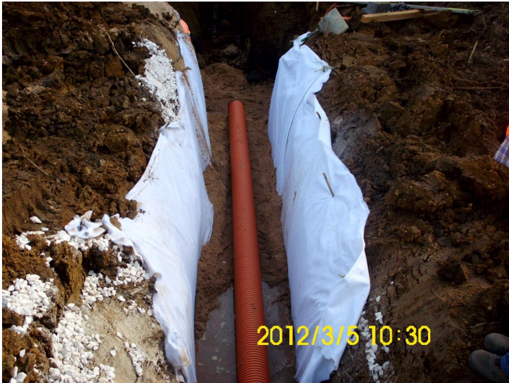
Figura 3: Colocação de tubagem em zonas de nível freático
