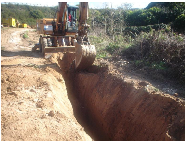
Figura 21: Escavação próxima da caixa D41.
