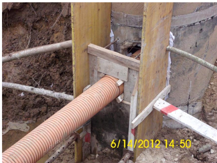
Figura 16: Cofragem para execução do maciço para a queda guiada.
