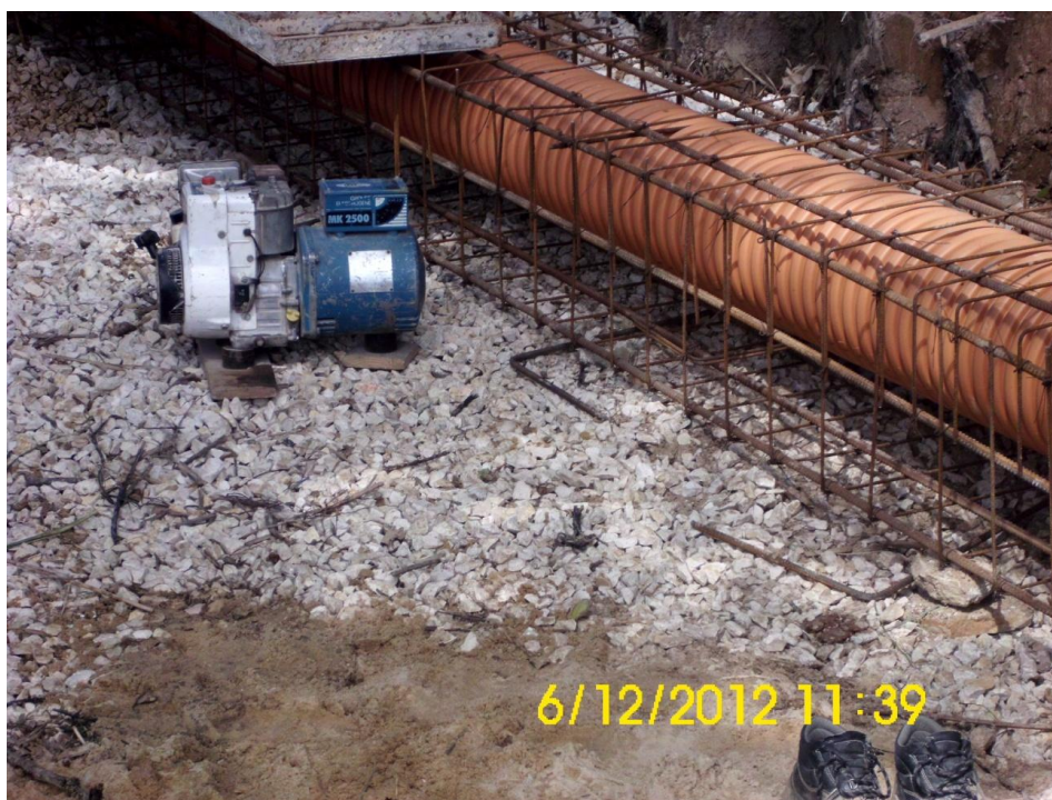
Figura 5: Execução de cofragem para tubagem em leito de cheia
