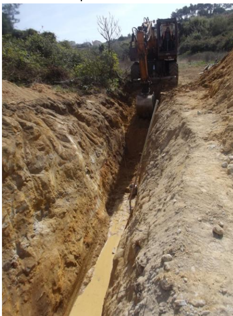
Figura 23: Escavação próxima da caixa D18.
