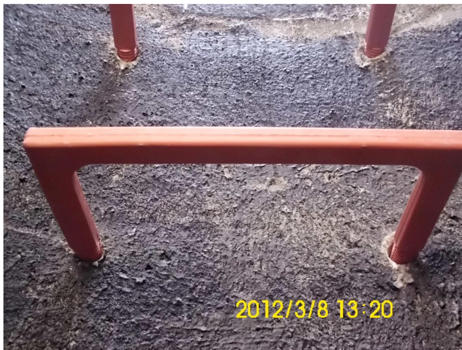
Figura 11: Pormenor dos degraus.
