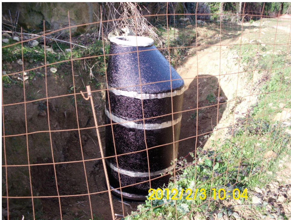
Figura 12: Vista de caixa de visita pintada e com tela alumino-asfáltica.
