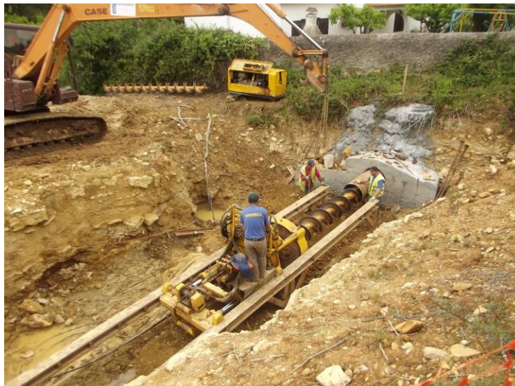
Figura 20: Escavação e perfuração entre as caixas D53 e D54.
