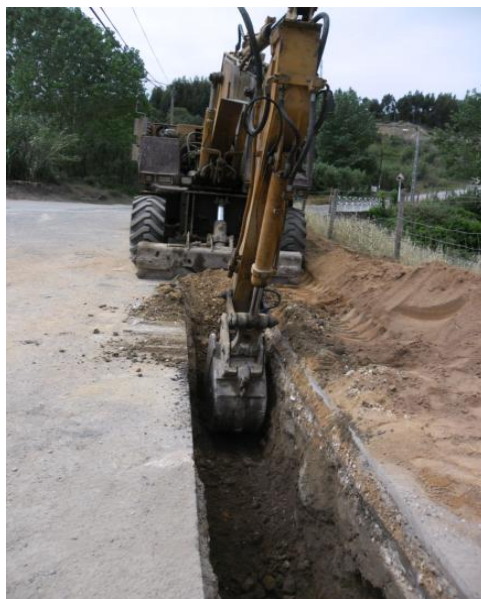
Figura 27: Escavação Entre as caixas F2 e F3.
