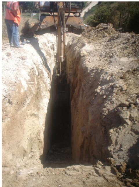
Figura 22: Escavação entre as caixas D38 e D37
