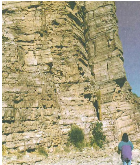
Figura 39 – Maciço muito fracturado [37].
