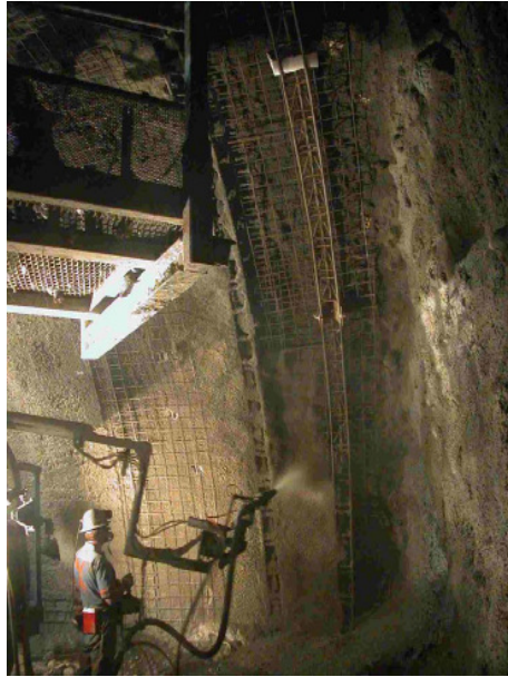
Figura 64 – Projecção mecânica de betão [30].
