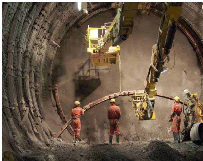
Figura 59 – Colocação de cambotas metálicas [adaptado de Vuilleumier, François].
