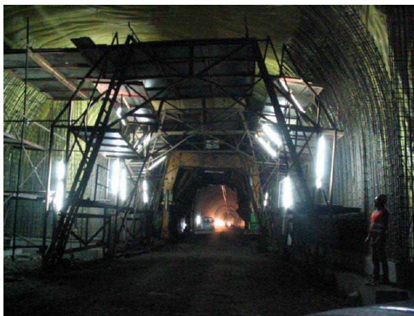
Figura 71 – Aplicação de armadura [21].
