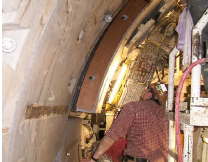
Figura 60 – Colocação de aduelas.
