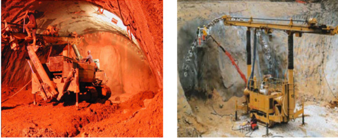
Figura 62 – Colocação de enfilagens [30].
