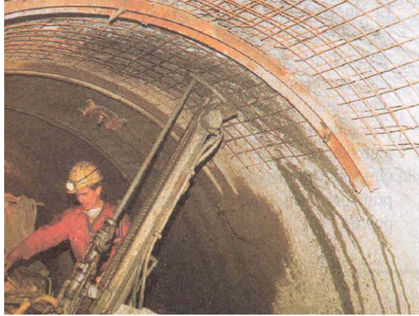
Figura 65 – Colocação de pregagens [37].
