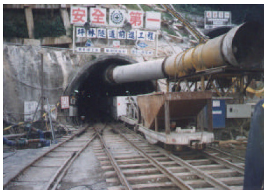
Figura 18 – Vagões para transporte de material escavado [adaptado de Barla, Giovanni].
