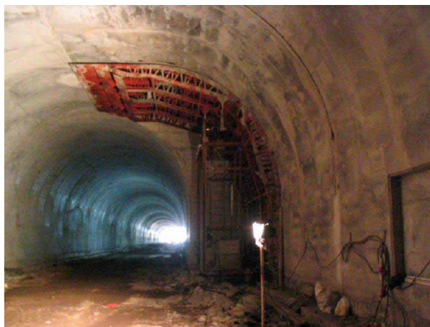
Figura 70 – Sistema de cofragens deslizantes [21].
