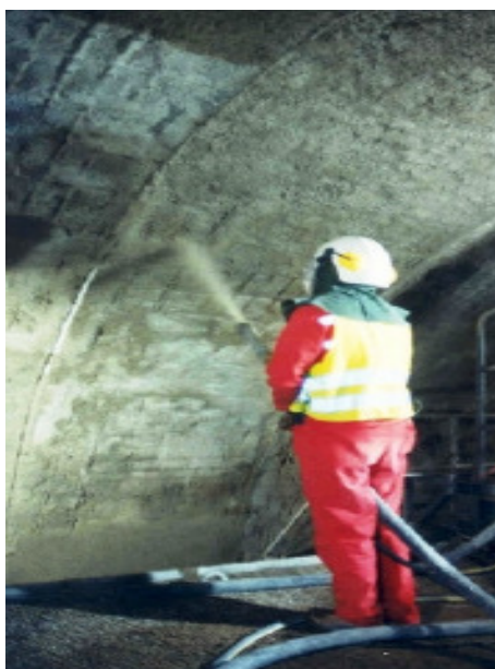
Figura 63 – Projecção manual de betão [30].
