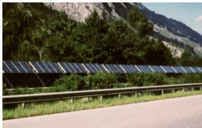
Figura 2.20 - Barreira acústica na A13, Suíça.
