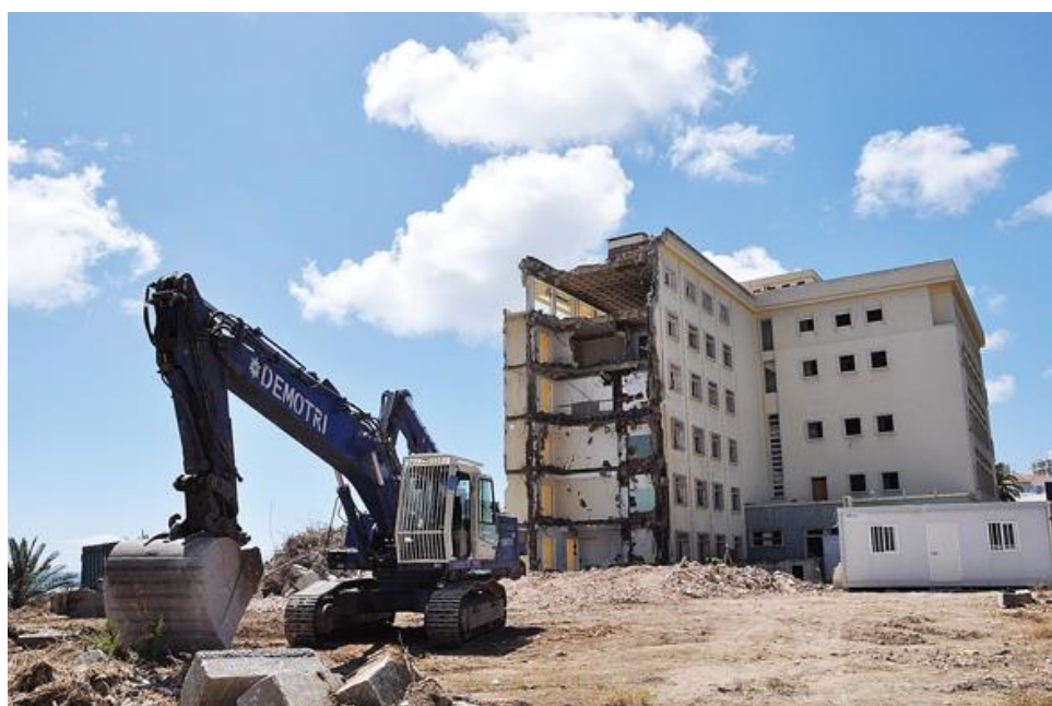
Fig. 32: Demolição do Hotel Atlântico.
