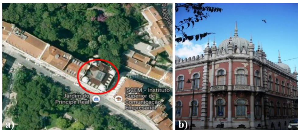
Figura 7.1 - a) Localização do Palacete; b) Fachada do Palacete Ribeiro da Cunha
