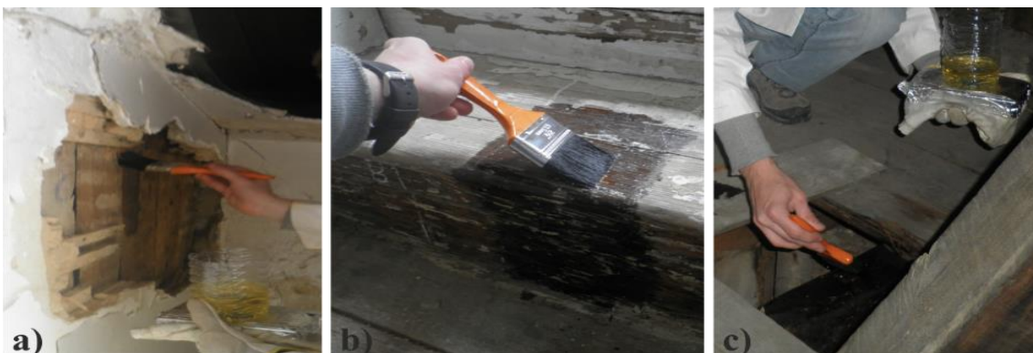
Figura 7.8 - Aplicação do consolidante a) Costaneira; b) Escadas; c) Vigas do pavimento
