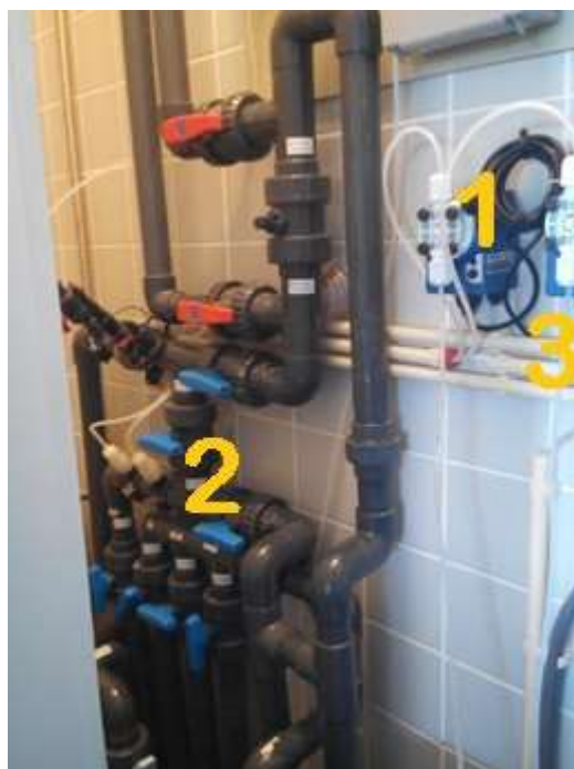
Figura 27 – Constituição do circuito do tanque de marcha
