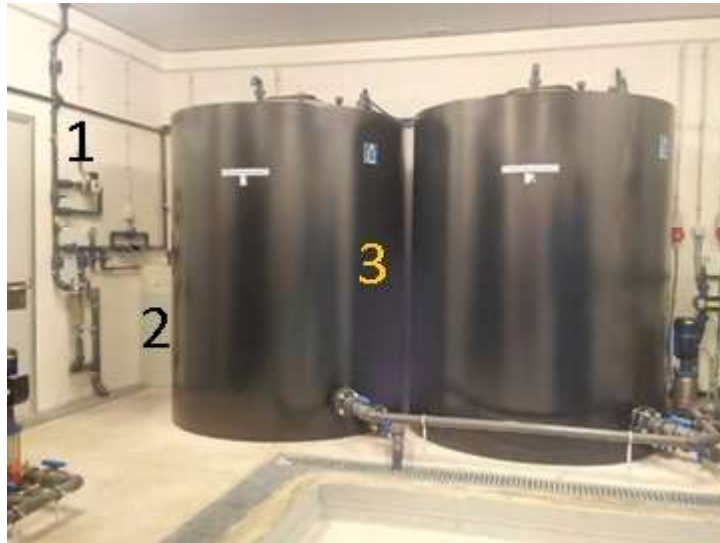
Figura 22 - Reservatório de água bruta – Hemodiálise
