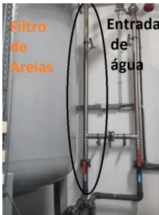
Figura 7 - Entrada de água no hospital (destacado a preto)
