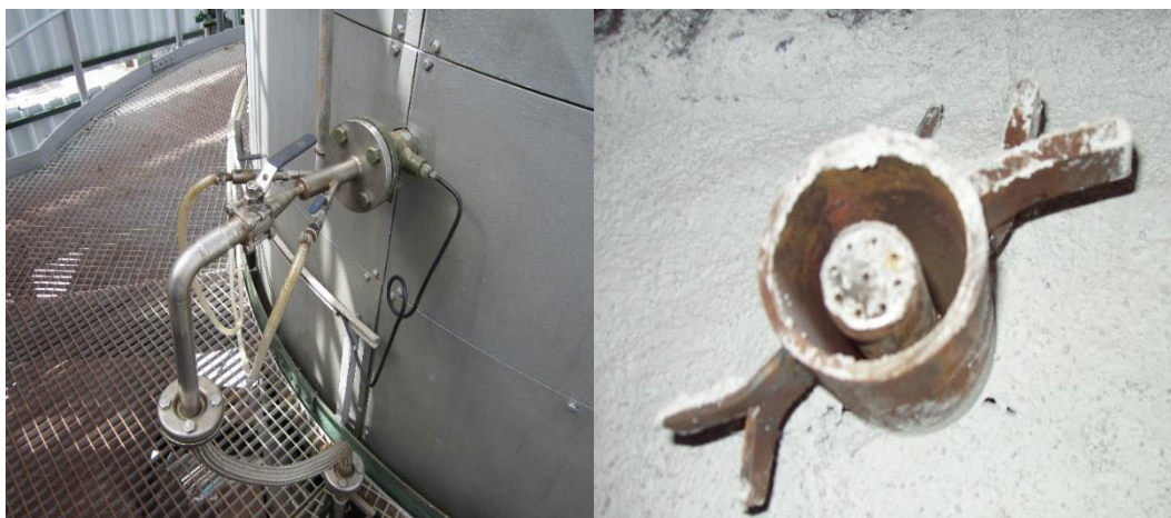
Figura 9 - Injetor de ureia e de amónia na câmara de combustão
