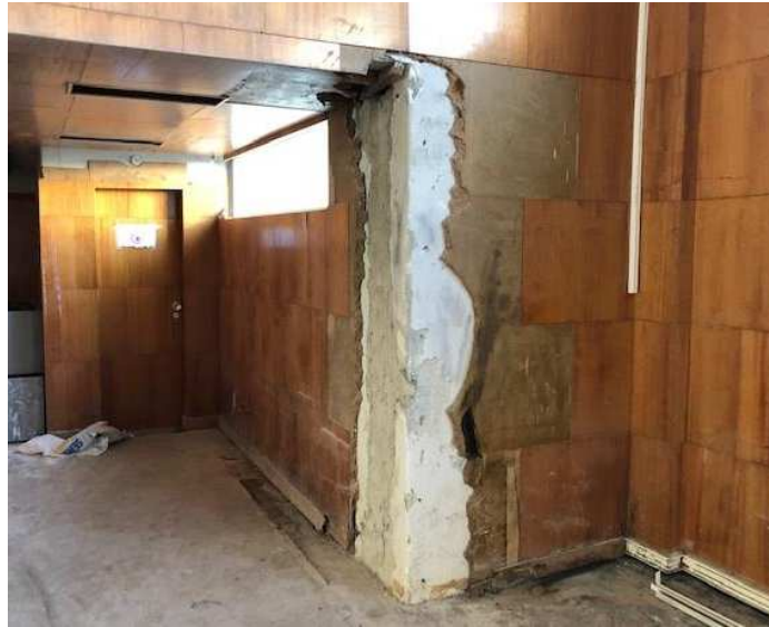
Figura 2.7 Revestimento das paredes do piso 0
