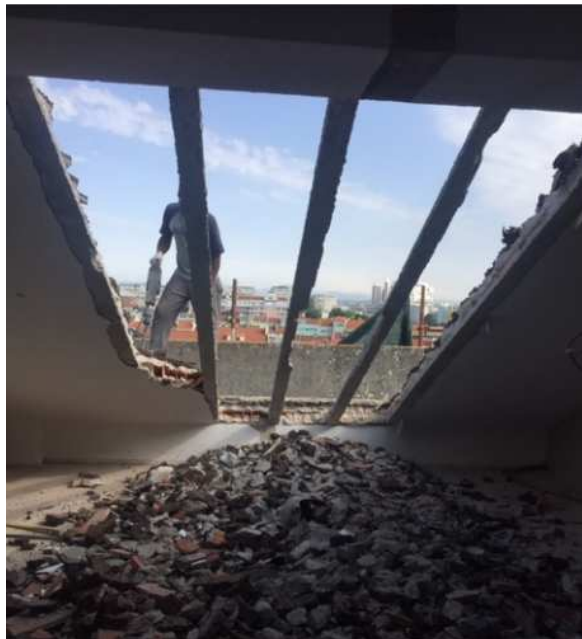
Figura 4.4 Desmonte da estrutura da cobertura.
