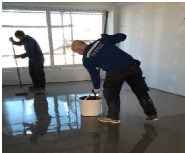
Figura 4.26 Pintura do pavimento.
