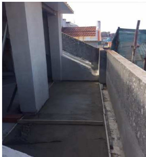
Figura 4.9 Aplicação da camada de forma em betonilha
