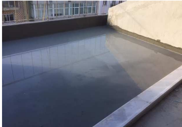
Figura 4.11 Teste de estanqueidade do terraço
