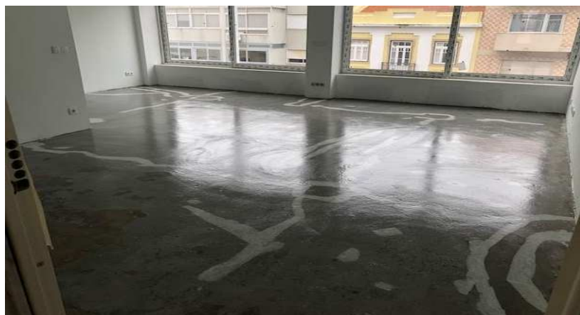
Figura 4.18 Aspeto do pavimento com o primário
