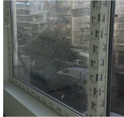
Figura 3.14 Detalhe do caixilho instalado.
