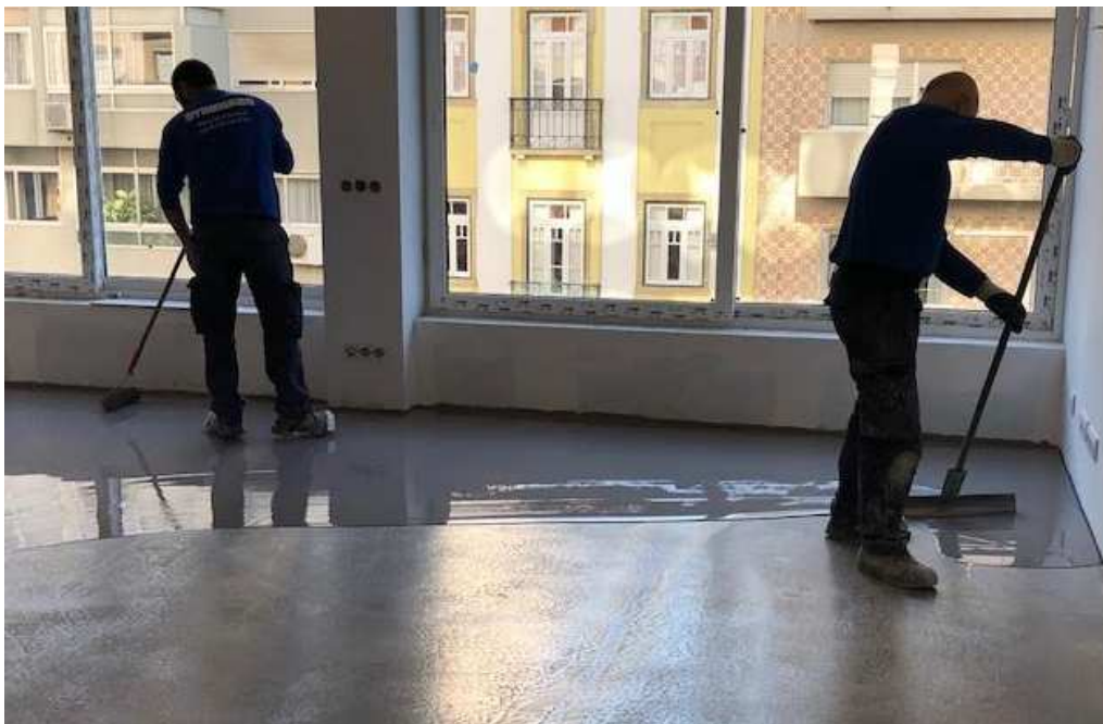
Figura 4.22 Aplicação da base do revestimento
