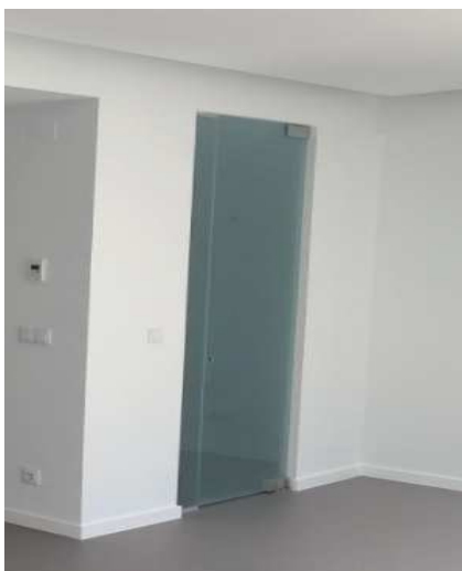
Figura 4.34 Porta da instalação sanitária.
