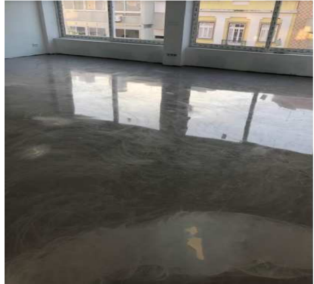
Figura 4.25 Aspeto do pavimento após passagem da lixa.
