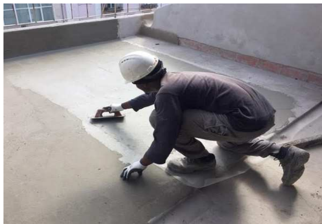
Figura 4.10 Aplicação da impermeabilização do terraço
