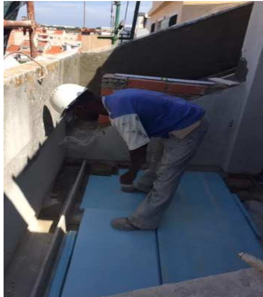
Figura 4.8 Aplicação do isolamento térmico
