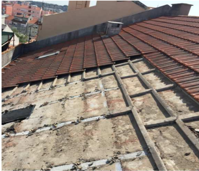
Figura 4.3 Remoção dos revestimentos da cobertura – Telhas e ripas.
