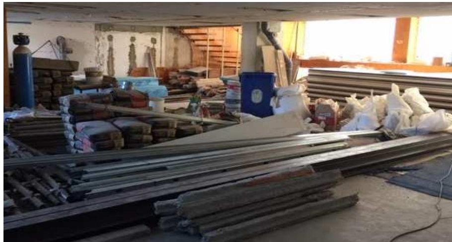
Figura 4.1 Estaleiro da obra.
