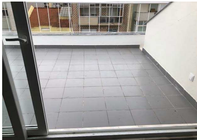
Figura 4.12 Revestimento dos terraços do piso 6
