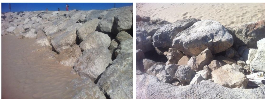
Figura 3.10. Constituição das estruturas de proteção (09/09/2016)
