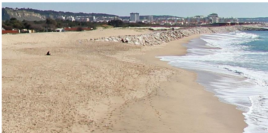
Figura 3.9. Zona sem e com estrutura de proteção aderente na praia de S. João da Caparica (adaptado do Google Earth)
