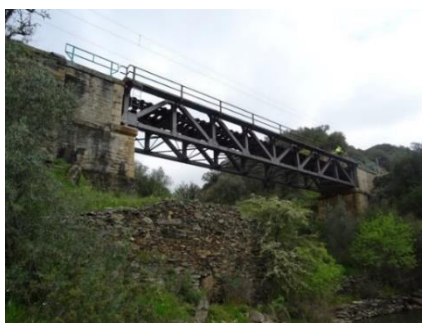
Figura 2.2 - Exemplo de uma ponte em viga simplesmente apoiada: Linha da Beira Baixa, Ponte da Presa.
