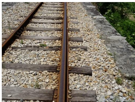
Figura 2.27 - Fixação de carril rígida.
