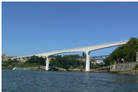
Figura 4.6 – Vista geral da Ponte de São João, inserida ao Pk 334,542 da Linha do Norte.
