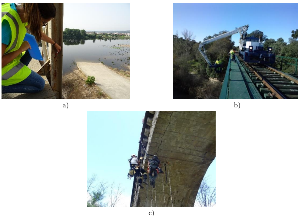
Figura 4.1 – Métodos de inspeção: a) Inspeção visual, b) Dresine de inspeção de pontes e c) Inspeção com acesso por cordas.
