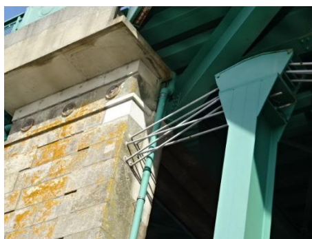
Figura 4.16 –Passagem dos cabos pelas alvenarias, na Ponte do Lima.
