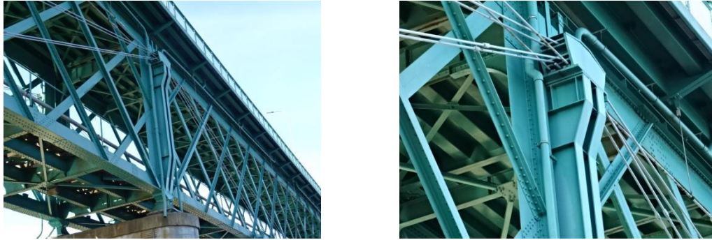
Figura 4.14 - Reforço por aplicação de pré-esforço exterior: Ponte do Lima.
