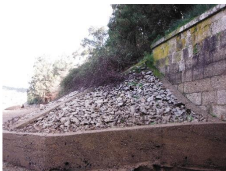
Figura 2.14 - Talude não vegetal.
