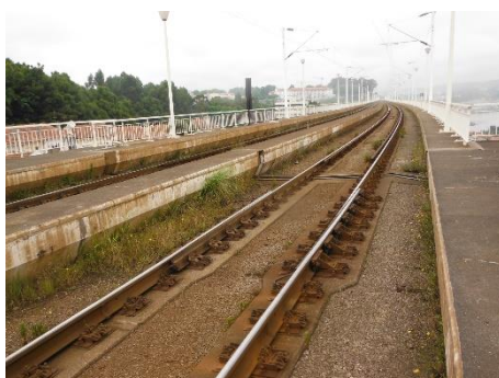
Figura 4.7 – Vista da plataforma ferroviária da Ponte de São João.
