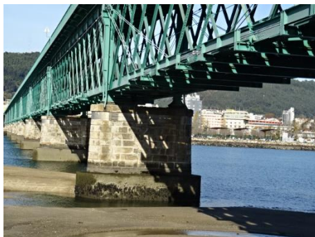
Figura 4.4 – Vista geral da Ponte do Lima, inserida ao Pk 080,057 da Linha do Minho.
