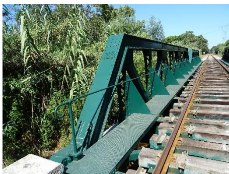
Figura 2.34 – Proteção de superfície em perfeitas condições.
