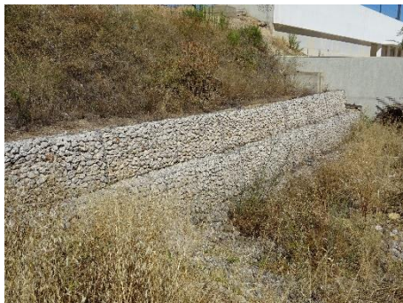
Figura 2.11 - Muro de contenção.
