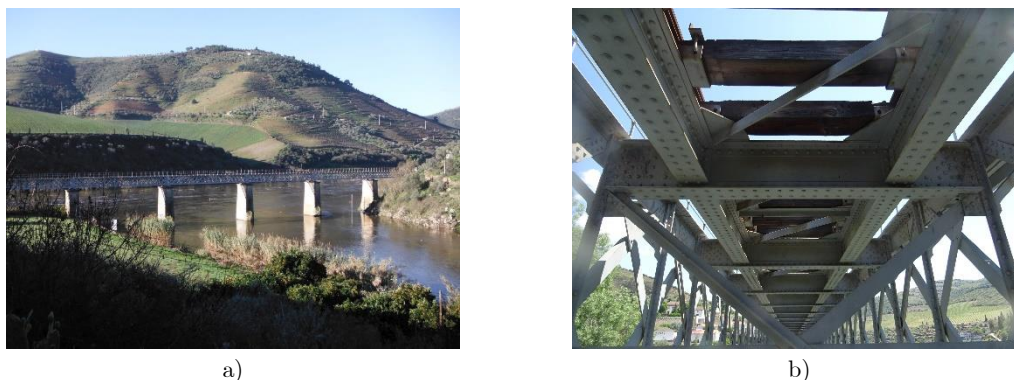
Figura 4.9 - Ponte ferroviária do Tua: a) Vista geral e b) Vista da face inferior do tabuleiro.
