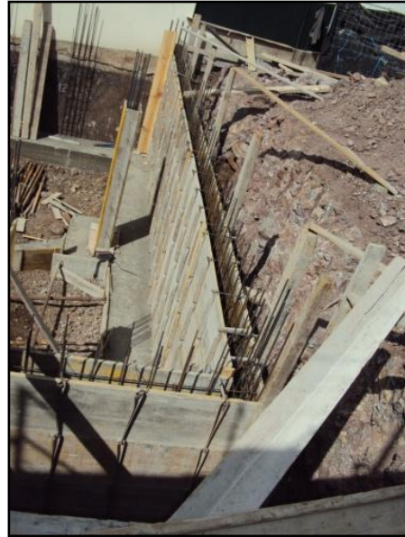
Fig.50 - Pano exterior e interior do muro da cave
