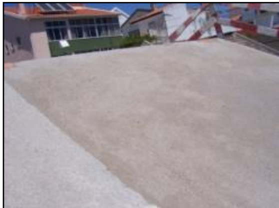
Fig.90 - Betonilha da laje de cobertura
