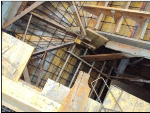
Fig.62 - Cofragem e armação da caixa de escadas
