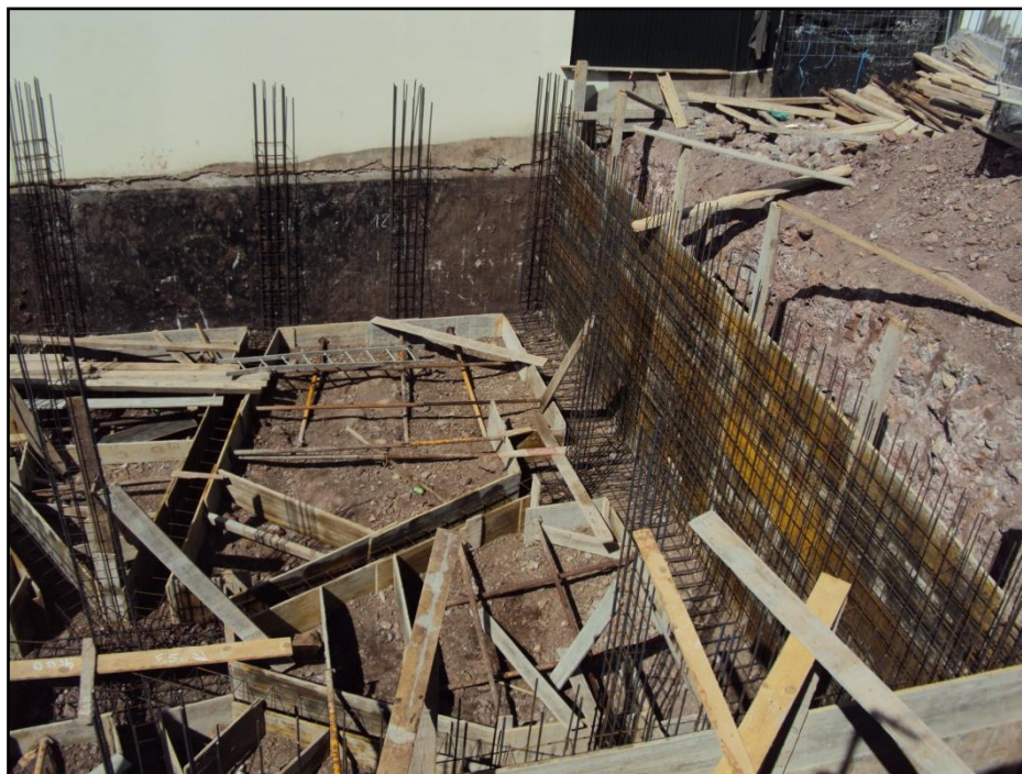
Fig.34 - Fundações armadas e escoradas imediatamente antes da sua betonagem
