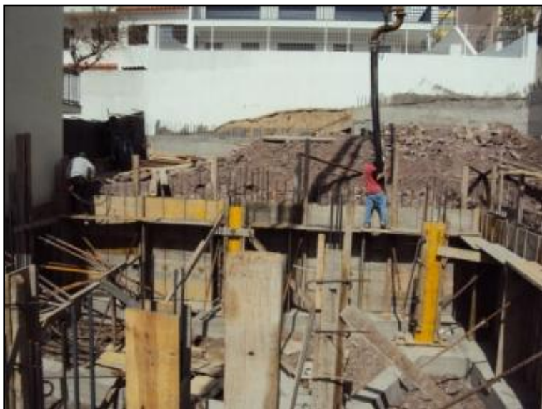
Fig.52 - Betonagem do muro da cave
