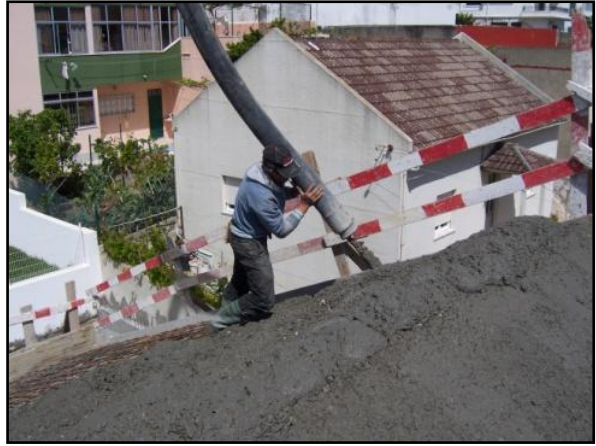
Fig.88 - Betonagem da Laje de Cobertura
