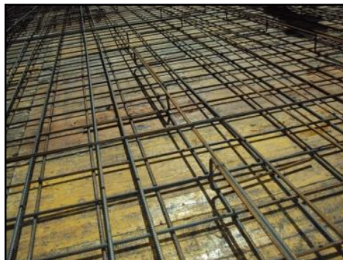
Fig.64 - Pormenor de Cavalete
