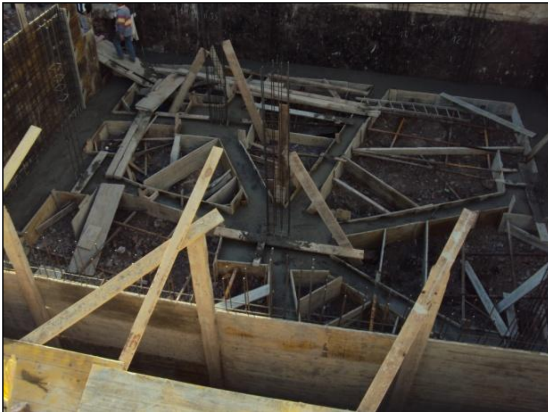
Fig.42 - Conclusão da betonagem das sapatas e vigas de fundação
