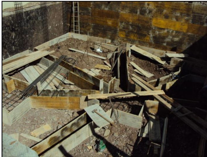
Fig.27 -Cofragem das vigas de fundação e maciços das sapatas de fundação
