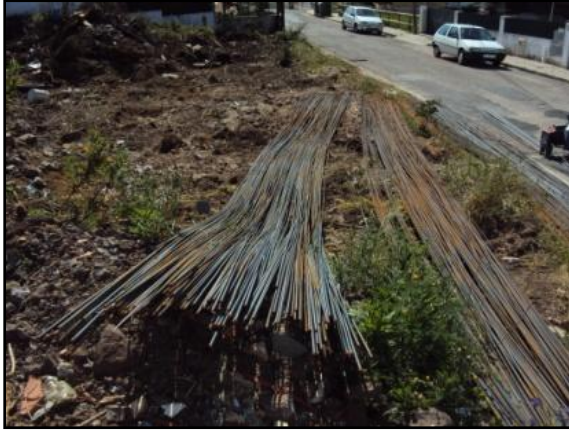
Fig.29 - Varões de Aço A400 de 12 m
