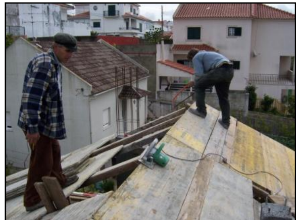
Fig.81 - Cofragem da laje de cobertura
