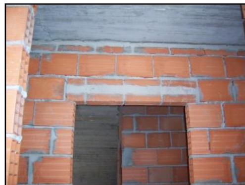
Fig.126 - Verga colocada no topo de porta interior
