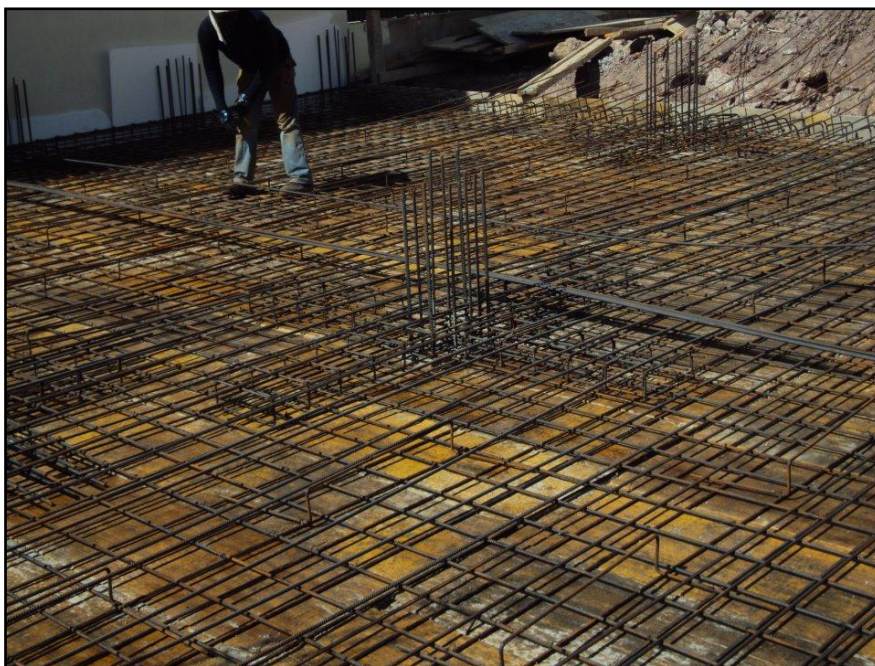
Fig.67 - Pormenor de capitel terminado onde se vêem as armaduras específicas de punçoamento.
