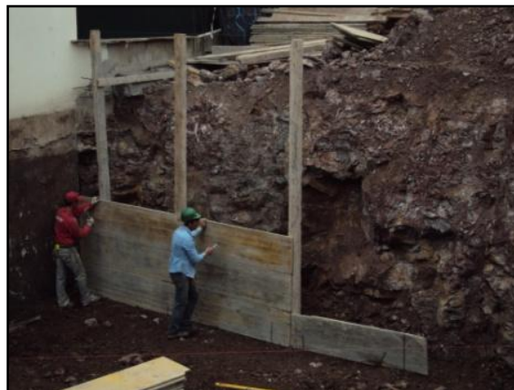
Fig.25 – Cofragem do pano exterior do muro da cave
