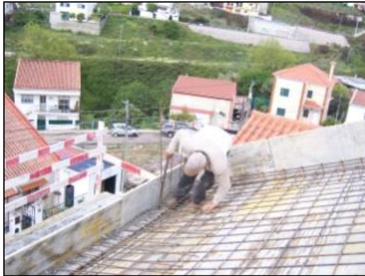
Fig.84 - Dobragem de armaduras em espera das viga invertida do sótão para a malha superior da laje de cobertura
