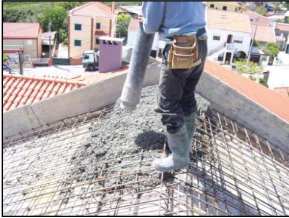
Fig.87 - Betonagem da Laje de Cobertura
