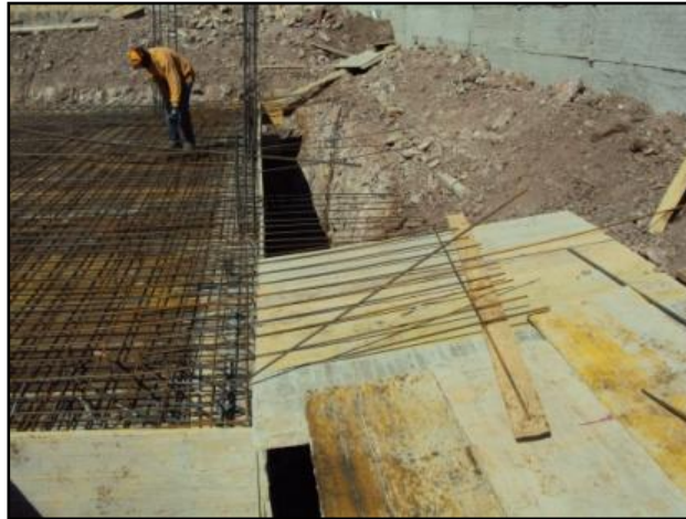
Fig.65 - Armaduras de arranque para passeio
