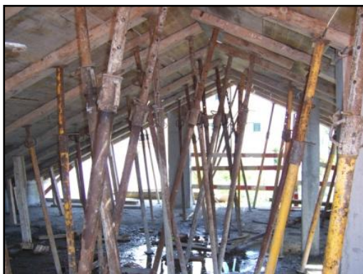
Fig.82 - Escoramento com prumos metálicos extensores
