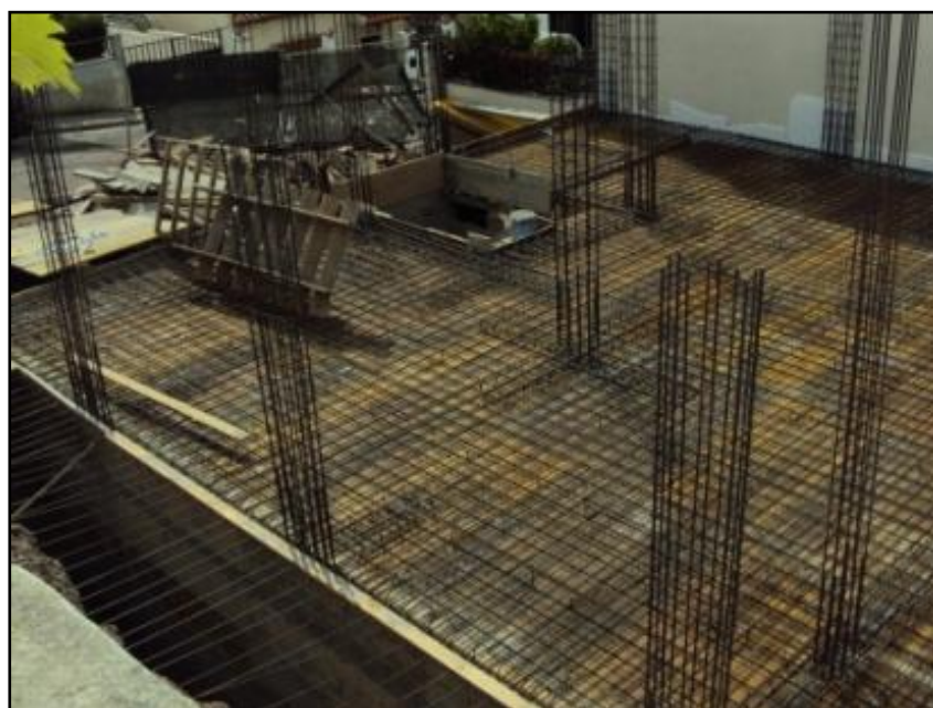
Fig.68 - Conclusão da armação da laje do teto da cave
