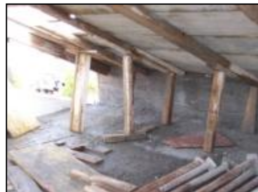
Fig.83 - Escoramento com barrotes de madeira
