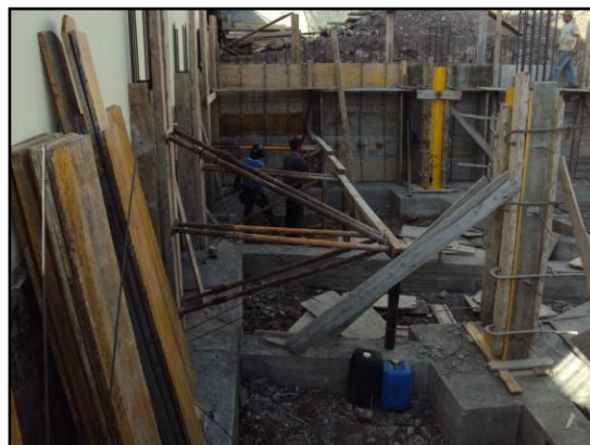
Fig.46 - Cofragem e escoramento dos pilares
