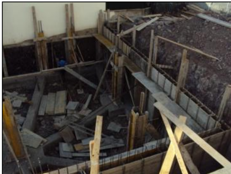
Fig.51 - Construção de passadiço em madeira para posterior betonagem
