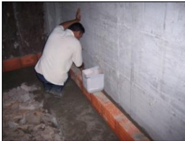
Fig.129 -Impermeabilização da caleira
