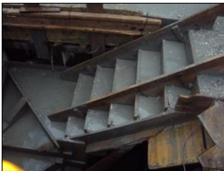
Fig.71 -Betonagem da caixa de escadas
