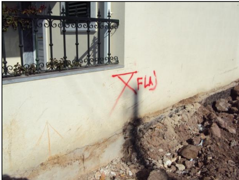
Fig.15 - Marcação na parede do lote 471 que assinala o fundo da laje do piso 0
