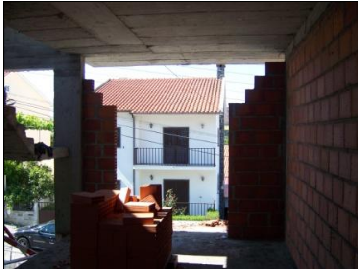
Fig.113 - Folga deixada para colocação de caixa de estores
