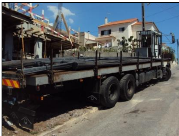
Fig.133 - Camião de transporte de aço
