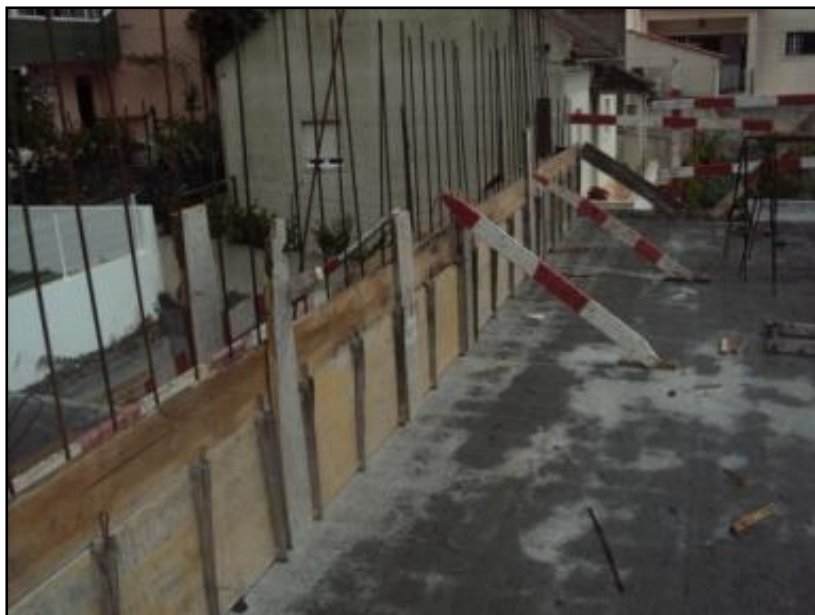
Fig.75 - Cofragem de viga invertida com armaduras em espera
