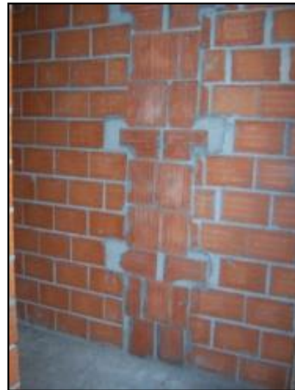
Fig.123 - Pilar totalmente forrado pelo interior
