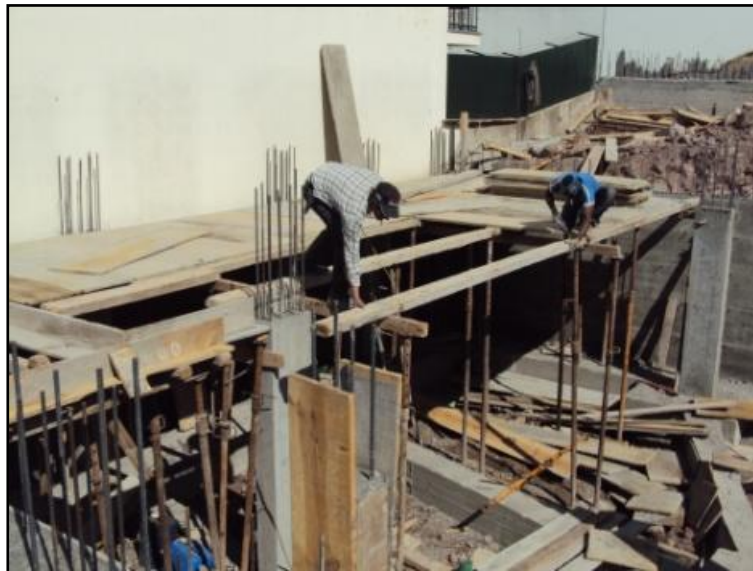
Fig.57 - Início dos trabalhos de cofragem do teto da cave
