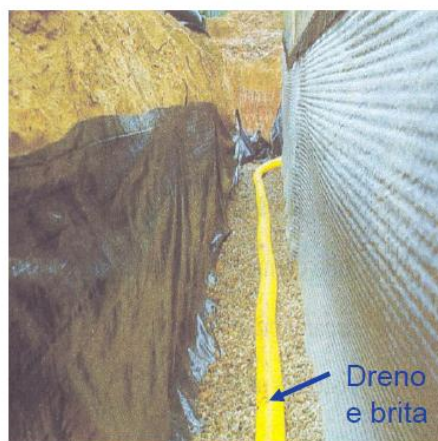
Fig.104 - Dreno e brita
