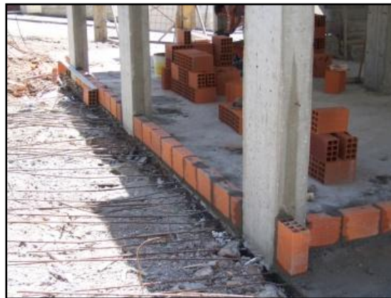
Fig.108 -Início do levantamento das paredes exteriores – pano exterior
