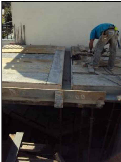
Fig.59 - Cofragem de Viga – Pórtico 1 (Garagem)
