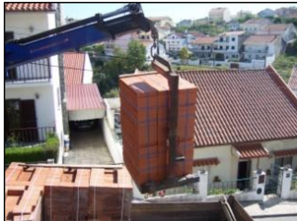
Fig.115 - Elevação mecânica com grua
