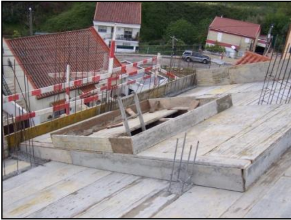
Fig.78 - Cofragem da claraboia
