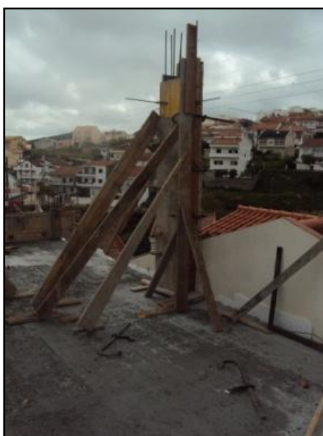
Fig.76 - Cofragem de pilar de bordadura em que assenta a laje de cobertura
