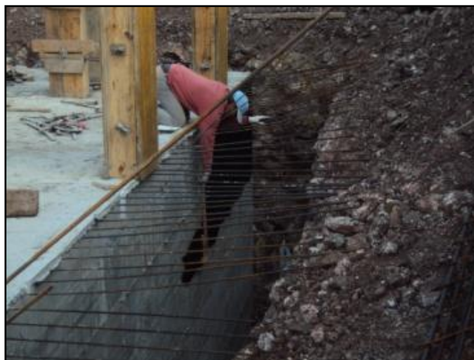
Fig.98 - Aplicação da emulsão betuminosa
