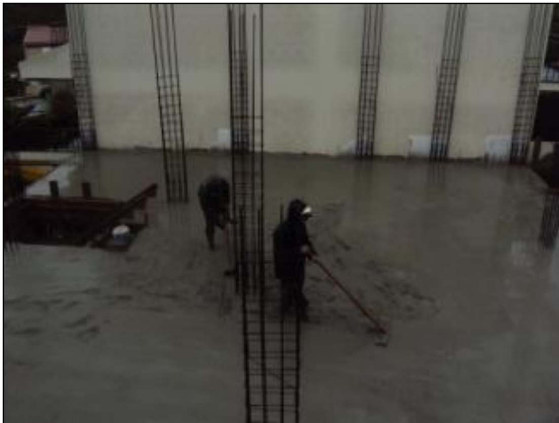
Fig.72 - Conclusão da betonagem da laje
