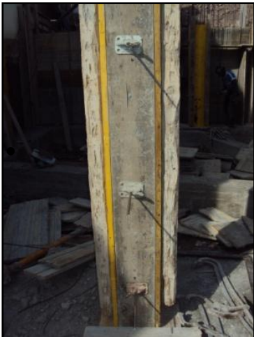
Fig.43 - Castanhas de cofragem
