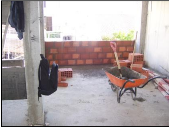
Fig.110 - Pano exterior com 1 m de altura
