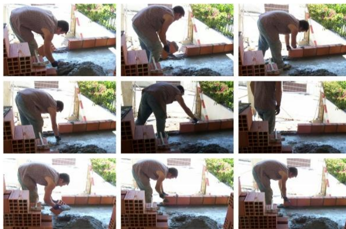
Fig.109 - Assentamento de uma fiada de tijolos
