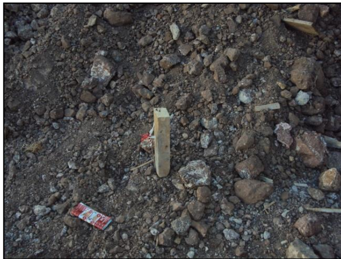
Fig.14 - Estaca cravada manualmente no terreno
