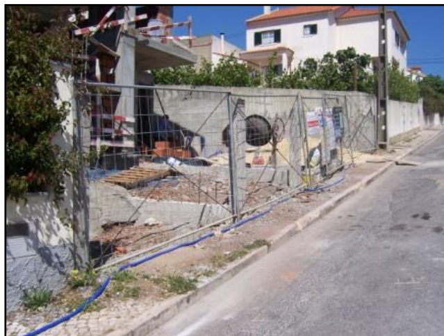
Fig.140 - Vedação em rede electrosoldada
