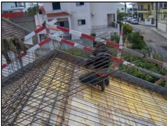
Fig.85 - Armaduras em espera (Viga – Pórtico 3)
