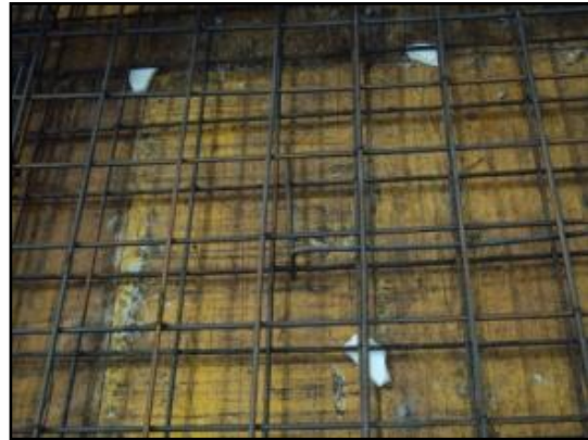
Fig.61 - Recobrimento da laje
