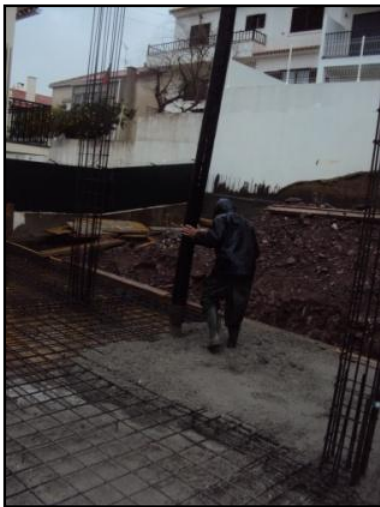
Fig.69 -Betonagem da laje
