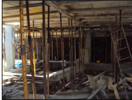
Fig.58 - Escoramento do teto da cave
