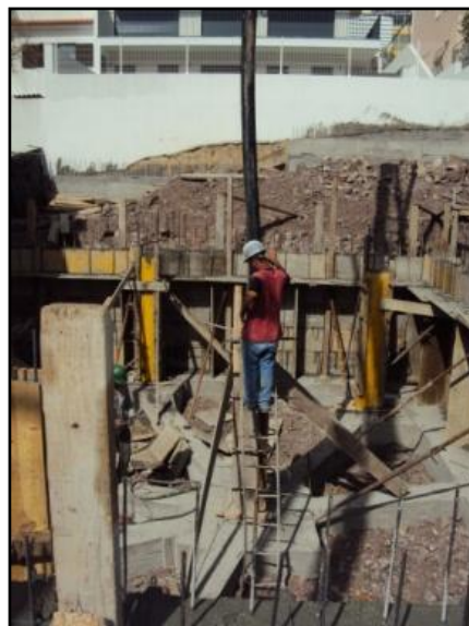
Fig.53 - Betonagem dos pilares da cave
