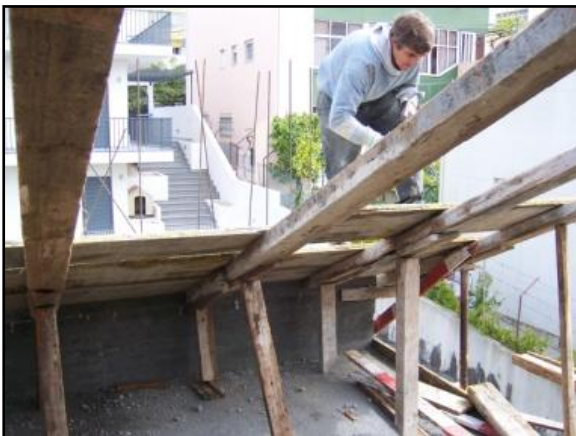
Fig.80 - Cofragem da laje de cobertura
