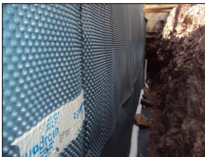
Fig.99 - Fixação da tela drenante vertical
