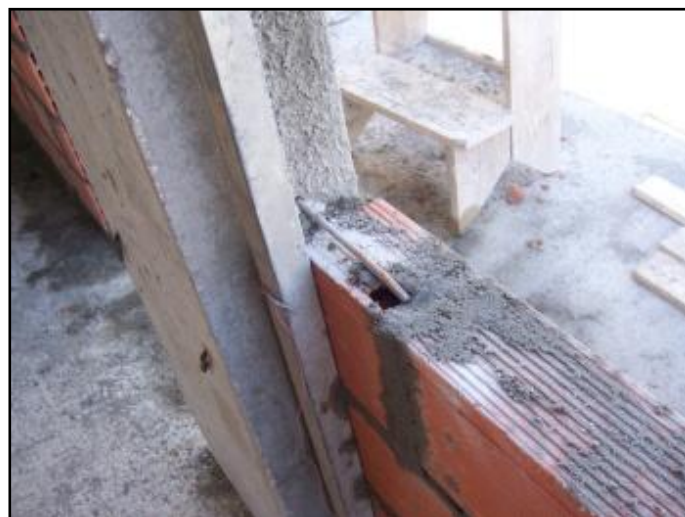
Fig.112 - Cravação de varão de aço em pilar
