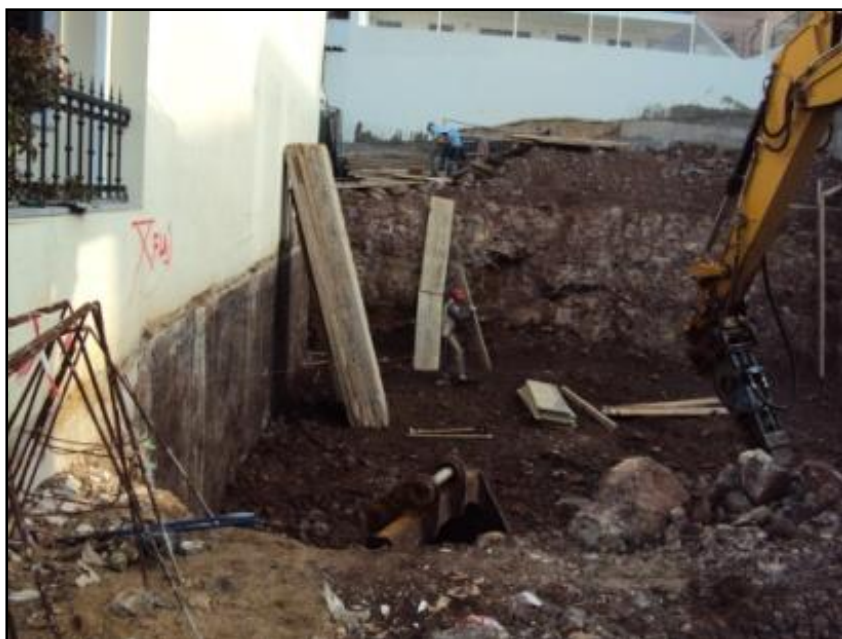
Fig.143 - Trabalhos de escavação e cofragem das fundações a ocorrerem em simultâneo
