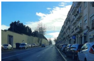
Rua Morais Soares (Poente / Nascente) (km 3+600)
