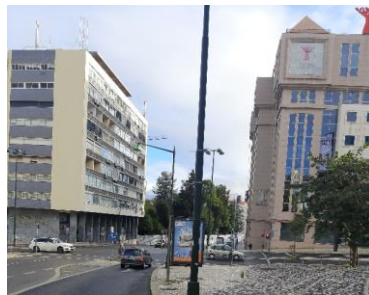
Rua Marquês da Fronteira (Poente / Nascente) (km 1+050)
