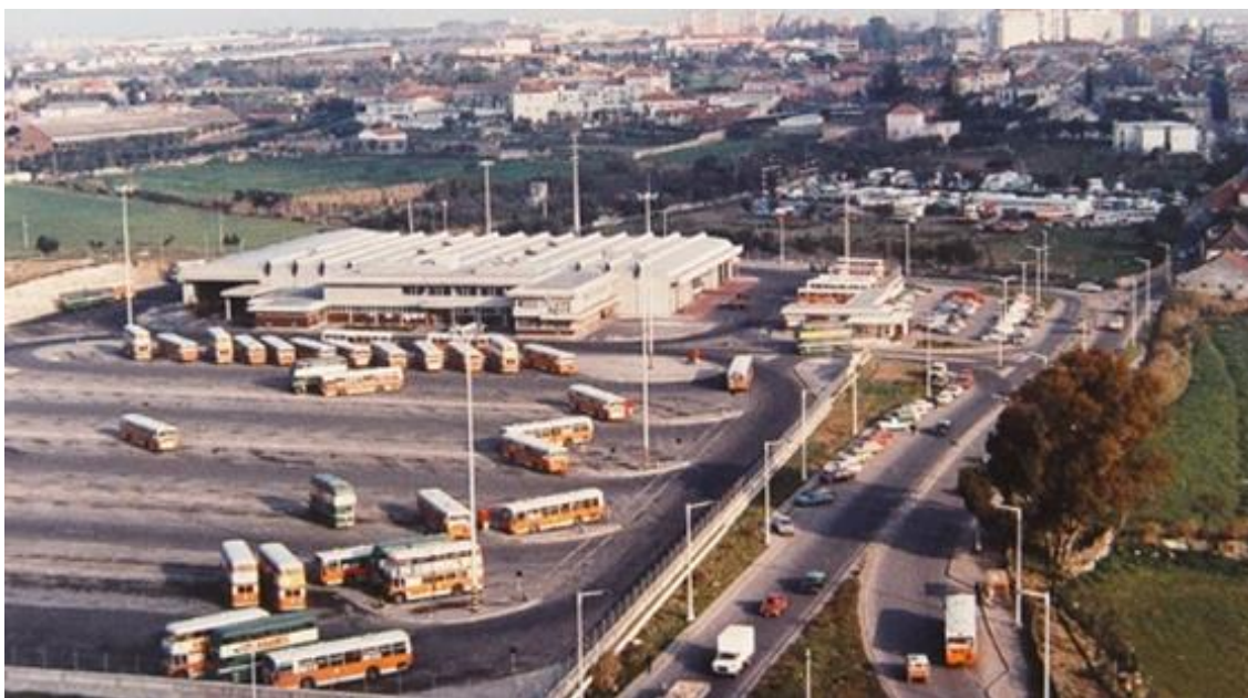
Figura 2.12 – Construção da estação da Pontinha [9]
