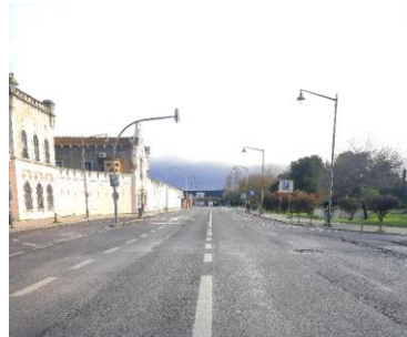
Rua Marquês da Fronteira (Poente / Nascente) (km 0+500)
