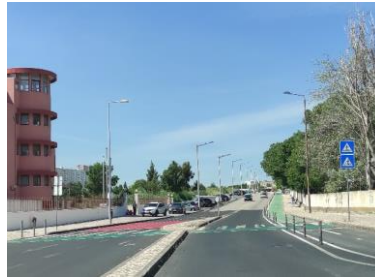
Rua Eng.º Ferreira Dias (Sul / Norte) (km 4+650)
