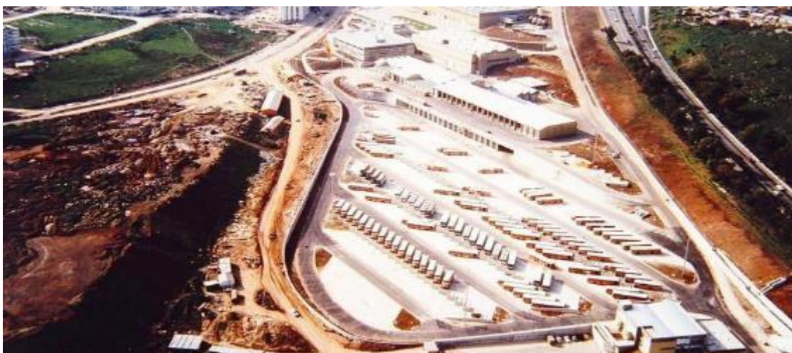
Figura 2.13 – Construção do complexo de Miraflores [9]
