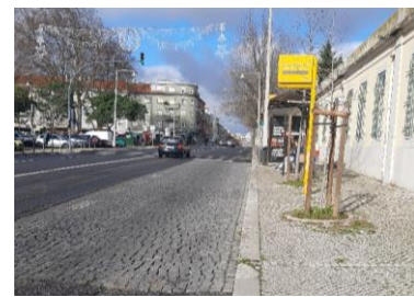
Final da Rua Morais Soares (Nascente / Poente) (km 4+200)
