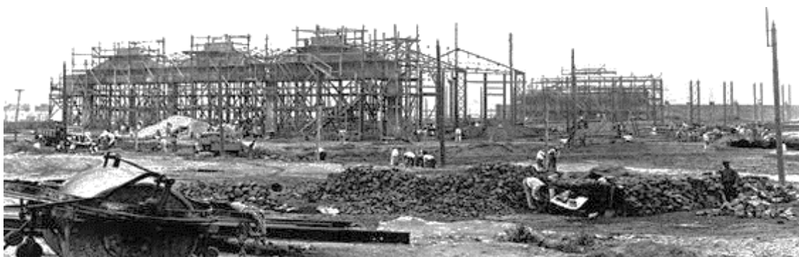
Figura 2.8 – Construção da Estação das Amoreiras [9]
