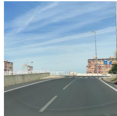
Entrada na Rotunda da Bela Vista (Ponte / Nascente) (km 3+700)
