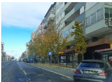
Av.ª de Roma (Sul / Norte) (km 1+600)
