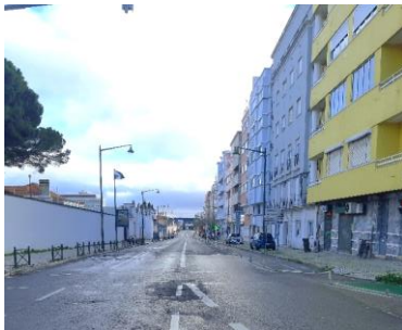
Rua Marquês da Fronteira (Poente / Nascente) (km 0+300)
