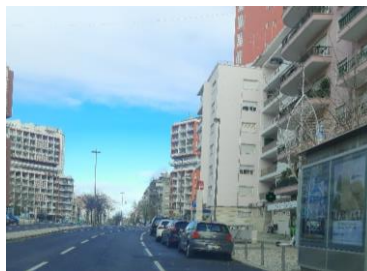
Av.ª de Roma (Sul / Norte) (km 1+750)
