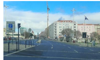
Av. a Manuel da Maia / Alameda D. Afonso Henriques (Sul / Norte) (km 0+400)
