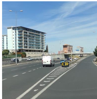
Av. a Marechal António de Spínola, acesso à Rotunda da Bela Vista (Ponte / Nascente) (km 3+350)
