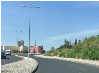
Rua Eng.º Ferreira Dias (Sul / Norte) (km 4+450)
