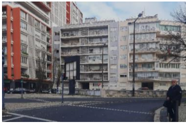
Av.ª de Roma, Cruzamento com Av.ª EUA (Poente / Nascente) (km 1+900)
