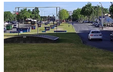
Av.ª Dr. Augusto de Castro – Estação do Metro e acesso à Estação de Cabo Ruivo (Sul / Norte)
