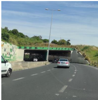
Av. a Marechal António de Spínola – Túnel (Ponte / Nascente) (km 3+200)
