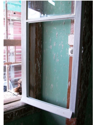
FIG. 3.30 - Recuperação de vãos existentes (carpintaria)
