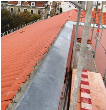
FIG. 3.35 - Capeamentos em zinco.
