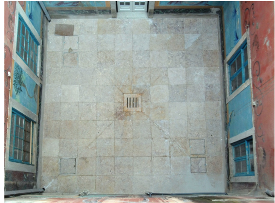
FIG. 3.48 - Finalização do saguão interior.
