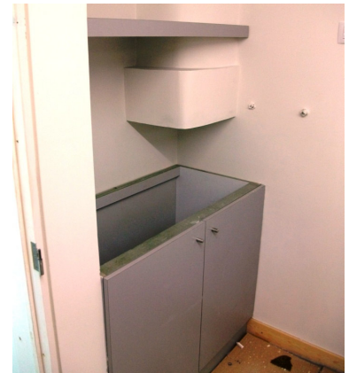
FIG. 3.36 - Execução de carpintarias diversas.
