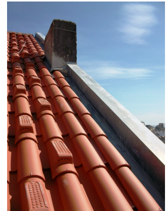
FIG. 3.50 - Colocação das telhas passadeira.
