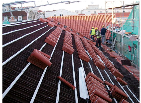
FIG. 3.23 - Aplicação do OSB, isolamento, sub-telha e telha
