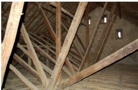
FIG. 2.6 - Vista interior da cobertura do Corpo A: forro e estrutura de suporte em madeira.
