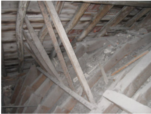
FIG. 2.10 – Estrutura do tecto abobadado do ginásio.
