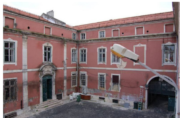
FIG. 2.3 - Fachada Norte (à esquerda) e Nascente (à direita) do corpo A.
