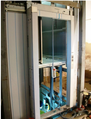
FIG. 3.28 - Montagem do elevador
