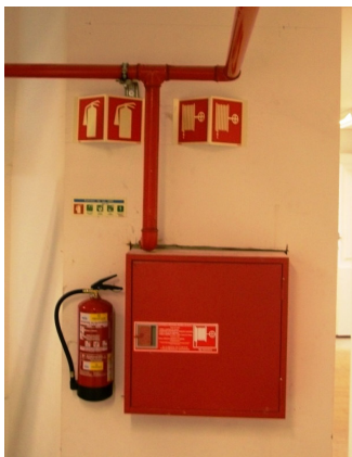
FIG. 3.37 - Montagem da rede de incêndios, carretéis e respectivas ligações.
