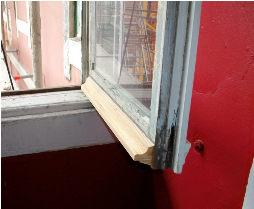
FIG. 3.14 - Reparação de vãos exteriores
