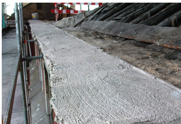
FIG. 3.12 - Consolidação de Coroamentos
