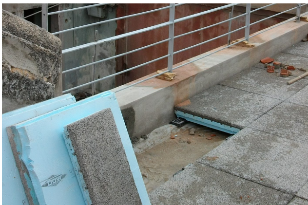
FIG. 3.31 - Impermeabilização e colocação de lajetas no terraço técnico
