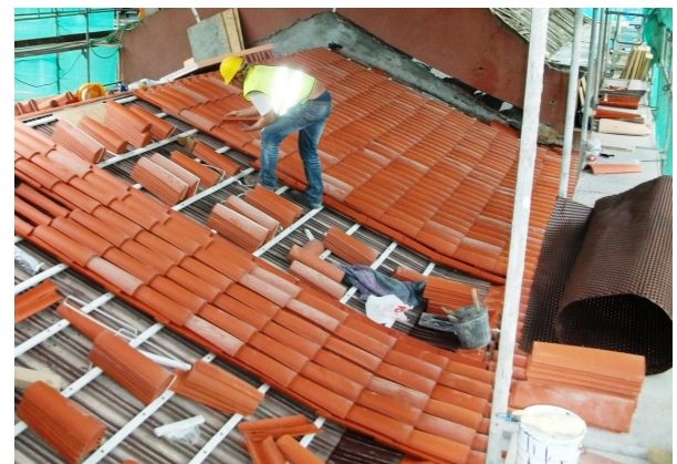
FIG. 3.19 - Telhagem da cobertura, Corpo B
