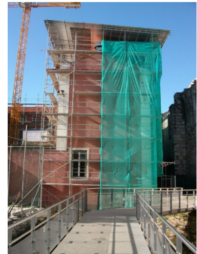
FIG. 3.2 - Montagem da cobertura provisória no Corpo B.
