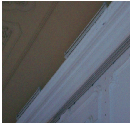
FIG. 3.29 - Enfiamento de cabos e montagem de iluminação
