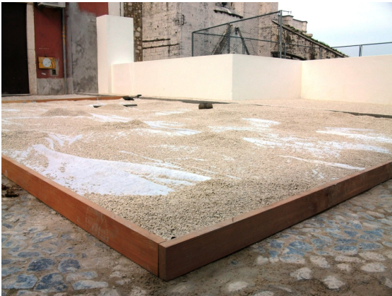
FIG. 3.49 - Execução da caixa de areia de apoio à exposição.
