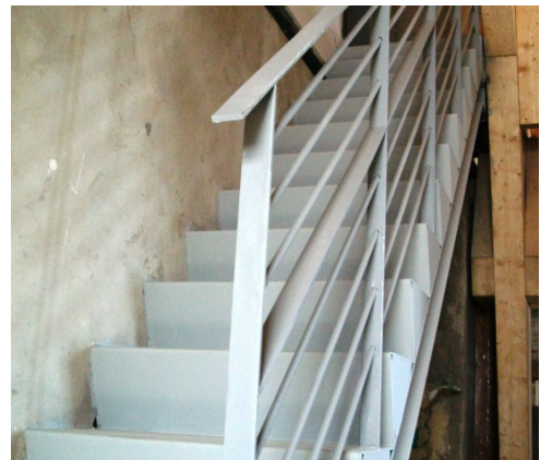
FIG. 3.42 - Pintura da escada metálica interior.
