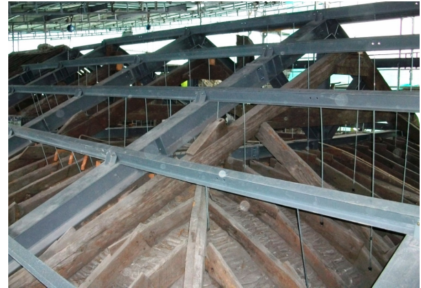
FIG. 3.17 - Sistema de suspensão dos tectos a manter
