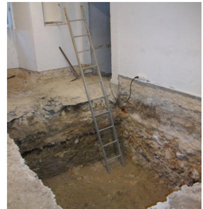
FIG. 3.9 - Abertura de sapata para estrutura do elevador
