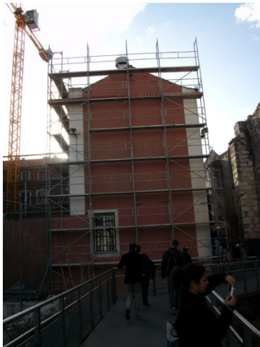
FIG. 3.1 - Montagem de andaimes para a cobertura provisória.
