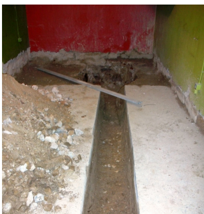
FIG. 3.10 - Abertura de valas para saneamento para futuras instalações sanitárias
