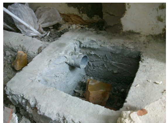
FIG. 3.27 - Montagem das instalações para drenagem de águas residuais.
