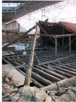
FIG. 3.6 – Destelhagem e demolição da cobertura do Corpo A
