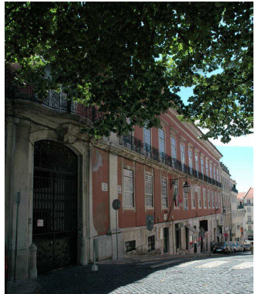
FIG. 2.1 - Fachada Poente, Calçada do Sacramento.
