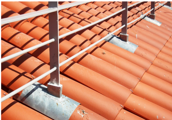
FIG. 3.41 - Finalização da montagem da guarda metálica da cobertura e respectiva impermeabilização.
