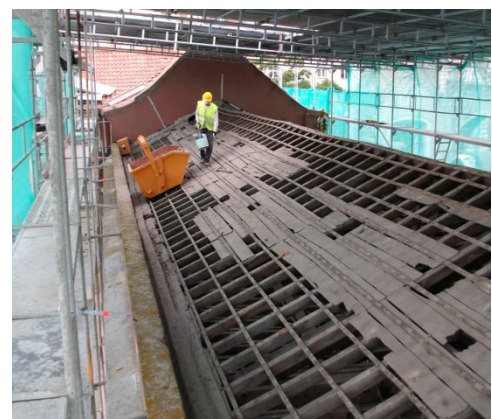
FIG. 3.4 - Remoção de ripados da cobertura do Corpo B.
