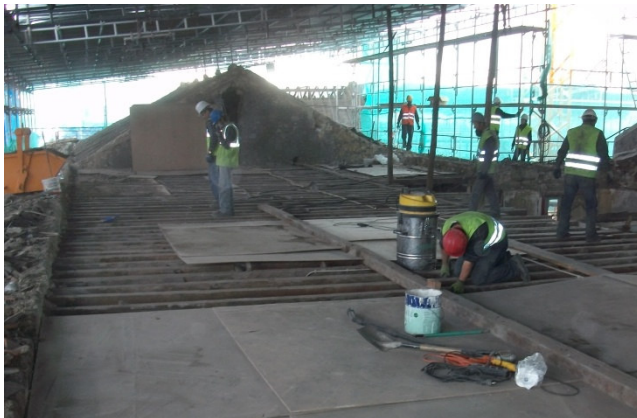
FIG. 3.8 – Limpeza de extradorso de tectos a manter
