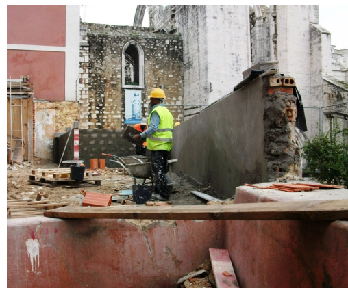
FIG. 3.40 - Demolição e construção do muro limite do pátio exterior.
