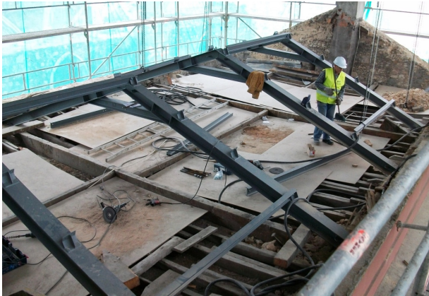
FIG. 3.16 - Montagem da estrutura metálica da cobertura, Corpo B
