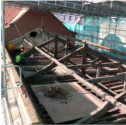
FIG. 3.5 – Limpeza e preparação para recepção da cobertura metálica
