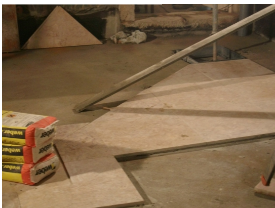
FIG. 3.39 - Remoção, montagem de caixas e impermeabilização do pavimento do saguão interior.
