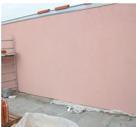
FIG. 3.33 - Montagem do sistema ETICS - solução do género "capoto".
