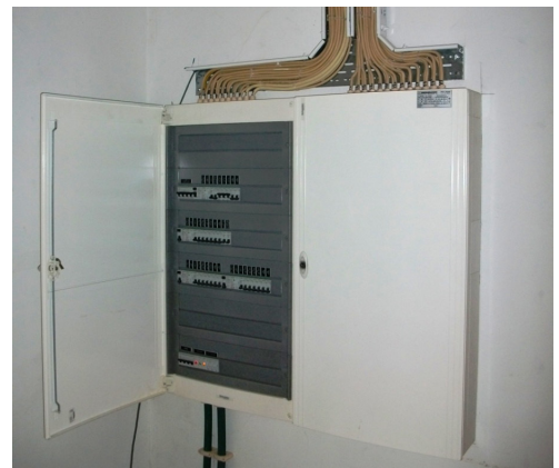
FIG. 3.38 - Montagem dos quadros eléctricos.
