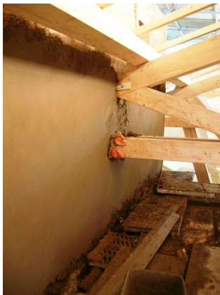
FIG. 3.24 - Regularização das empenas existentes na cobertura
