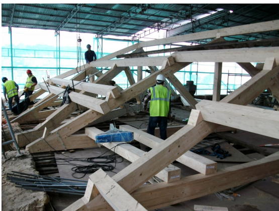
FIG. 3.18 - Montagem das asnas em madeira, Corpo A
