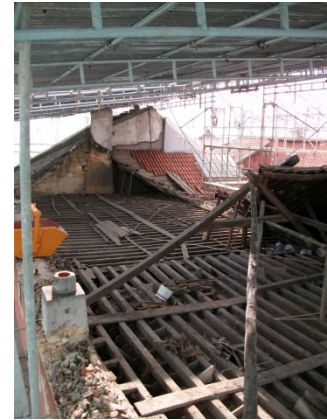
FIG. 3.7 – Remoção da estrutura do telhado, Corpo A
