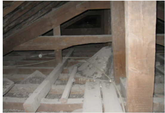
FIG. 2.11 - Estrutura do tecto abobadado do ginásio.
