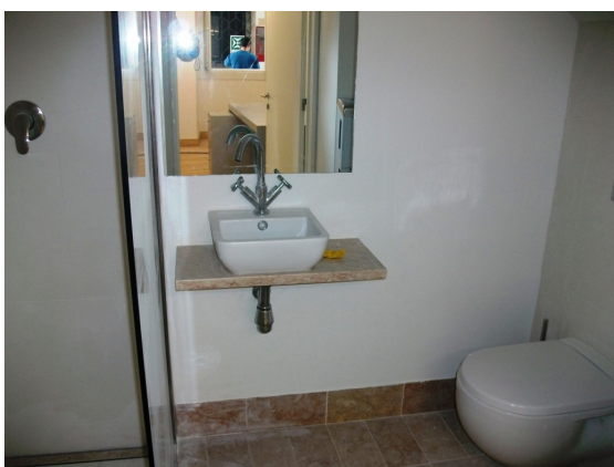
FIG. 3.45 - Montagem de acessórios das instalações sanitárias.
