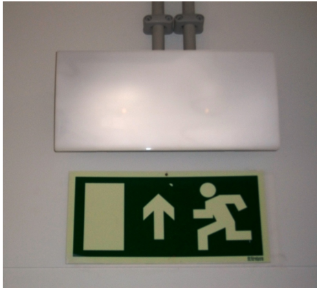
FIG. 3.47 - Montagem da sinalética de emergência.
