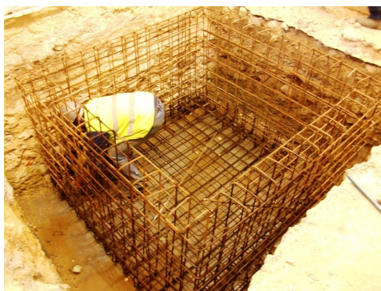
FIG. 3.13 - Montagem das armaduras da sapata do elevador
