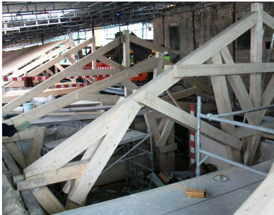
FIG. 3.22 - Montagem das asnas de madeira, Corpo A
