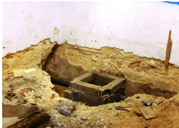
FIG. 3.21 - Montagem das instalações de drenagem de águas residuais
