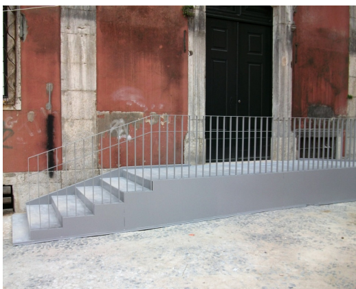
FIG. 3.43 - Montagem de rampas de acesso.
