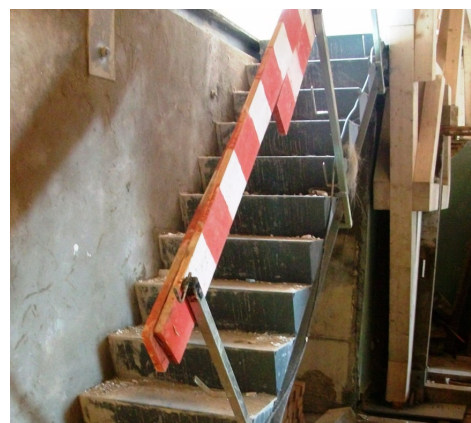
FIG. 3.32 - Montagem da escada metálica interior
