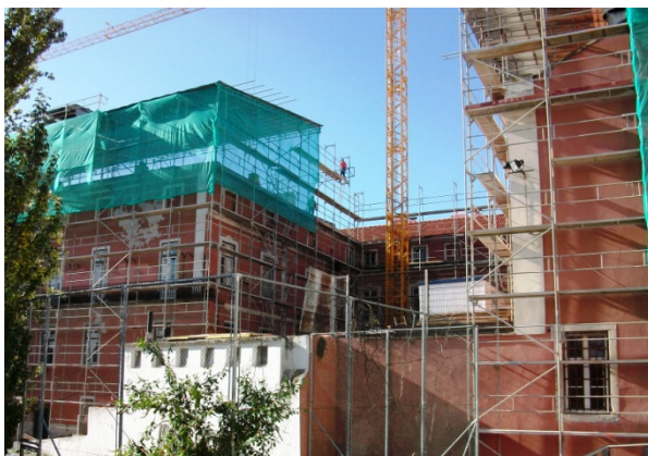
FIG. 3.3 - Montagem da cobertura provisória no Corpo A.
