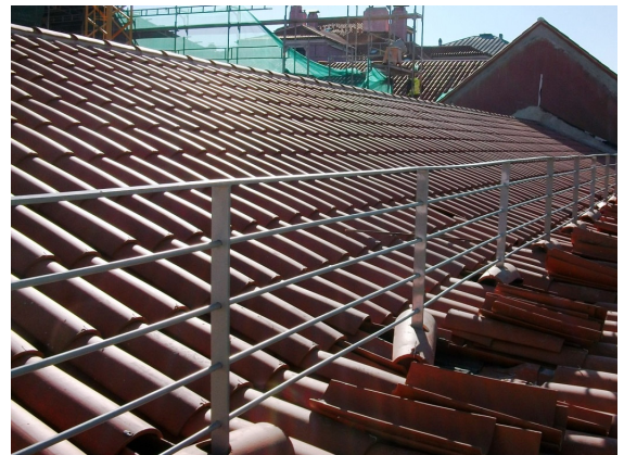
FIG. 3.25 - Montagem da guarda metálica
