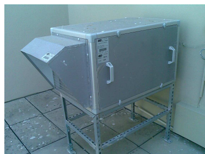
Figura 7: Ventilador de extracção I.S. (VE01)
