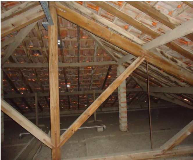
Figura 38 - Estrutura de madeira da cobertura
