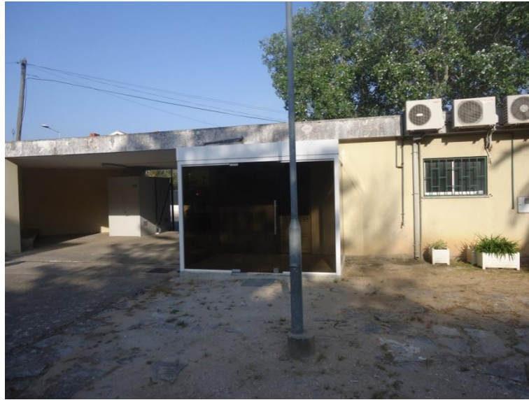
Figura 29 - Edifício da portaria (URAP)
