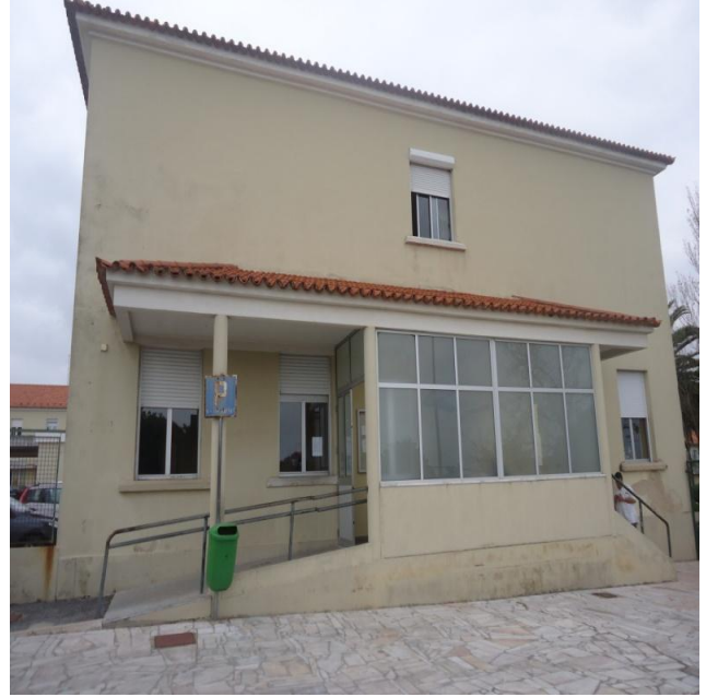
Figura 5 – Entrada lateral da UCSP da Parede
