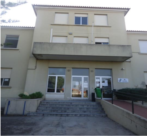
Figura 1 - Vista da fachada principal
