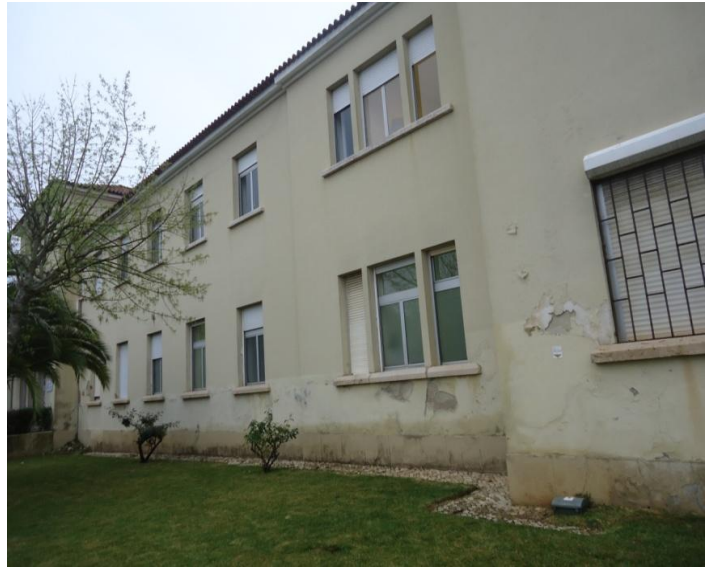
Figura 2 - Vista da fachada principal (ala direita)
