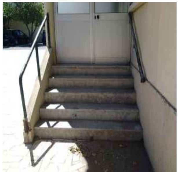
Figura 34 - Escadas de acesso ao edifício e corrimões metálicos
