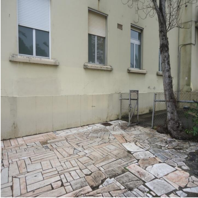
Figura 6 - Vista da fachada lateral esquerda
