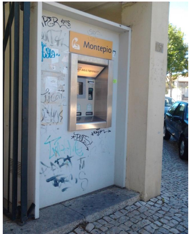
Figura 28 – Zona do multibanco (à entrada do edifício)
