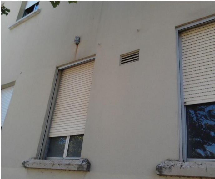
Figura 35 – Armadura na fachada a substituir
