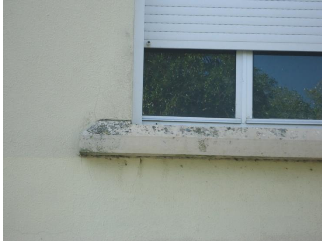
Figura 39 – Peitoril deteriorado
