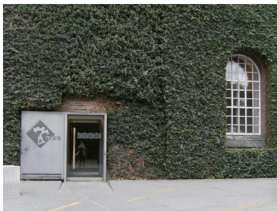
Figura 3.2 Exemplo de uma fachada verde instalada numa habitação particular na Golegã, Portugal (Manso & Castro-Gomes, 2015)
