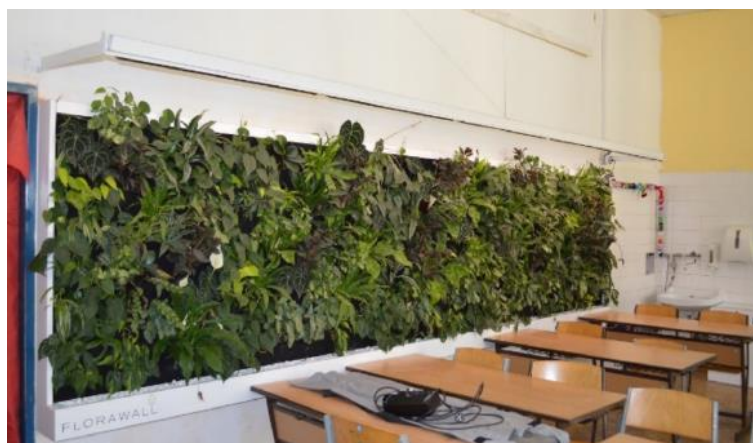
Figura 3.7 Parede verde instalada numa sala de uma escola em Viena, Áustria (Tudiwer & Korjenic, 2017)
